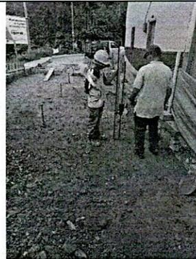
**Excavación para Cajeo e Instalación de material Sub Base**
