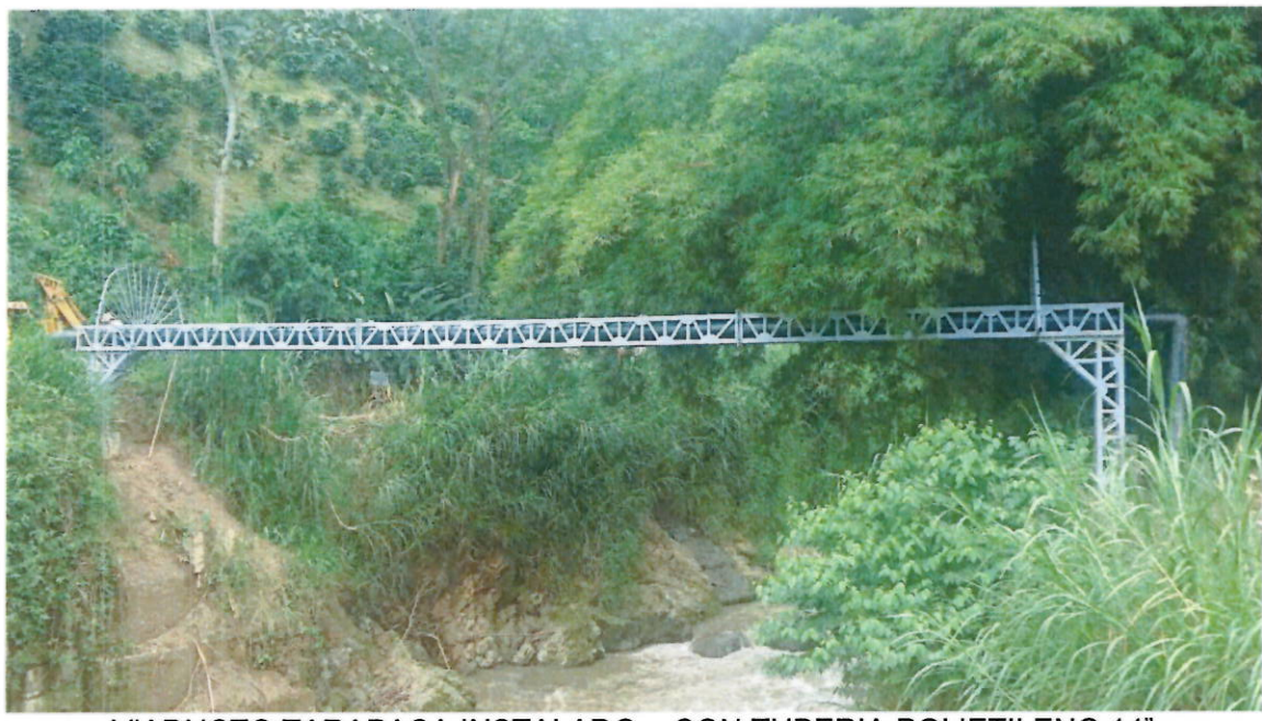
VIADUCTO TARAPACA INSTALADO – CON TUBERIA POLIETILENO 14”
