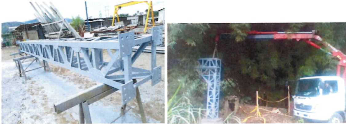
Proceso de alce de cercha para viaducto
