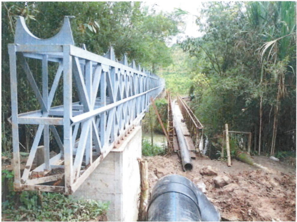
INSTALACION VIADUCTO LA PLAYA
