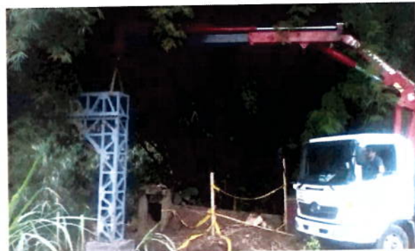
ENSAMBLE CERCHA – MONTAJE ESTRUCTURA EN SITIO
