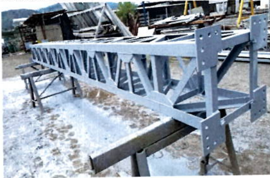
ENSAMBLE CERCHA – MONTAJE ESTRUCTURA EN SITIO
