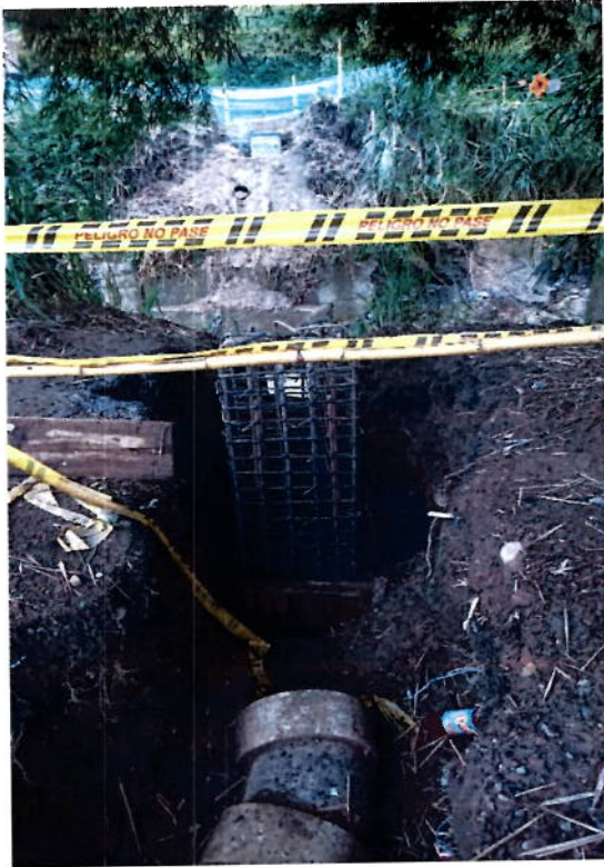
EXCAVACION PEDESTALES
