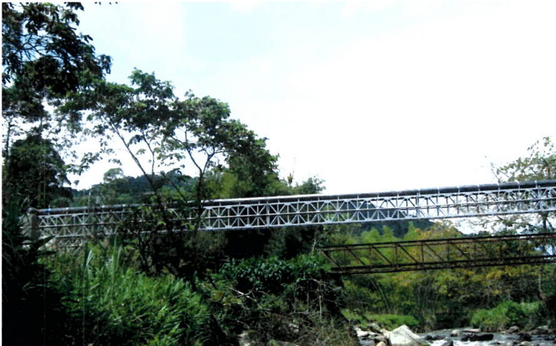
VIADUCTO RIO CAMPOALEGRE FINCA LA PLAYA
