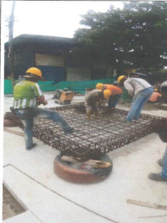
FIGURADO DE ACERO DE REFUERZO PARA TAPA DE CAMARAS CUADRADAS DE 2.4X2.4 M
