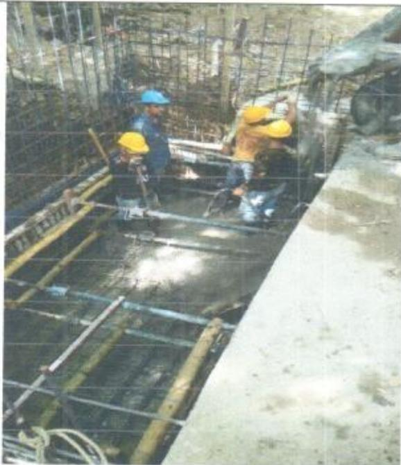
**FUNDICION CONCRETO PARA CONSTRUCCION DE BOX DE EMPALME**
