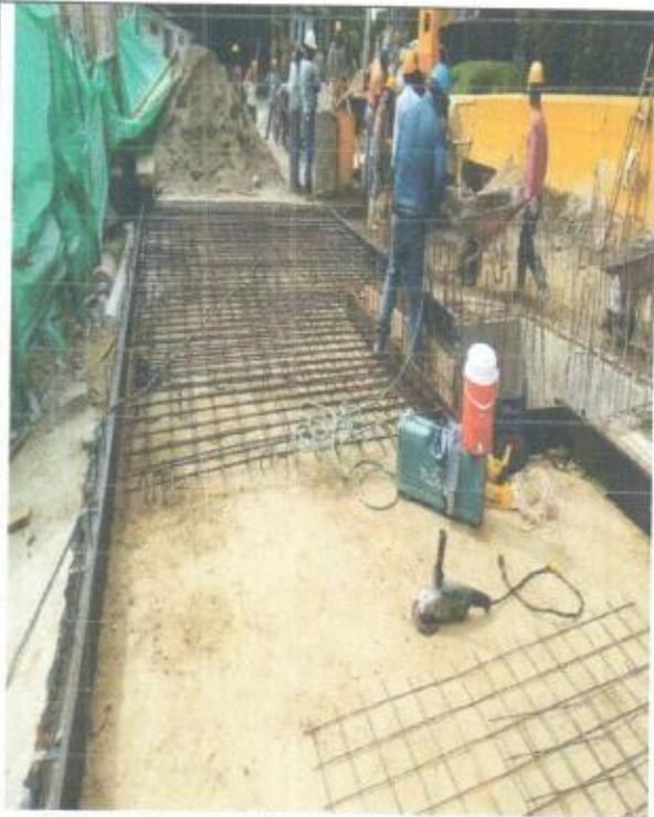
INSTALACION DE ACERO DE REFUERZO PARA LOSA
