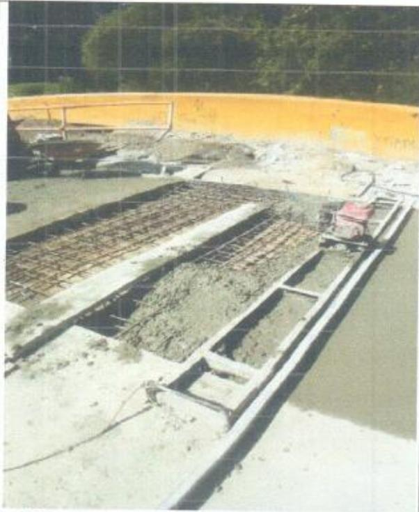
VIBRADO DE PAVIMENTO POR MEDIO MECANICO
