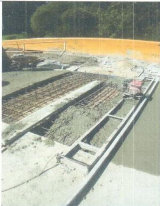
FUNDICION DE CONCRETO MR 42 PARA PAVIMENTO
