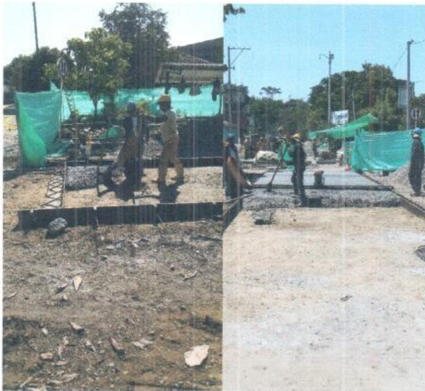
Foto 17 Y 18. Vaciado de losas de pavimento.
