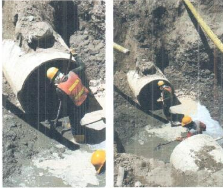
Fotos 6 y 7. Limpieza de Tuberías.
