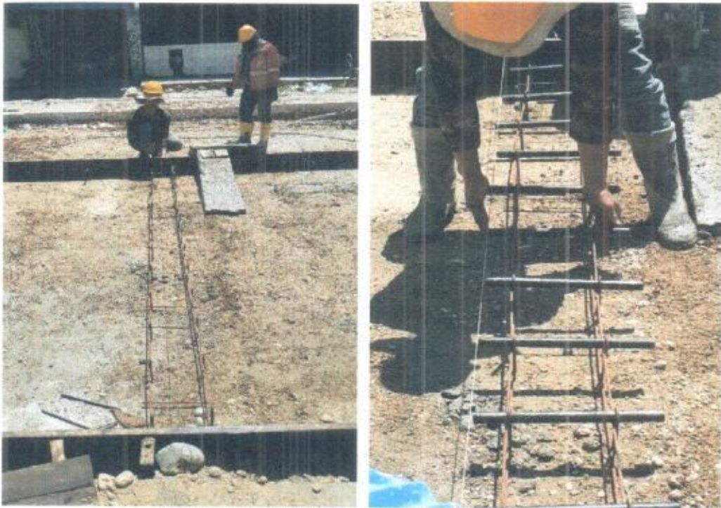
Foto 15 y 16. Instalación de dovela para pavimento
