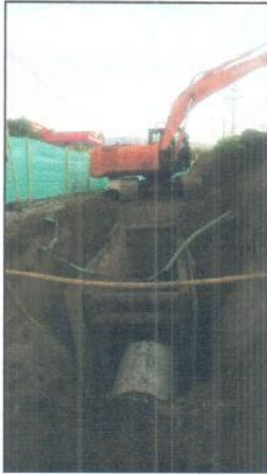
Fotos 2 y 3. Excavaciones y entibados para la instalación de tubería.
