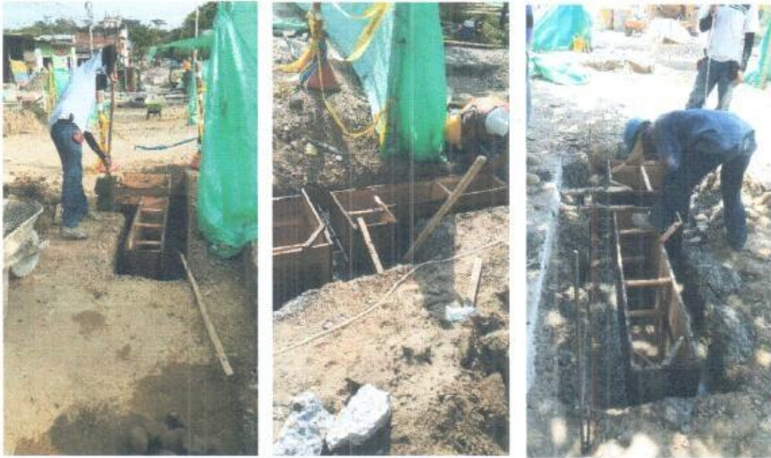
Foto 20, 21 y 22. Construcción de Sumideros
