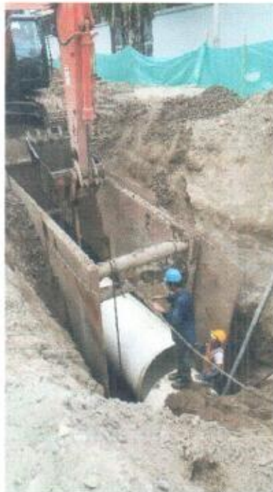
Fotos 4 y 5. Instalación de tuberías de 51 Pulgadas
