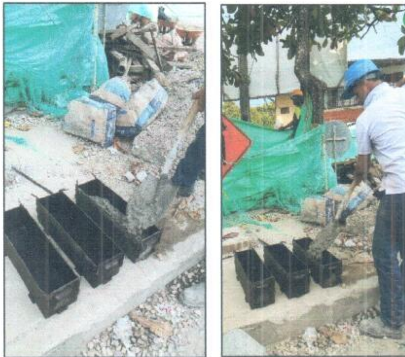
Foto 23 y 24. Toma de Viguetas para Ensayo de resistencia
