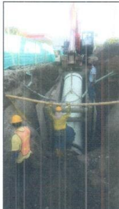
Fotos 4 y 5. Instalación de tuberías de 51 Pulgadas
