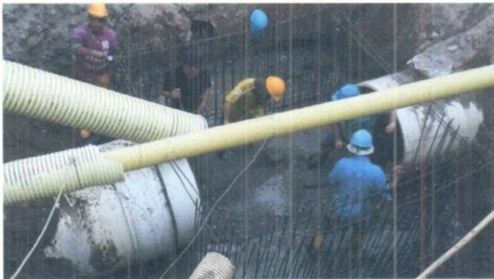
Foto 8. Armado acero de refuerzo y formaletas cámaras.
