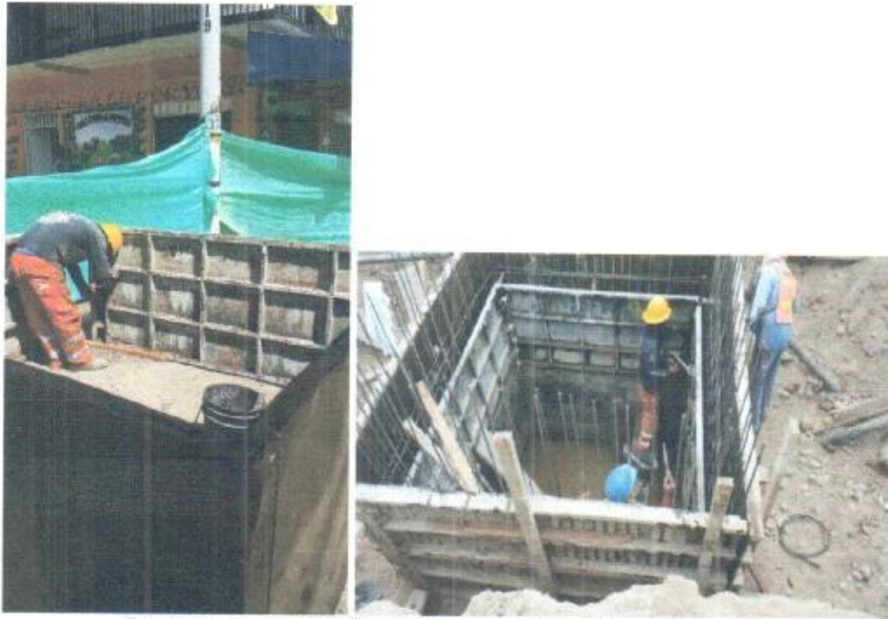
Fotos 9 y 10. Instalación de Formaletas para Fundir la cámara 7
