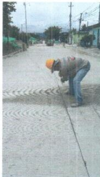
Foto 19. Instalación de sellos en la juntas.
