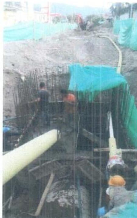
Foto 11. Vaciado concreto cámara 7
