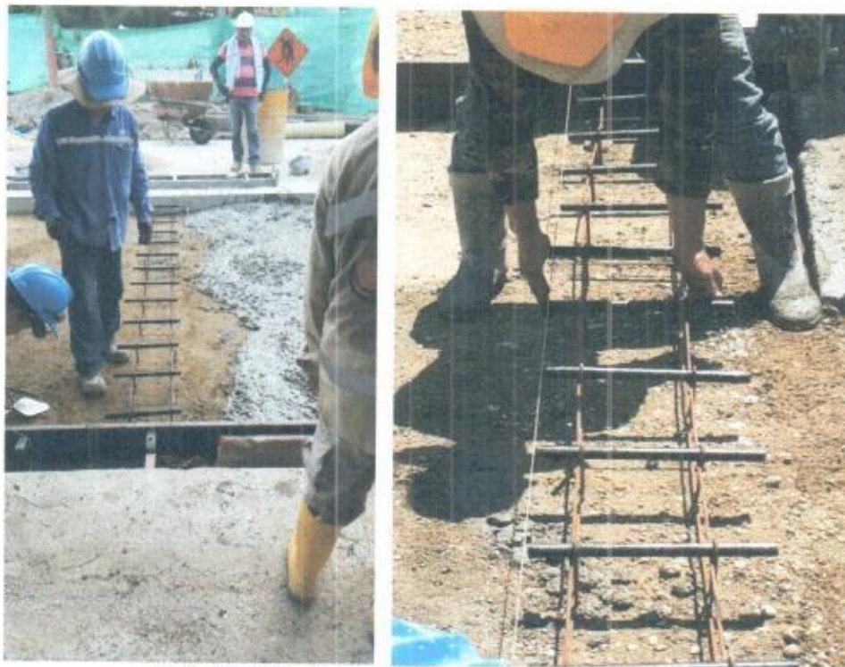
Foto 16 y 17. Instalación de dovela para pavimento
