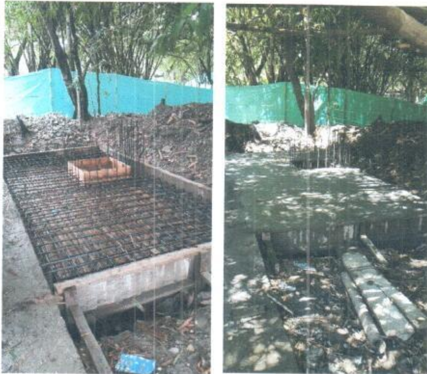
Foto 14 y 15. Construcción de la Tapa del Box del caño lava patas
