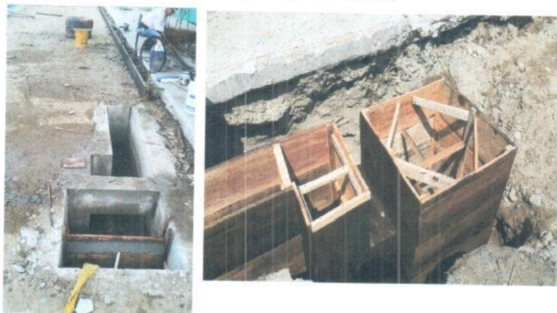
Foto 8 y 9. Armado de Formaletas y construcción de sumideros.
