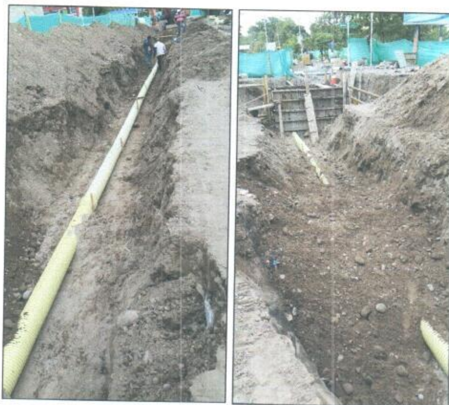
Foto 12 y 13. Instalación de tubería de 12"
