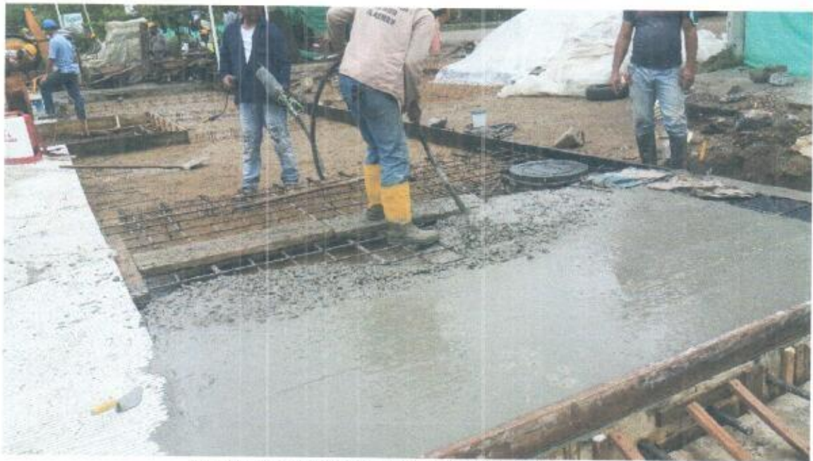
Foto 17 Y 18. Vaciado de losas de pavimento.
