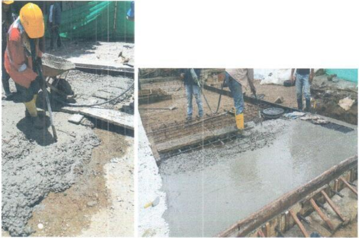
Foto 17 Y 18. Vibrado de la mezcla del pavimento de concreto.
