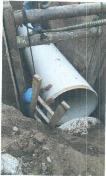
Fotos 4 y 5. Instalación de tuberías de 48" Pulgadas
