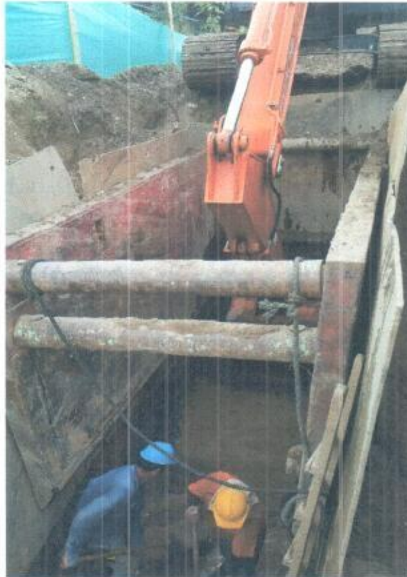
Foto 1. Instalación de Entibado para tubería de 48"
