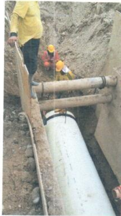
Fotos 4 y 5. Instalación de tuberías de 48" Pulgadas
