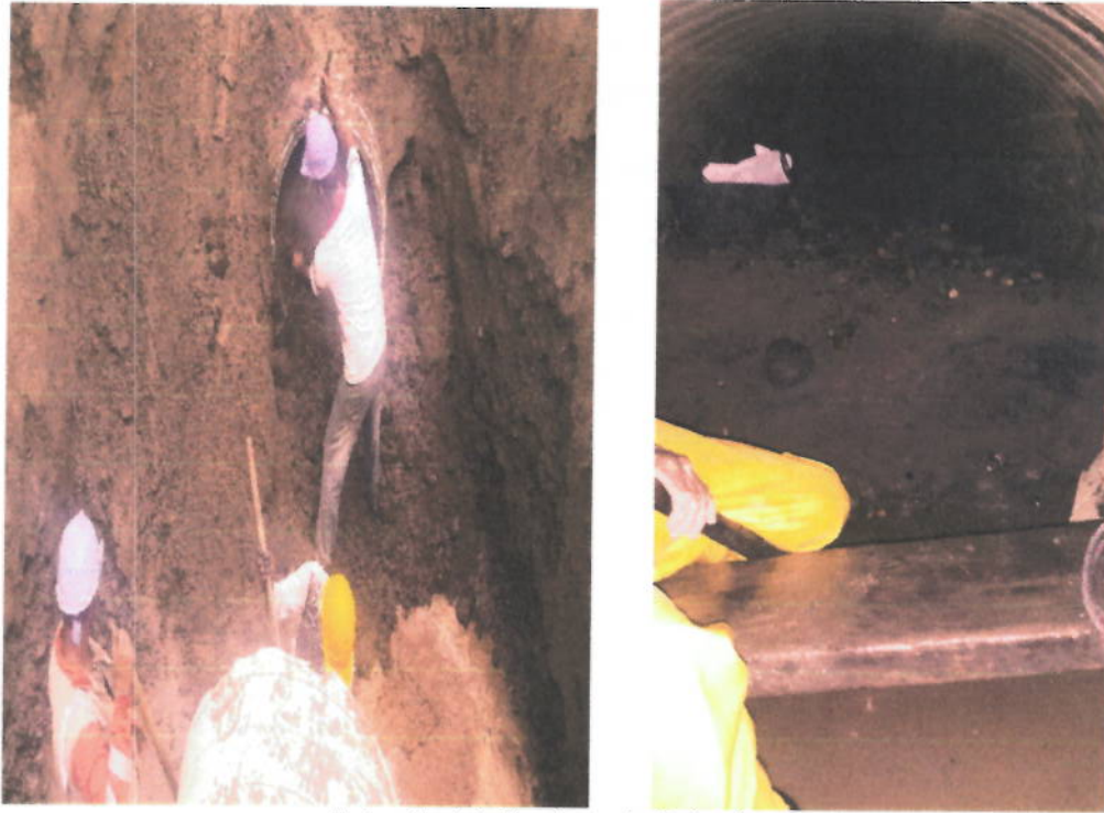
Fotos 6 y 7. Limpieza de Tuberías.
