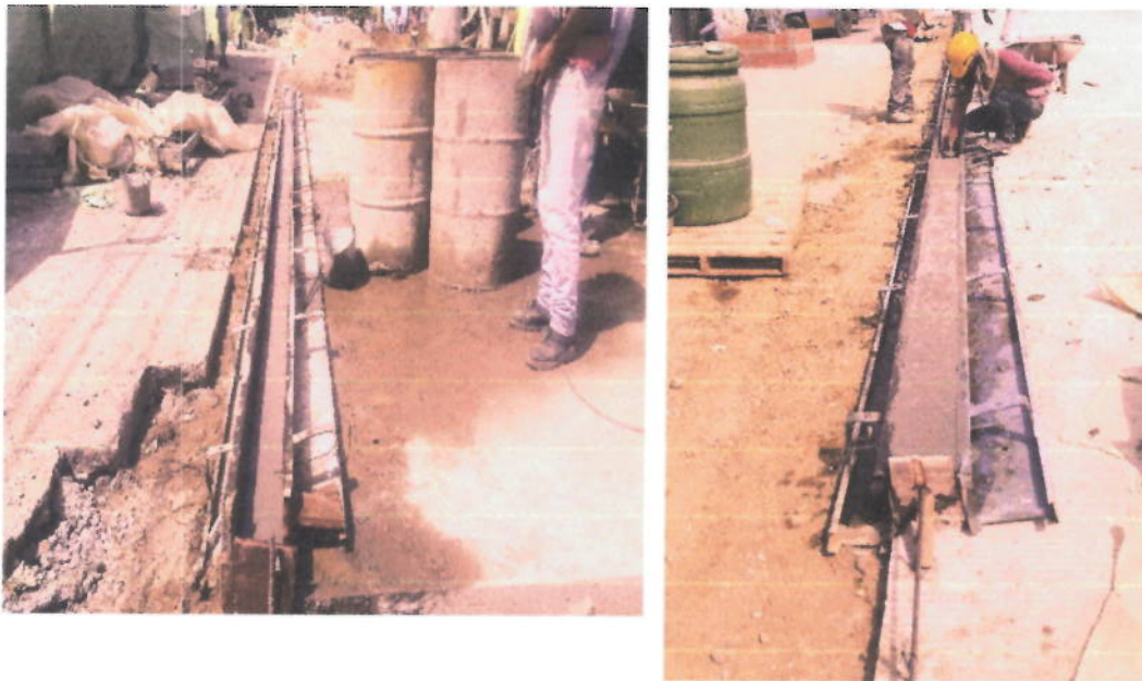
Foto 12 y 13. Construcción de Sardineles
