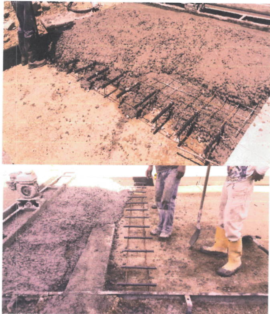
Foto 14 y 15. Instalación de dovela para pavimento
