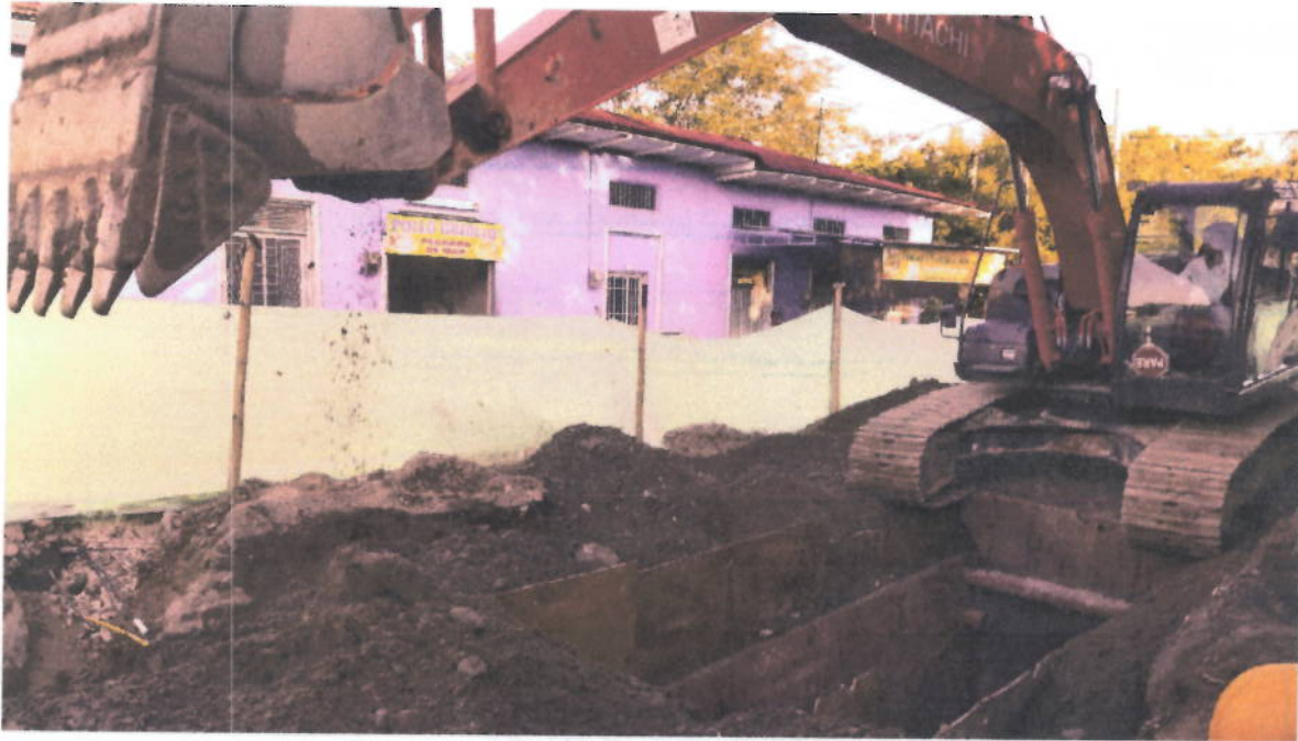
Foto 1. Instalación de Entibado para la tubería
