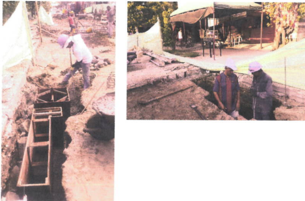
Foto 8 y 9. Armado de Formaletas y construcción de sumideros.
