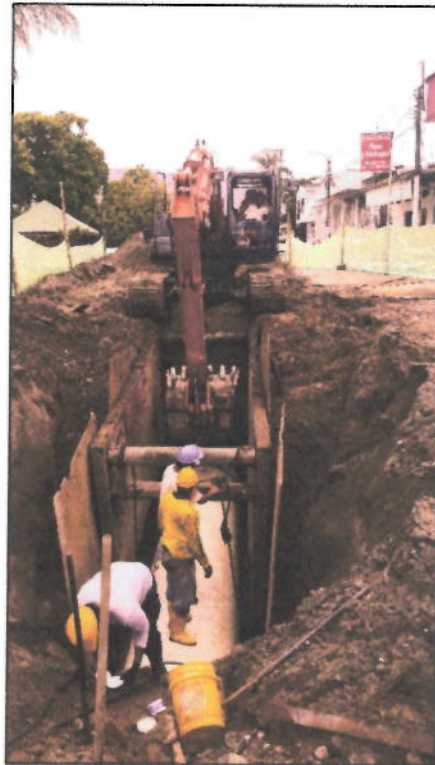
Fotos 4 y 5. Instalación de tuberías de 48" Pulgadas
