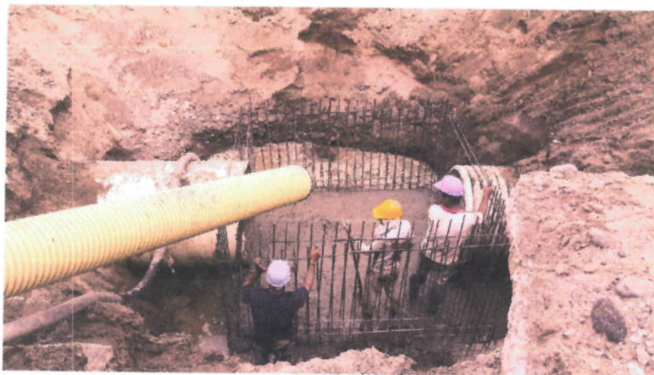
Foto 22, 23 y 24. Construcción de Cámara 5 y 4A
