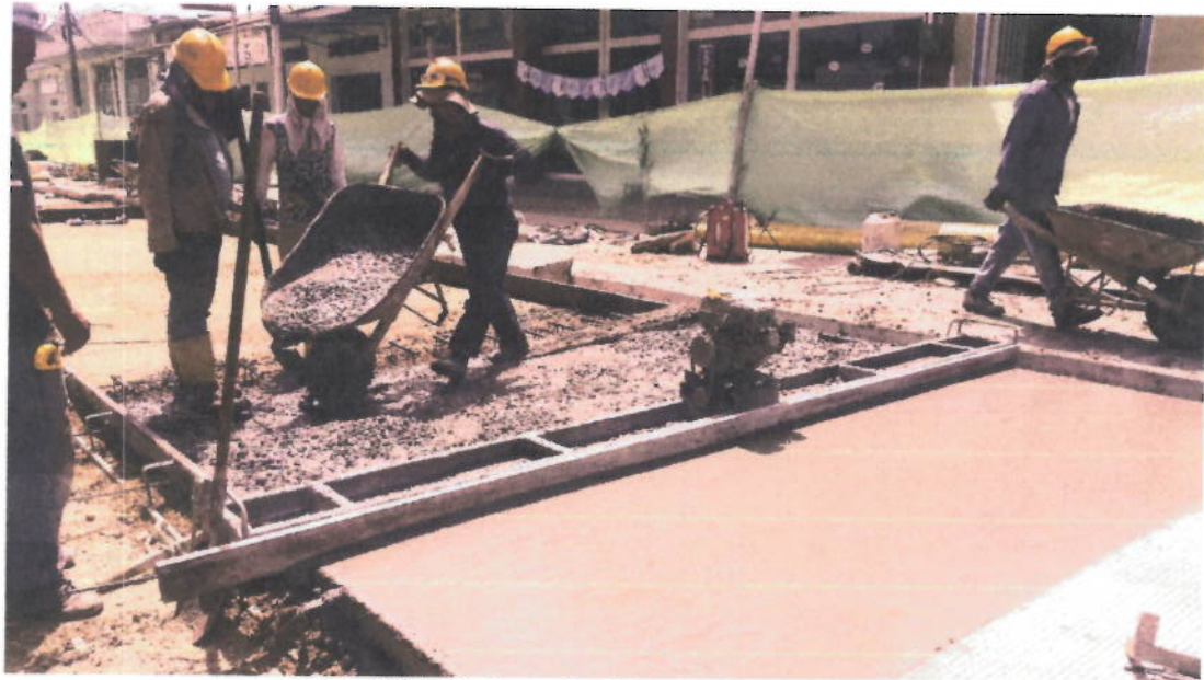
Foto 16 Y 17. Vaciado de losas de pavimento.
