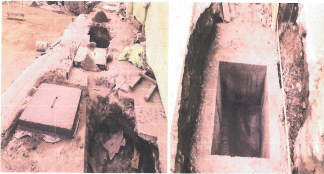
Fotos 10 y 11. Construcción de cámaras y redes domiciliarias
