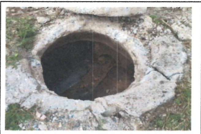
Camaras de inspeccion Existentes a Demoler
