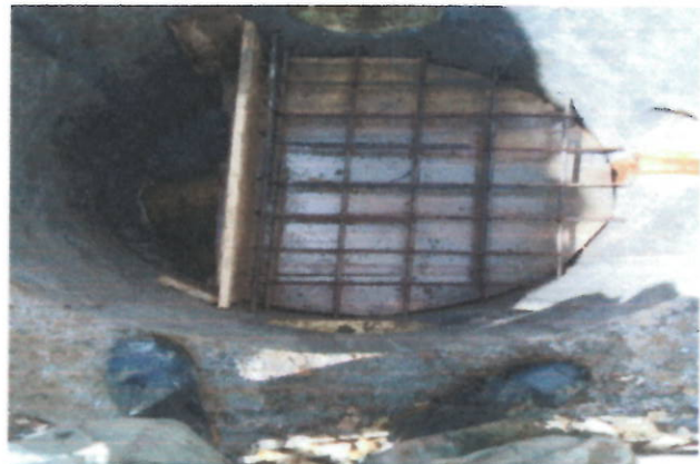
Proceso Constructivo camara de aliviadero
