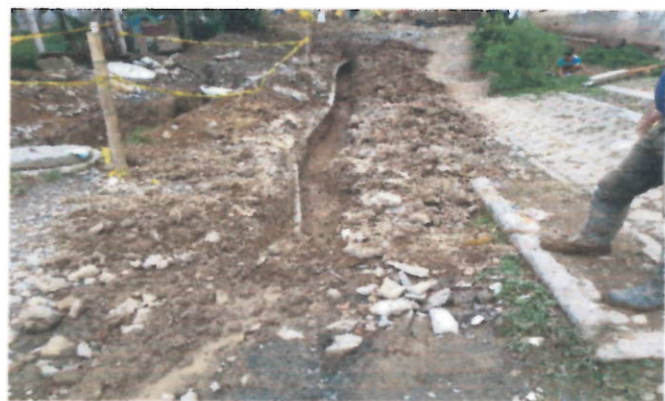
Excavacion para profundizar tuberia de acueducto de 3"
