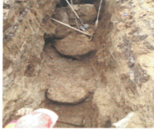
Rocas de Gran Tamaño en la excavacion
