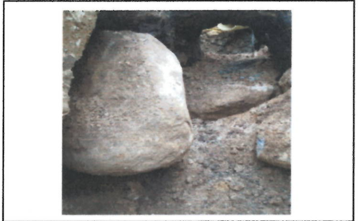
Rocas de Gran Tamaño en la excavacion
