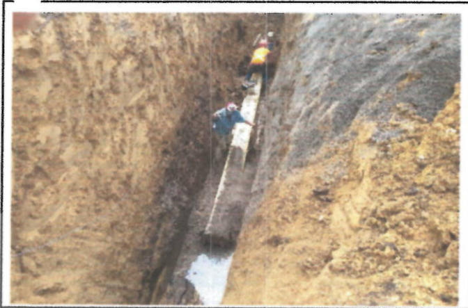
Cama de arena cubriendo el tubo
