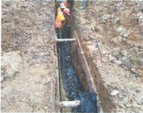
Construccion de filtro Frances para manejo de Nivel freatico
