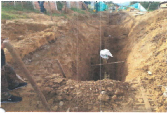
Instalacion de acometidas de alcantarillado
