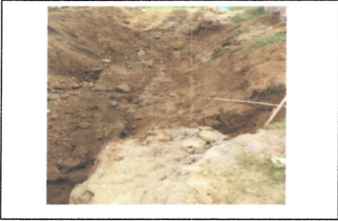
Inicio excavacion en V, profundidad 4,30 mts
