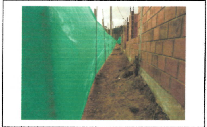
Adecuacion de paso peatonal
