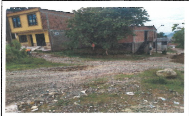
Estado de las vias antes de la intervencion
