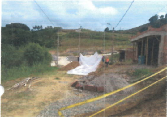
Proceso Constructivo techo provisional en plastico
