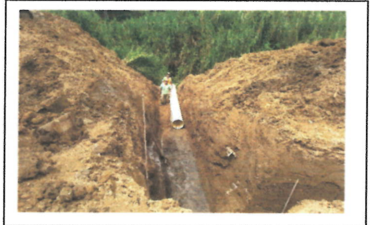
instalacion tuberia de 18" hacia cauce cameguadua
