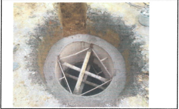
Construccion camara de inspeccion N2
