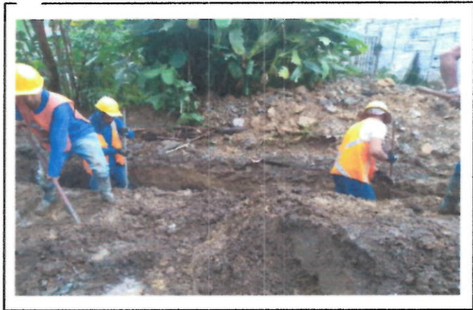
Excavacion de Brechas
