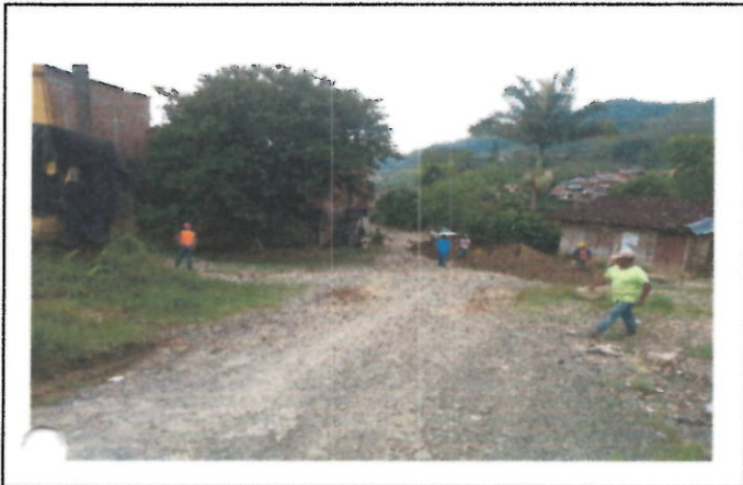
Estado de las vias antes de la intervencion
