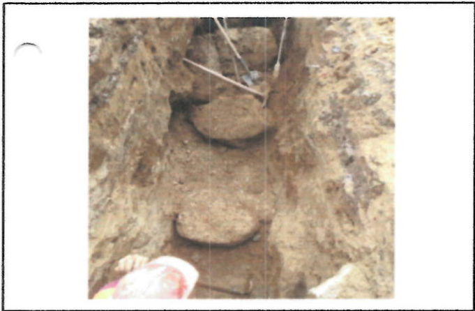
Rocas de Gran Tamaño en la excavacion
