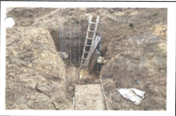
Construccion Camara de aliviadero
