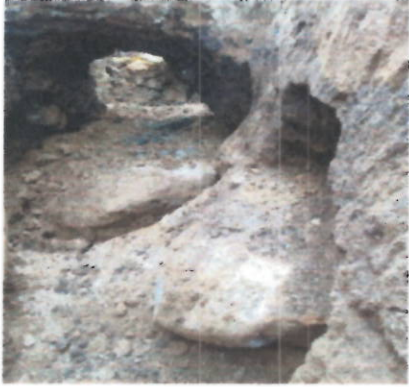
Rocas de Gran Tamaño en la excavacion
