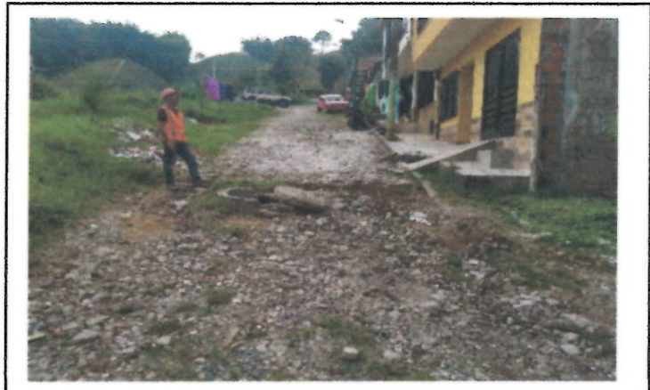
Camaras de inspeccion Existentes a Demoler
