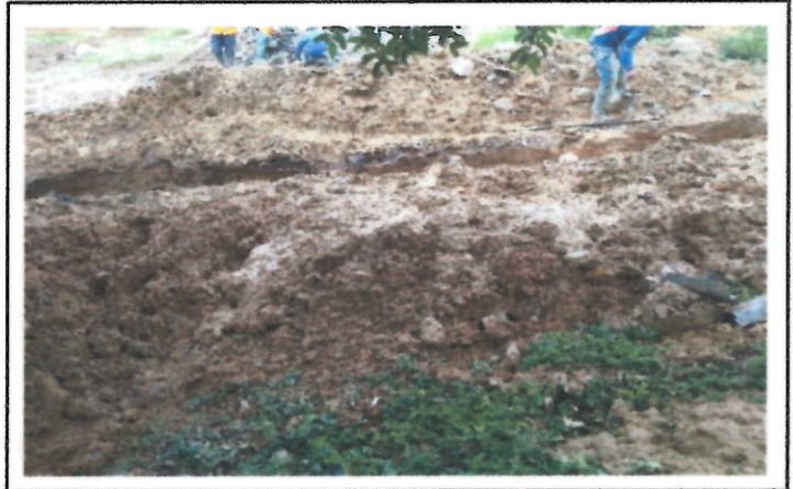
Material producto de la Excavacion Alto Nivel Freatico
