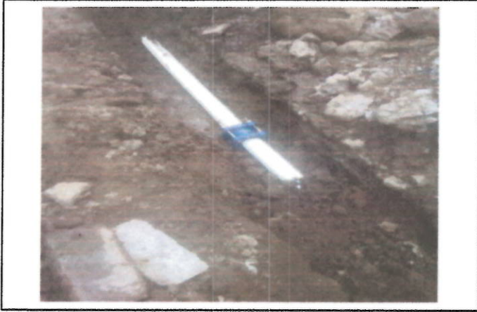
Empalme realizado por personal de Empocaldas
