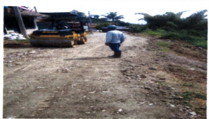
Conformacion de la via intervenida Calle 6A
