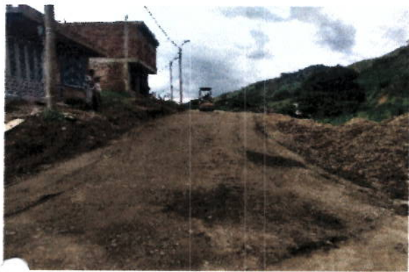
Conformacion de la via intervenida Calle 6A
