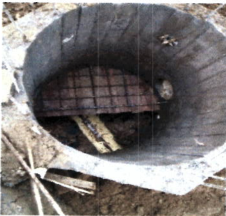
Construccion estructura de rebose del aliviadero
