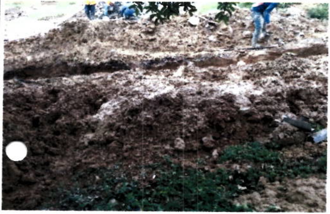
Material organico retirado de la excavacion
