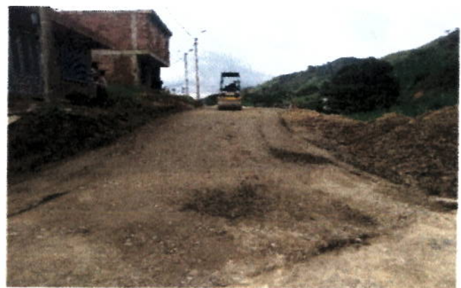
Conformacion de la via intervenida Calle 6A
