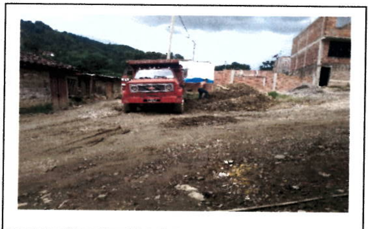
Retiro de Escombros
