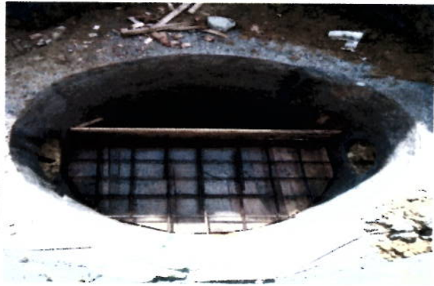
Conformacion losa para estructura de rebose
