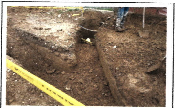
Excavacion cajas domiciliarias
