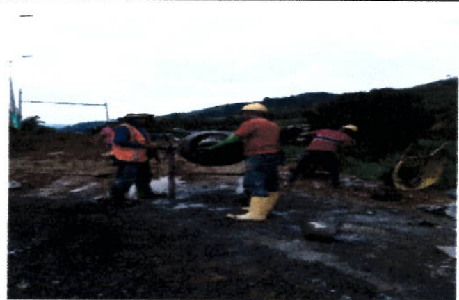
Mezcladora empleado durante el desarrollo de la obra
