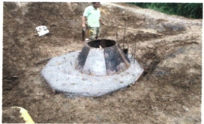
Construccion Cono de remate aliviadero
