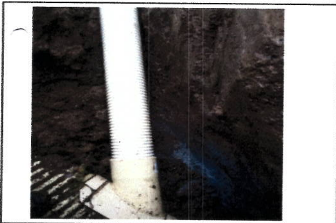
Silletas de 14" * 6" para acometidas
