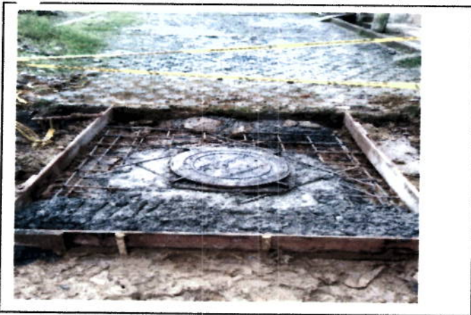
Losa concreto para instalacion de tapa Camara P4
