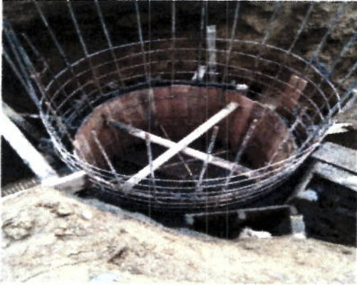
Construccion Estructura de Aliviadero
