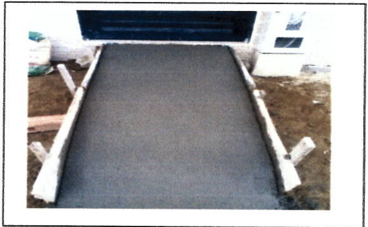
Rampas de acceso viviendas
