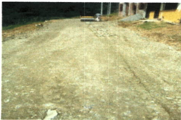
Conformacion de la via intervenida Calle 6A
