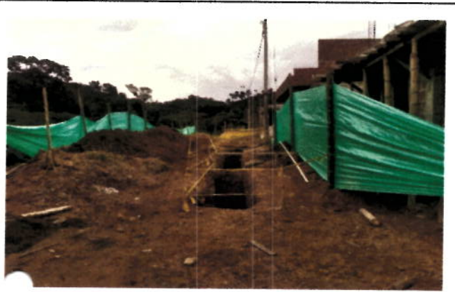
Señalización y cerramiento en yute
