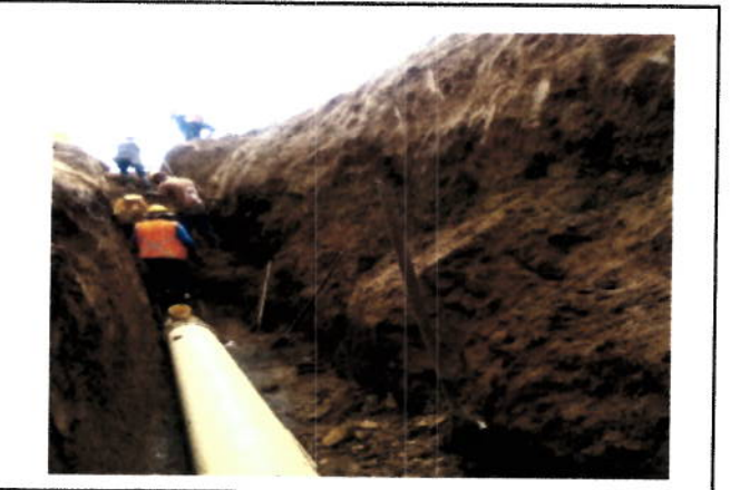
Silletas instaladas sobre la corona del tubo, profundidad de 4,5 mts
