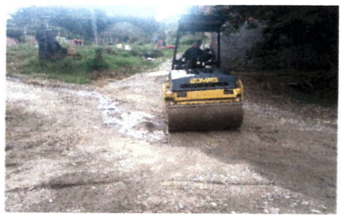
Conformacion de la via intervenida Calle 6A
