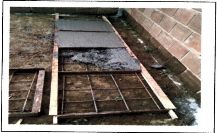
Construccion de tapas para cajas domiciliarias
