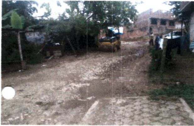
Conformacion de la via intervenida Calle 6A
