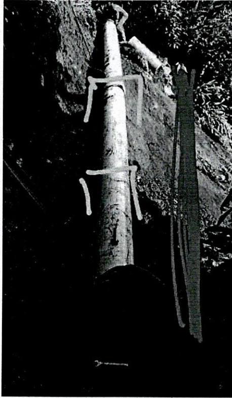
Imagen 5: Propuesta reparación provisional para abastecimiento mientras se surte el proceso de contratación de la variante en polietileno
