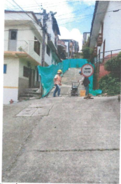
*Foto 3 y 4. Corte de pavimento con señalización y cerramiento yute*
