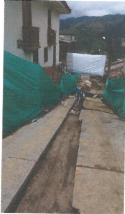
*Foto 9 y 10. Instalación de tubería novafort de 12" para cámaras 1' y 2, llenos y compactación de sub base con rana en brecha.*
