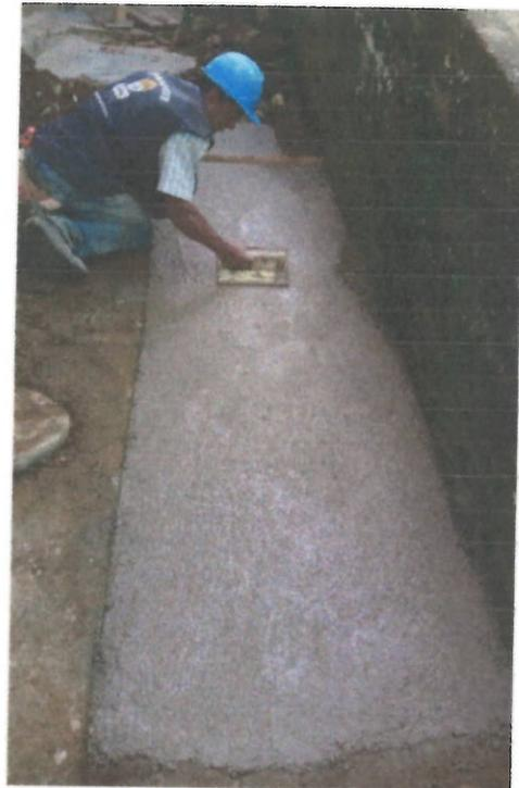
*Foto 11 y 12. Vaciado de andenes para cajas de domiciliarias parte izquierda.*
