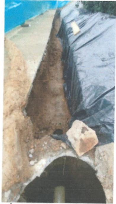
*Foto 12 y 13. Demolición y excavación de brecha entre cámara 1 y 1' con tubería en concreto en mal estado.*
