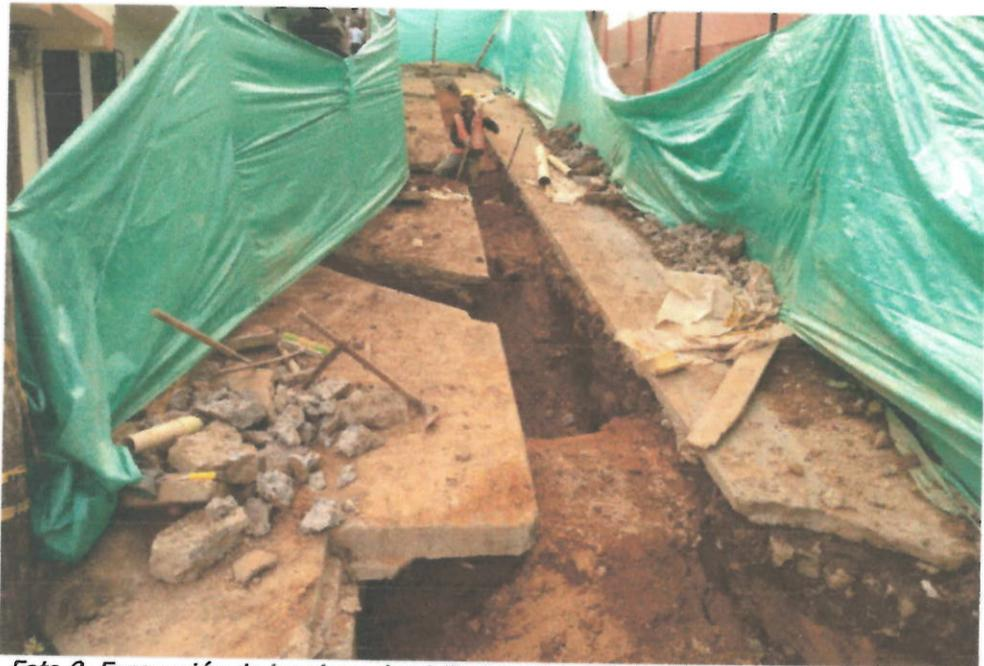
*Foto 8. Excavación de brecha y domiciliarias para instalación de tubería de 12" entre cámaras 1' y 2*
