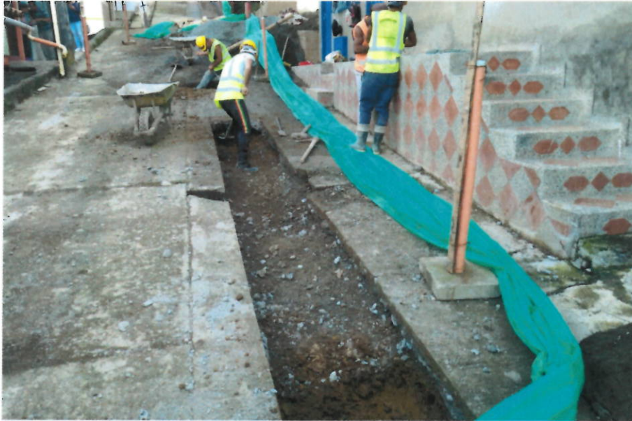
Foto 8. Demolición brecha calle 8 entre carreras 2 y 3.
