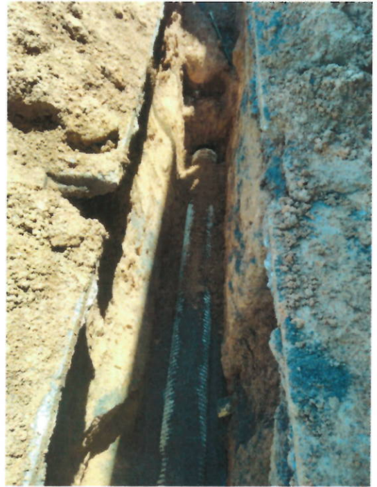
Foto 11 y 12. Instalación de arena limpia para tubería.
