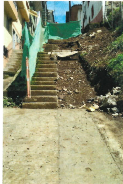
Foto1 y 2. Demolición de escaleras para último tramo de tubería, excavación, evacuación de tubería existente de concreto y reposición de alcantarillado.
