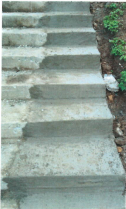
Foto1 y 2. Demolición de escaleras para último tramo de tubería, excavación, evacuación de tubería existente de concreto y reposición de alcantarillado.
