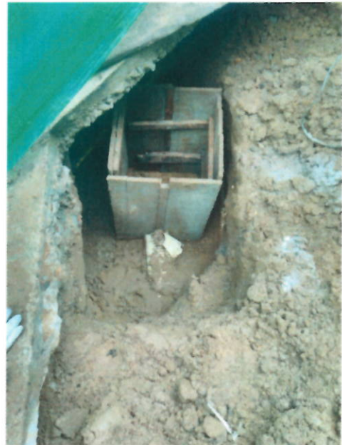
Foto 20 y 21. Construcción cajas domiciliarias en calle 8 entre carreras 2 y 3.
