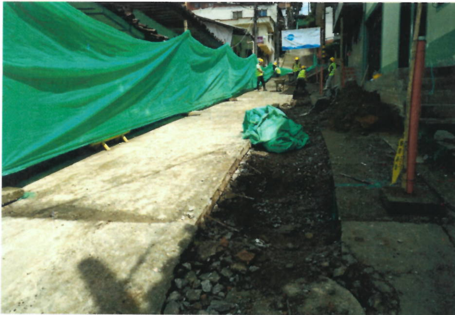
Foto 9. Sobre anchos en demolición de pavimento.
