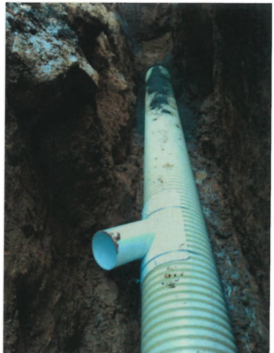
Foto 13 y 14. Instalación de silletas de 14*6.
