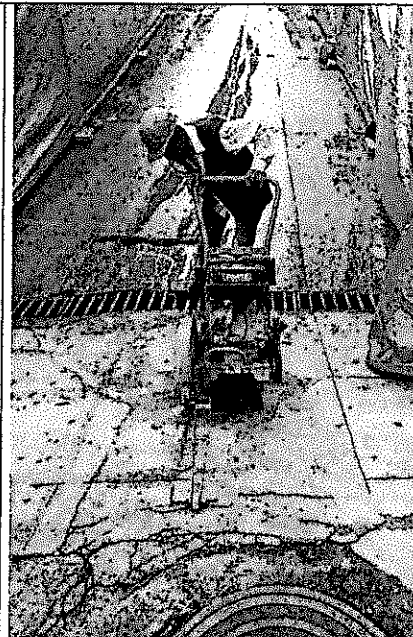
Inicio de actividades mediante corte con máquina cortadora
