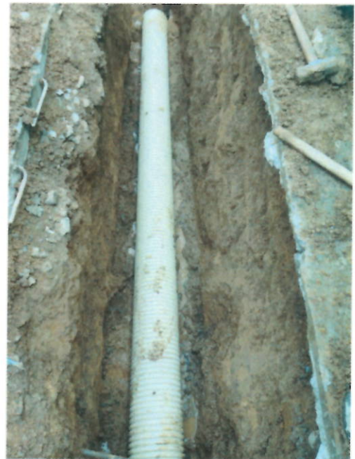
Foto 12 y 13. Tubería de 12" concreto en mal estado y tubería de 14" Novafort nueva instalada.
