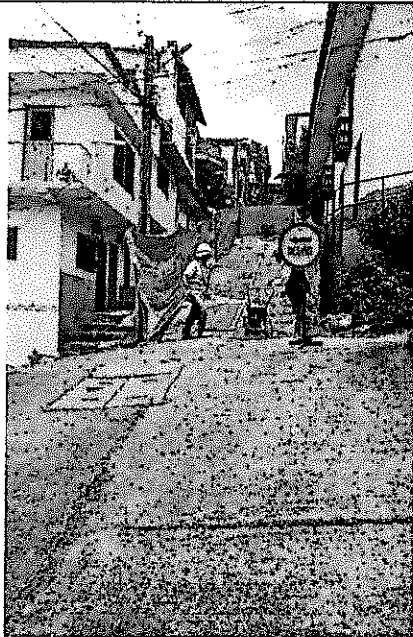
Inicio de actividades mediante corte con máquina cortadora
