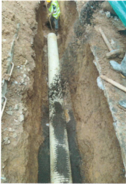
Foto 11 y 12. Instalación de arena limpia para tubería.
