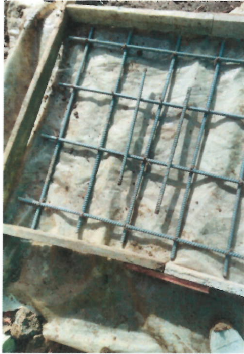
Foto 6 y 7. Instalación de tapa Hf y acero para cámara reforzada.
