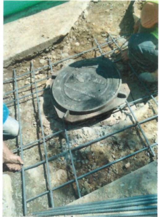
Foto 6 y 7. Instalación de tapa Hf y acero para cámara reforzada.
