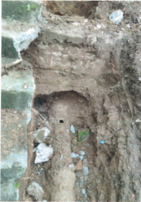
Foto1 y 2. Demolición de escaleras para último tramo de tubería, excavación, evacuación de tubería existente de concreto y reposición de alcantarillado.
