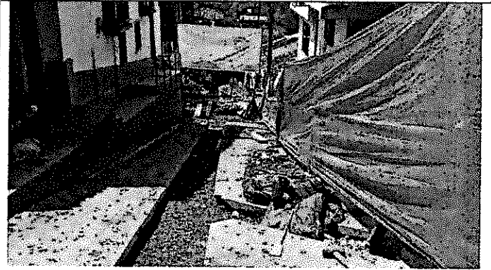
Instalación de material granular
