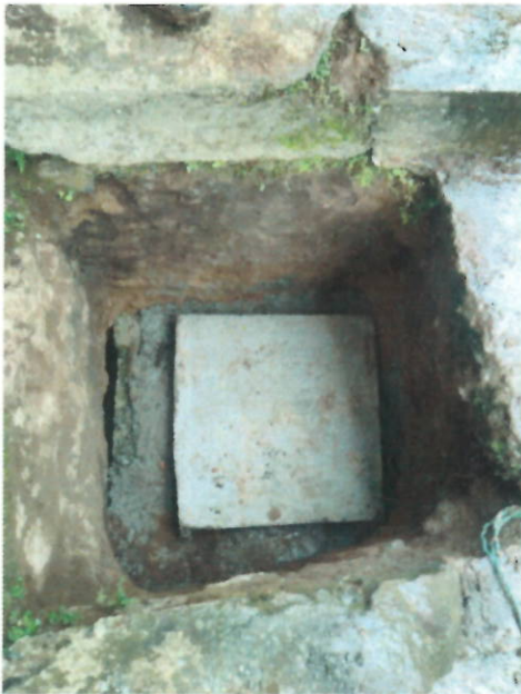
Foto 20 y 21. Construcción cajas domiciliarias en calle 8 entre carreras 2 y 3.
