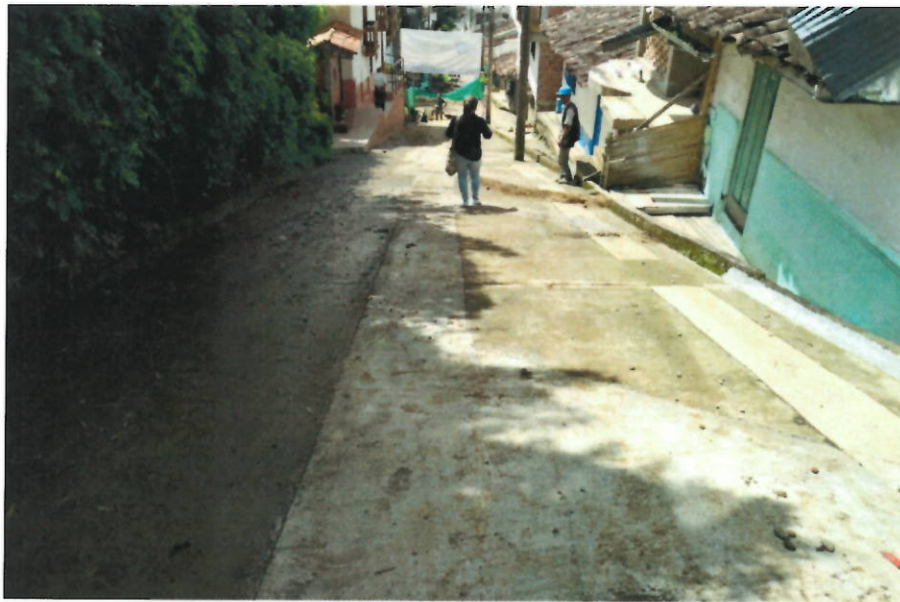
Foto 5. Calle 8 entre carreras 1 y 2 finalizada.
