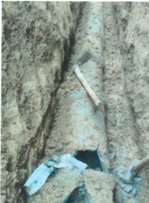
Foto 12 y 13. Tubería de 12" concreto en mal estado y tubería de 14" Novafort nueva instalada.
