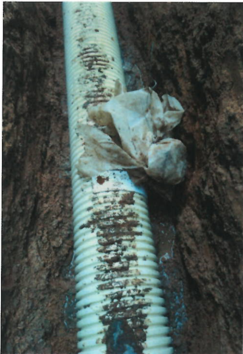
Foto 13 y 14. Instalación de silletas de 14*6.
