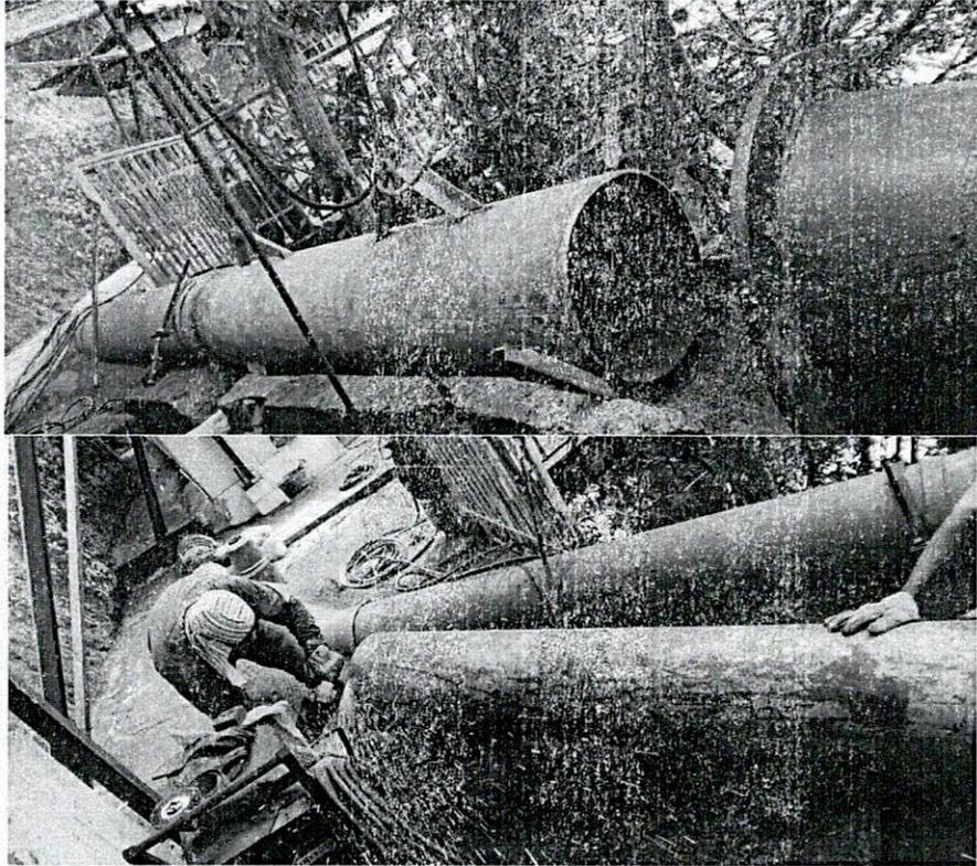
3. El día 02 de Marzo se realiza soldadura de 2.5M de tubería acero al carbono SCH 40.
