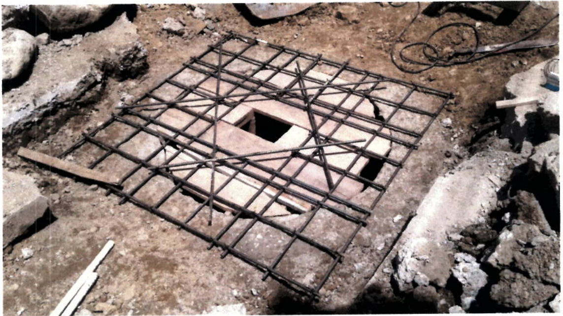
Acero de refuerzo
