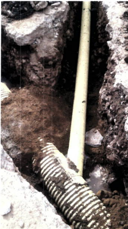
Suministro transporte e Instalación Tubería PVC Corrugada 160mm (6") para Alcantarillado
