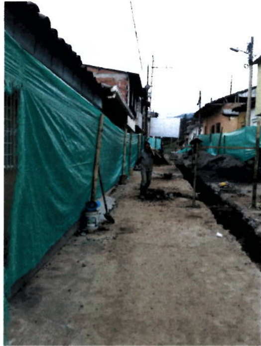
Suministro transporte e Instalación Tubería PVC Corrugada 160mm (6") para Alcantarillado
