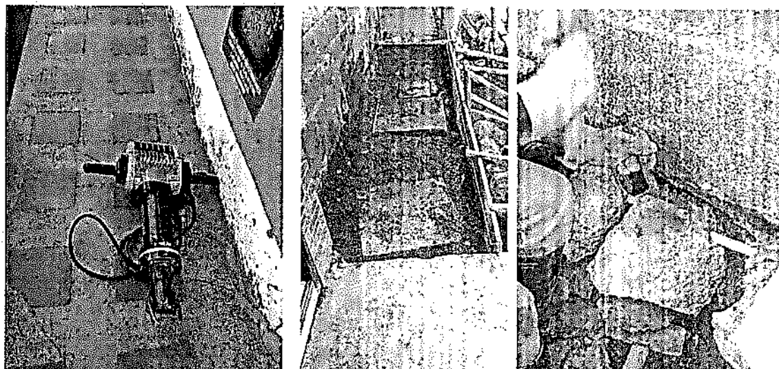
3. Corte mecanizado de pavimentos
