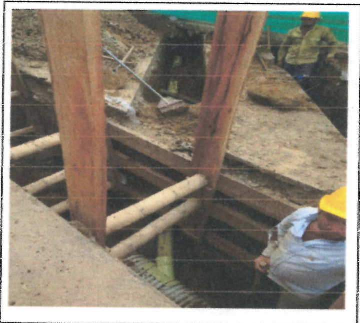
INSTALACION DE SILLETAS DE 24" * 6"
