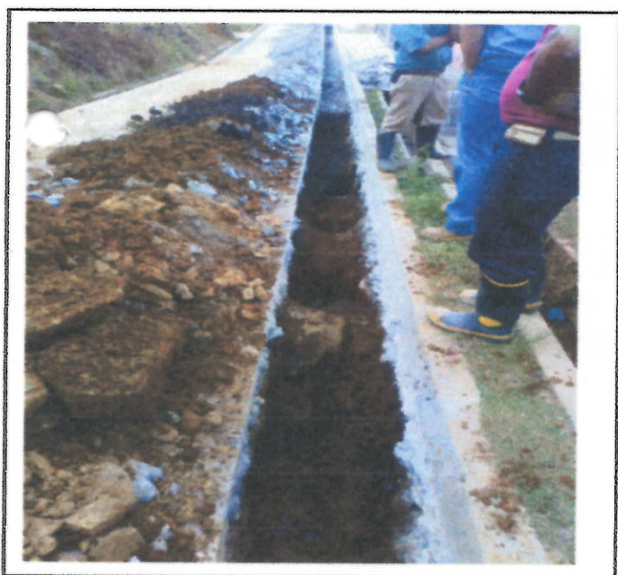
ROCAS PRESENTES EN LA EXCAVACION
