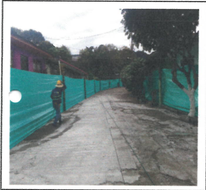
CERRAMIENTO EN YUTE Y CORTE DE PAVIMENTO
