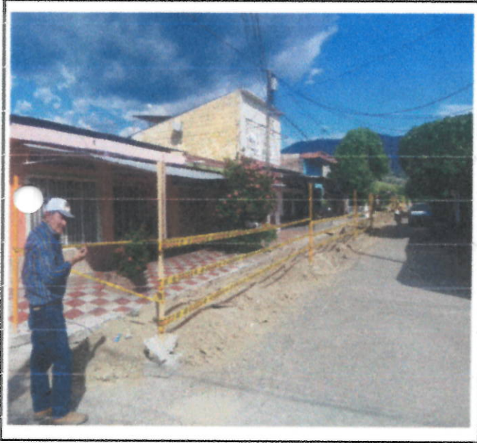
EXCAVACIONES PARA INSTALACION DE TUBERIA ACUEDUCTO PVC 3"
