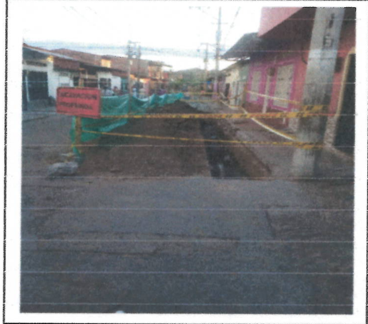
CERRAMIENTO EN YUTE Y SEÑALES INFORMATIVAS
