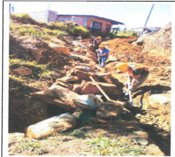
EXCAVACION EN ROCA
