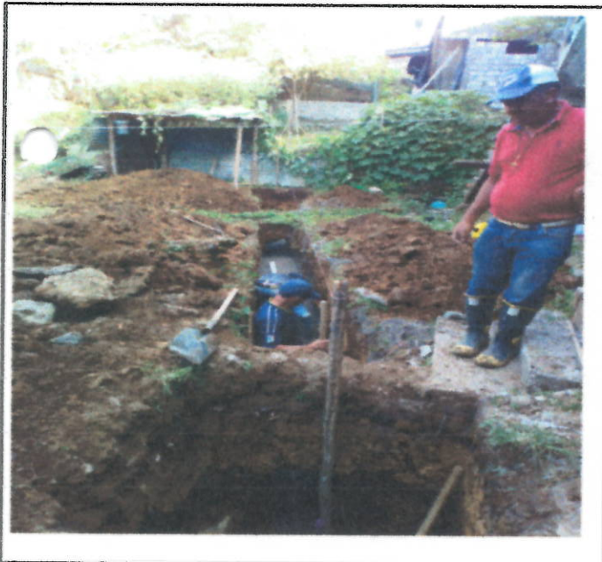
EXCAVACION E INSTALACION DE TUBERIA RED DE ALCANTARILLADO DE 12"
