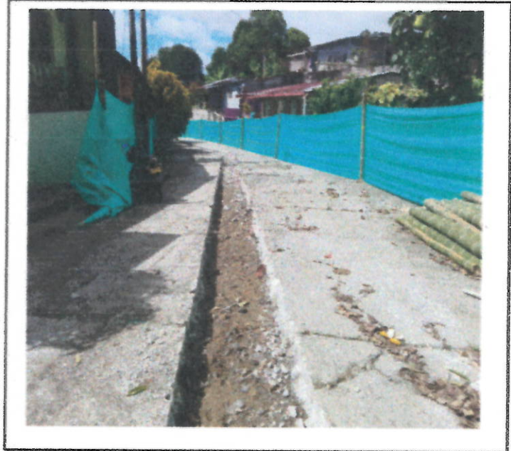
DEMOLICION DE PAVIMENTO RIGIDO
