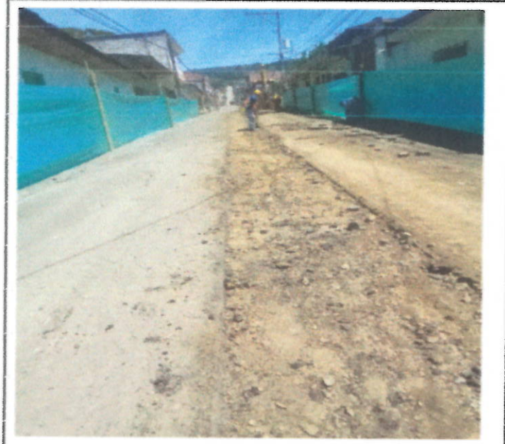
DEMOLICION DE PAVIMENTO ASFALTICO
