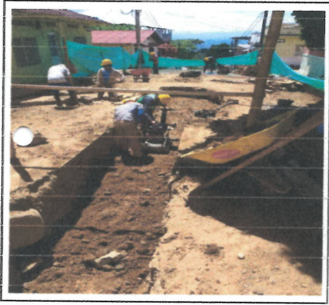
COMPACTACION DE LLENO CON RANA VIBROCOMPACTADORA
