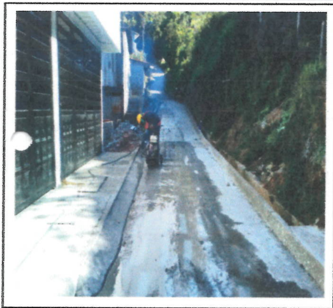
CORTE DE PAVIMENTO PARA CAMBIO DE RED DE ACUEDUCTO
