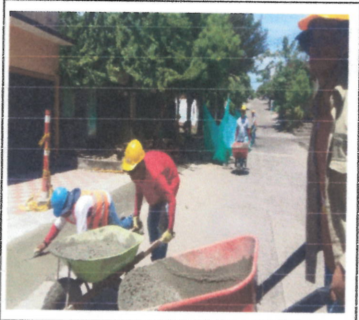
VACIADO DE CONCRETO DE 4.2 MPA EN VIA
