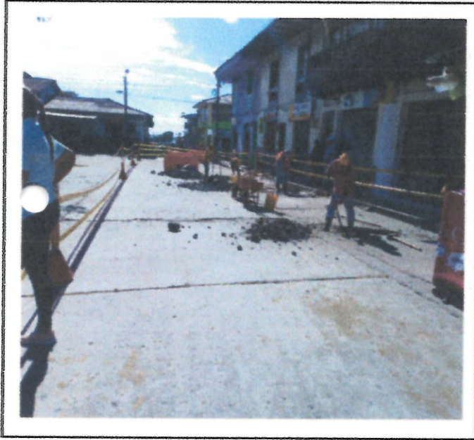
INICIO DE DEMOLICION PARA CAMBIO DE RED DE ALCANTARILLADO PARQUE CENTRAL
