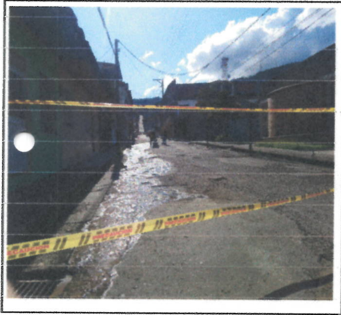
CORTE DE PAVIMENTO ASFALTICO
