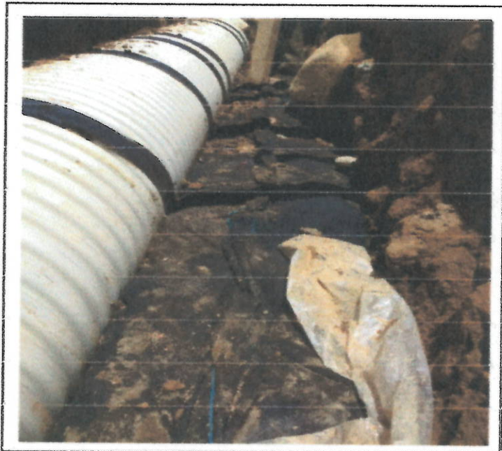
FILTRO FRANCES PARA CAPTAR AGUA DE NACIMIENTO
