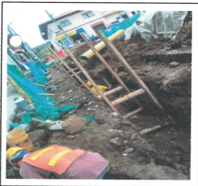
EXCAVACION Y ENTIBADO
