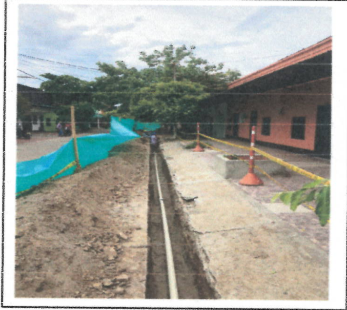
INSTALACION DE TUBERIA DE ACUEDUCTO PVC DE 3" CON PROTECCION DE CAMA DE ARENA
