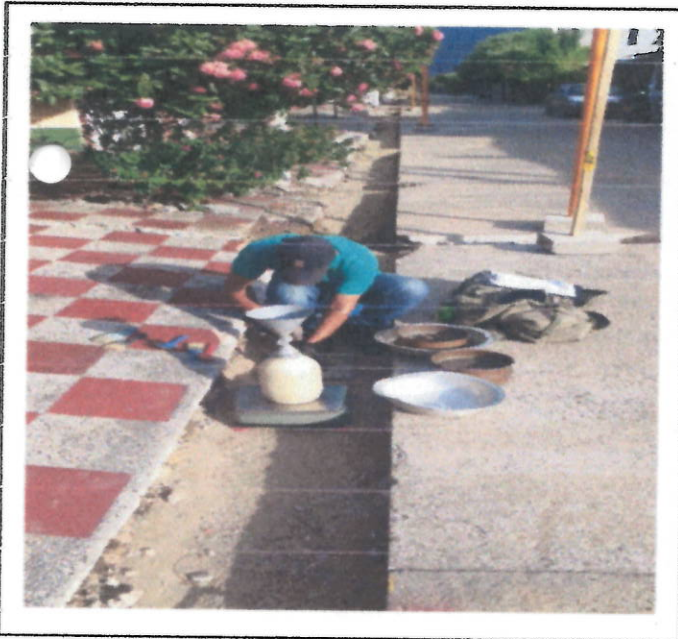
ENSAYOS DE DENSIDAD A LA SUB BASE EMPLEADA
