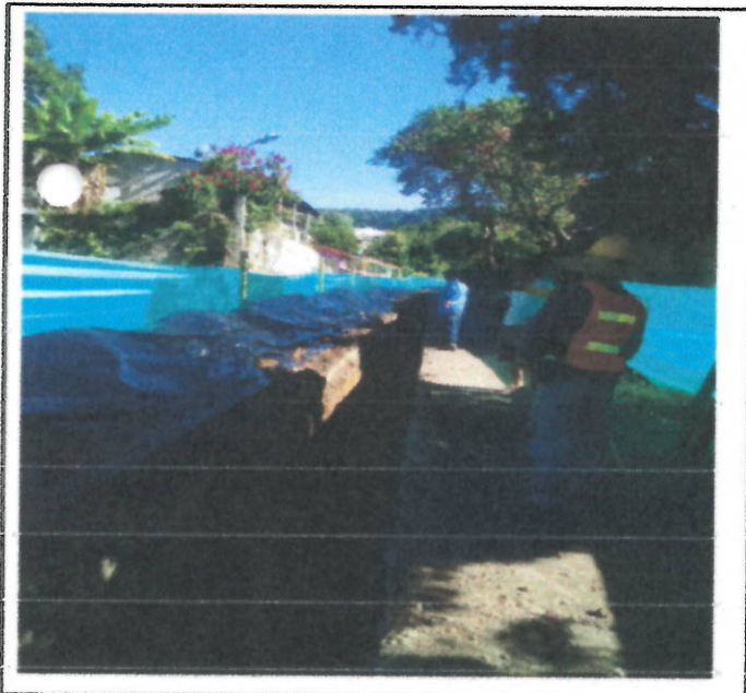
EXCAVACION EN BRECHA Y PROTECCION DEL MATERIAL EXCAVADO
