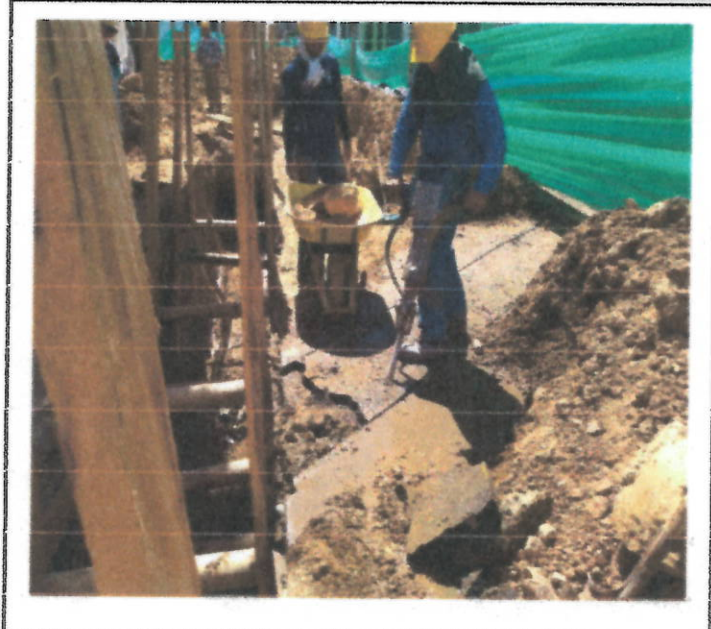
ENTIBADO Y DEMOLICION PARA DOMICILIARIAS
