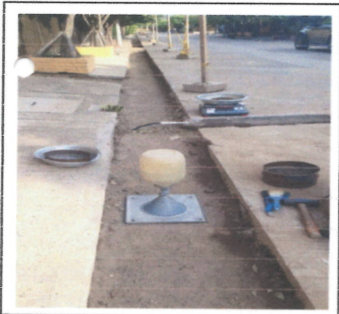
ENSAYOS DE DENSIDAD A LA SUB BASE EMPLEADA
