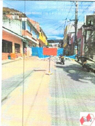
Ilustración 6: Cerramiento y señalización de la obra
