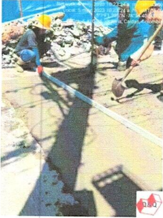
Ilustración 20: acabado de concreto
