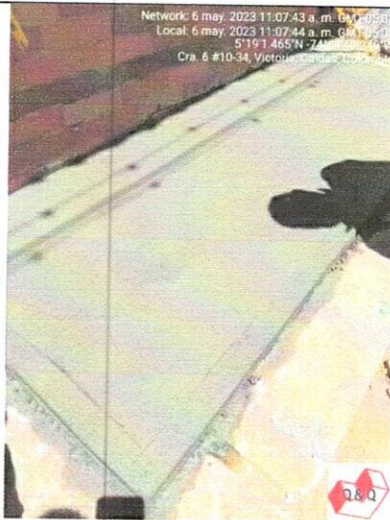
Ilustración 24: Vaciado y acabado del concreto del anden
