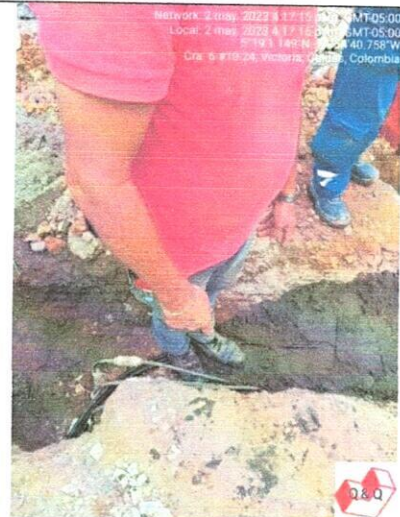
Ilustración 25: Instalación y recubrimiento de arena domiciliarias en manguera PF
