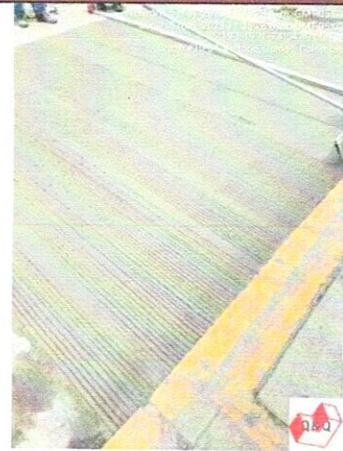
Ilustración 21: Acabado de concreto
