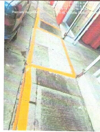
Ilustración 3: Estado inicial de la obra
