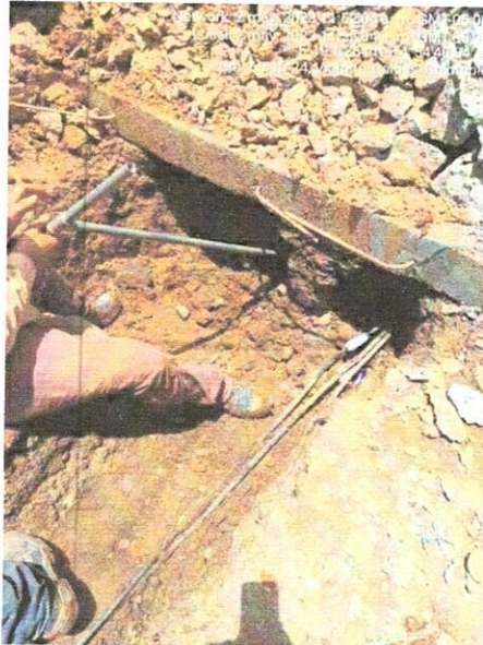
Ilustración 10: Perforación con barreno
