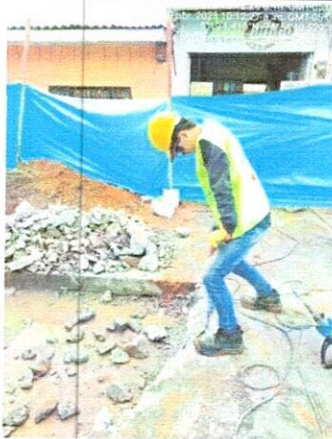
Ilustración 12: Demolición de placa existente
