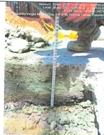
Ilustración 7: Espesor de losa de concreto
