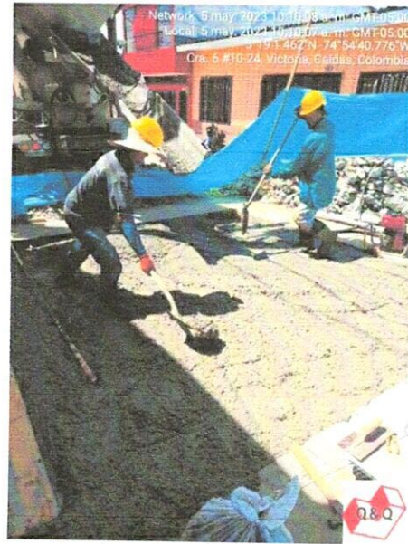
Ilustración 15: Vaciado de concreto premezclado
