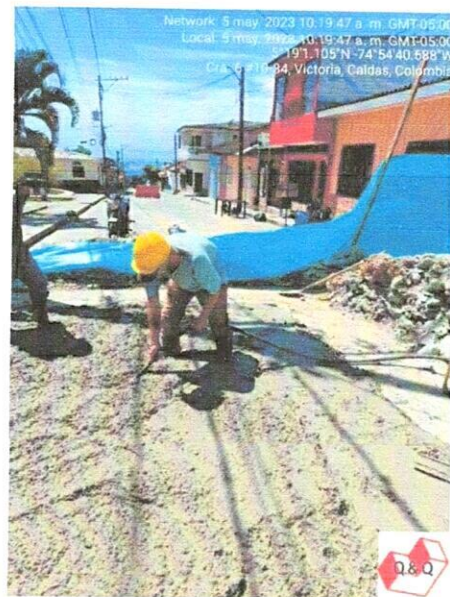
Ilustración 16: Vibrado de concreto
