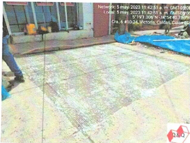
Ilustración 18: Aplicación de antisol
