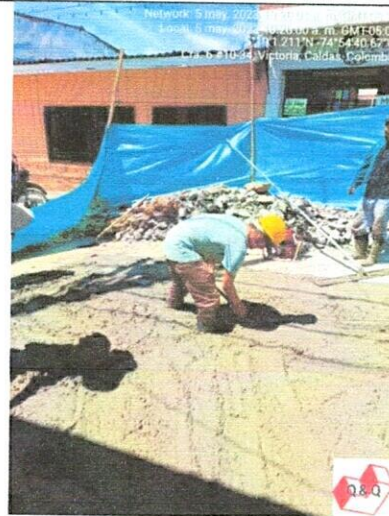
Ilustración 19: Vaciado y vibrado de concreto
