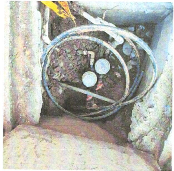
Ilustración 11: Instalación de manguera PF
