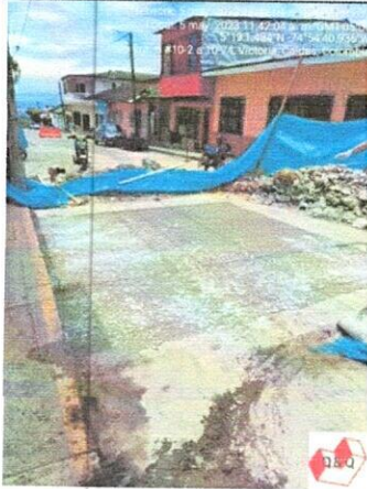
Ilustración 22: antisol para concreto
