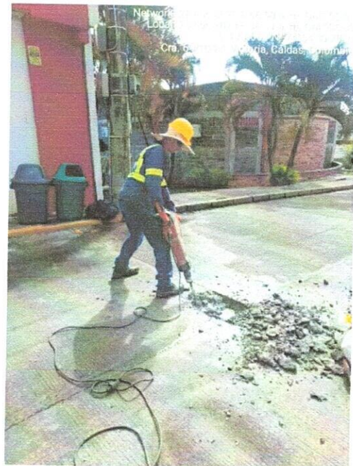
Ilustración 4: Demolición de placa existente
