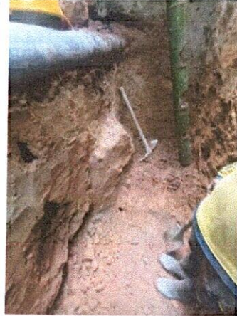
EXCAVACION BRECHA ENTRE CAMARA 18 Y CAMARA 19
