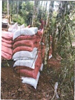
CONSTRUCCION DE TRINCHOS CON COSTALES ENTRE LA CAMARA 18 Y CAMARA 19
