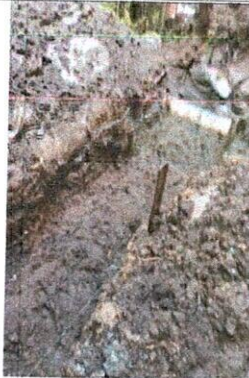
EXCAVACION BRECHA ENTRE CAMARA 17 Y CAMARA 18
