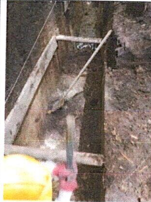
NIVELACION DE BRECHA ENTRE CAMARA 16 Y CAMARA 17
