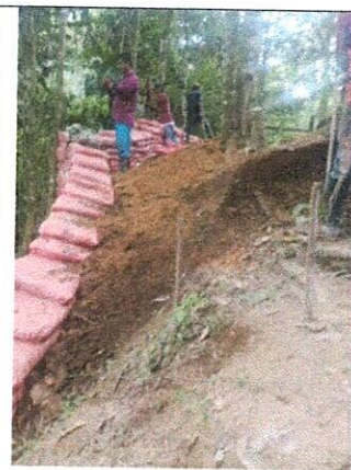
CONSTRUCCION TRINCHOS EN COSTALES ENTRE LA CAMARA 18 Y CAMARA 19
