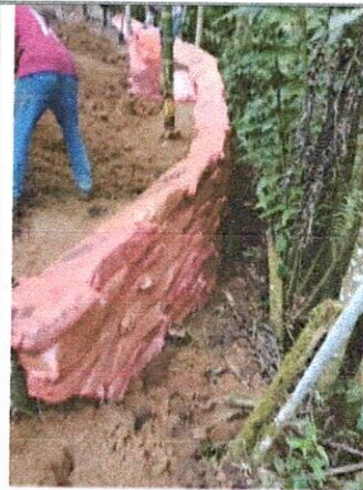
CONSTRUCCION TRINCHOS CON COSTALES CAMARA 16 A LA CAMARA 17
