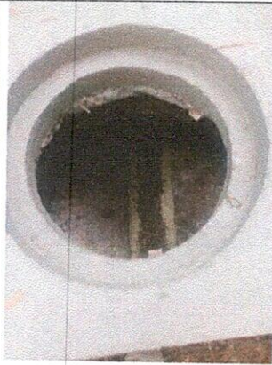
VACIADO EN CONCRETO TECHO DE CAMARA 13
