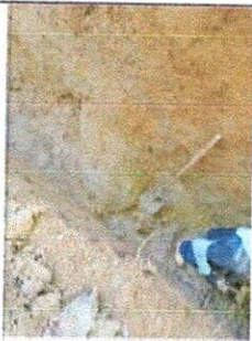
CONSTRUCCION BRECHA DEL TRAMO ENTRE CAMARA 16 Y CAMARA 17
