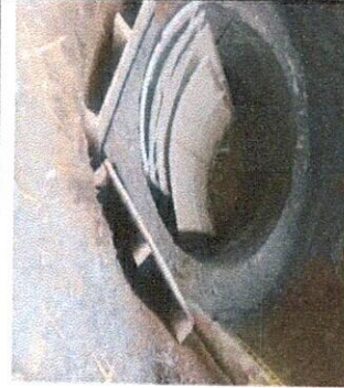
VACIADO EN CONCRETO CUERPO DE CAMARA 14
