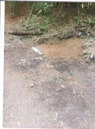
LLENO DE BRECHA ENTRE CAMARA 17 Y CAMARA 18
