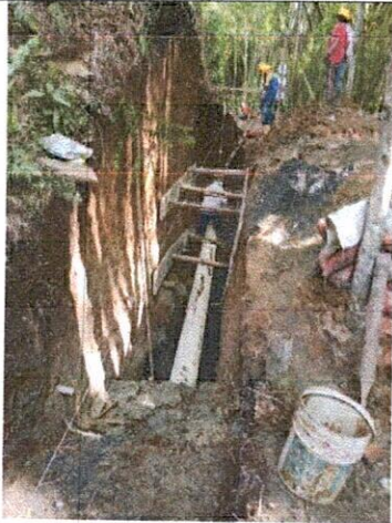
INSTALACION TUBERIA DE 12" ENTRE CAMARA 16 Y CAMARA 17
