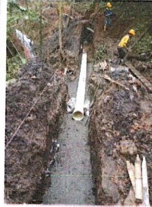
INSTALACION TUBERIA DE 12" ENTRE LA CAMARA 17 Y CAMARA 18
