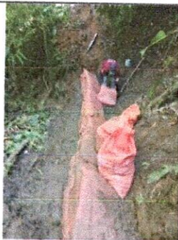
CONSTRUCCION TRINCHOS EN COSTALES ENTRE CAMARA 18 Y CAMARA 19
