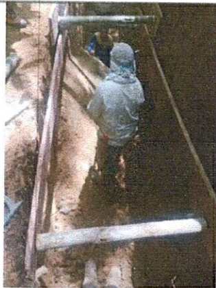
CONSTRUCCION ENTIBADO ENTRE CAMARA 16 Y CAMARA 17
