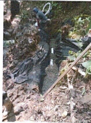
TENDIDA DE GEOTEXTIL NT – 1600 Y TUBERIA DE 100 ML PARA LA CONSTRUCCION DE DRENES ENTRE LA CAMARA 17 Y CAMARA 18
