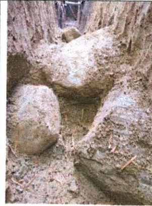
PREPARACION LIMPIEZA DE ROCAS PARA DEMOLICION CON CUÑA HIDRAULICA
