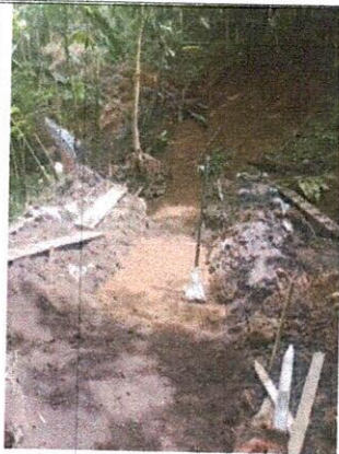
LLENO COMPACTADO ENTRE LA CAMARA 17 Y CAMARA 18
