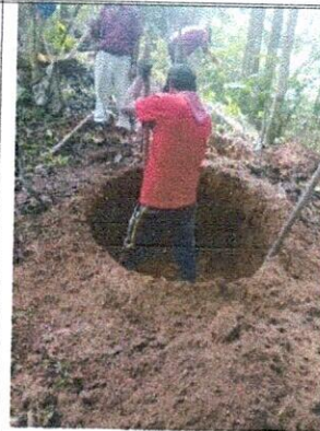
INICIO DE EXCAVACION CAMARA 19
