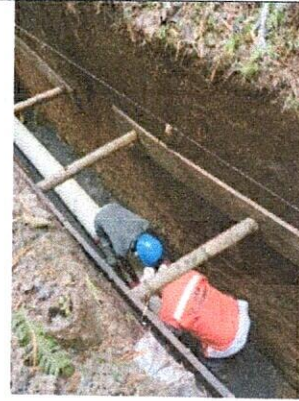
INSTALACION DE TUBERIA DE 12" ENTRE CAMARA 16 Y CAMARA 17
