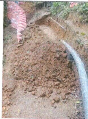
EXCAVACION ENTRE CAMARA 18 Y CAMARA 19
