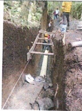
INSTALACION TUBERIA TRAMO DE LA CAMARA 16 HACIA LA CAMARA 17
