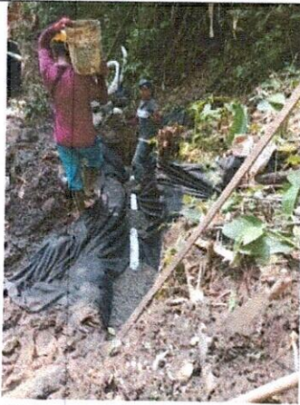
INSTALACION DE MATERIAL FILTRANTE ENTRE LA CAMARA 17 Y CAMARA 18
