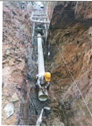
INSTALACION TUBERIA DE 12" ENTRE CAMARA 16 Y CAMARA 17
