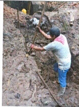
EXCAVACION PARA LA CONSTRUCCION DE FILTRO ENTRE LA CAMARA 17 Y CAMARA 18
