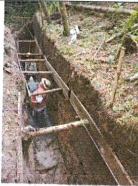
ENTIBADO ENTRE CAMARA 16 Y CAMARA 17
