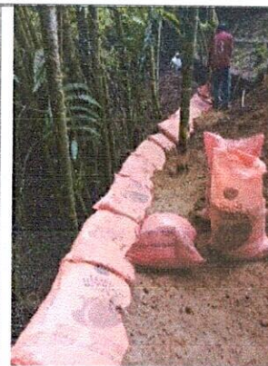
CONSTRUCCION TRINCHOS CON COSTALES TRAMO CAMARAS 16 Y 17
