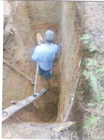
EXCAVACION BRECHA ENTRE CAMARA 18 Y CAMARA 19
