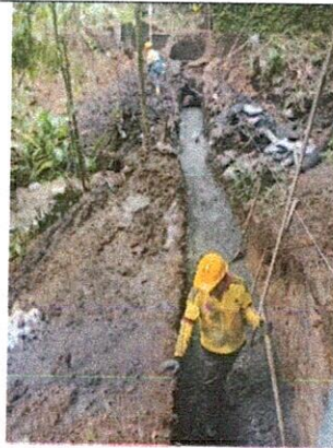
EXCAVACION BRECHA ENTRE LA CAMARA 17 Y CAMARA 18
