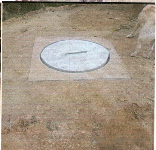
CONSTRUCCION DE CAMARAS CON TAPAS METALICAS DE HF Y CONCRETO Y PASOS EN HIERRO DE 3/4
