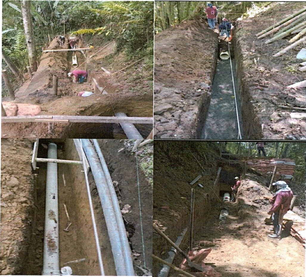
INSTALACION TUBERIA DE 12"
