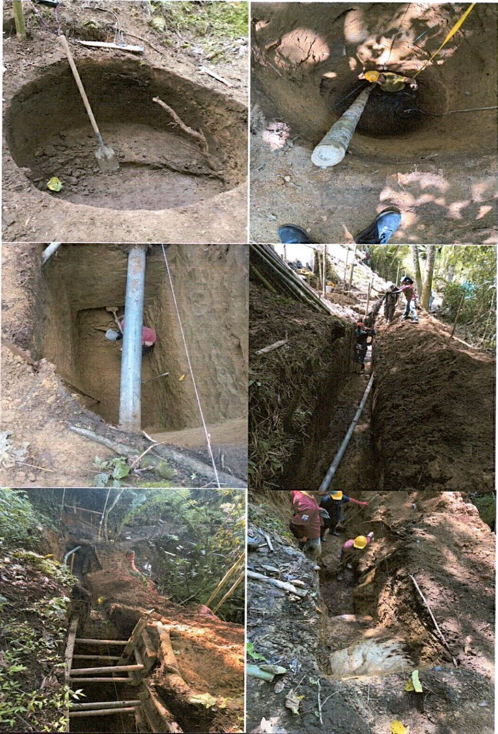
EXCAVACIONES PARA CAMARAS Y ZANJAS PARA ALCANTARILLADO
