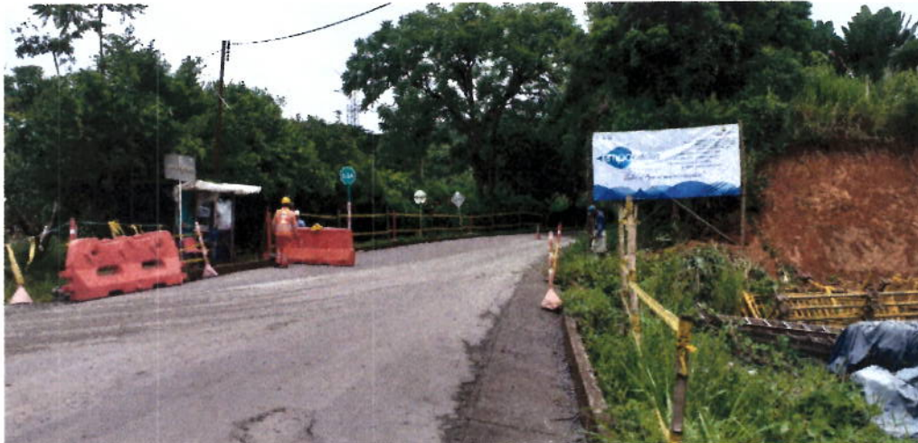
FIGURA N° 1. VALLA INSTITUCIONAL Y SEÑALIZACIÓN EN OBRA
