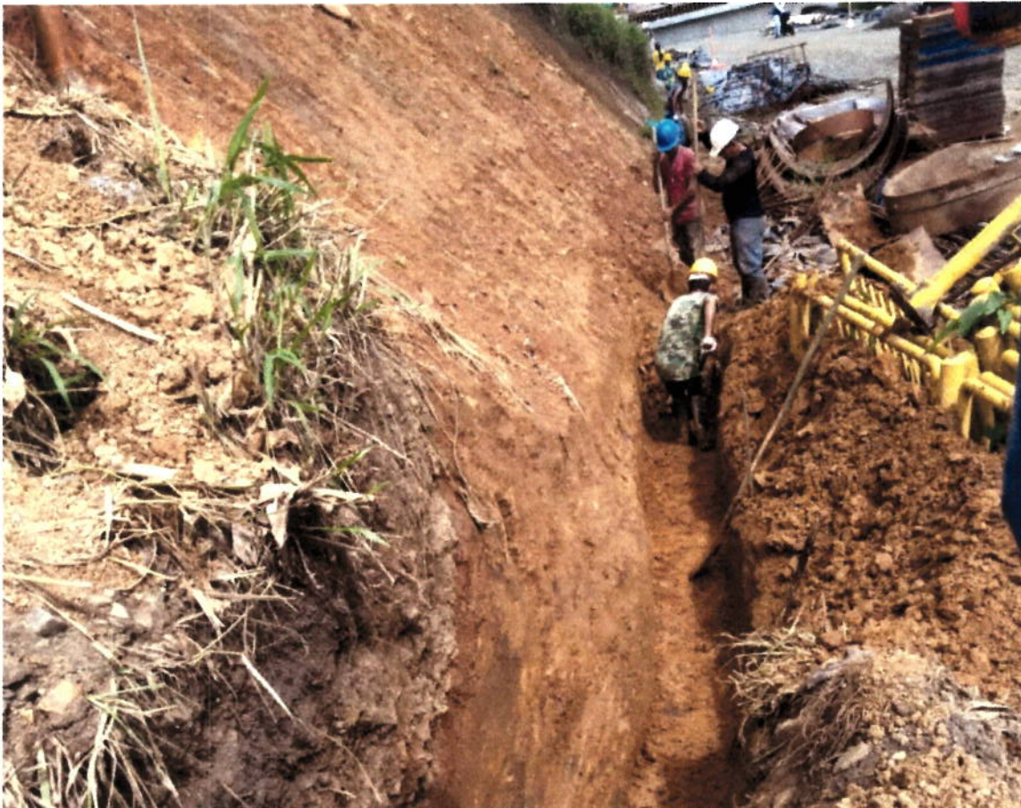
FIGURA N° 3. EXCAVACIÓN EN MATERIAL COMÚN
