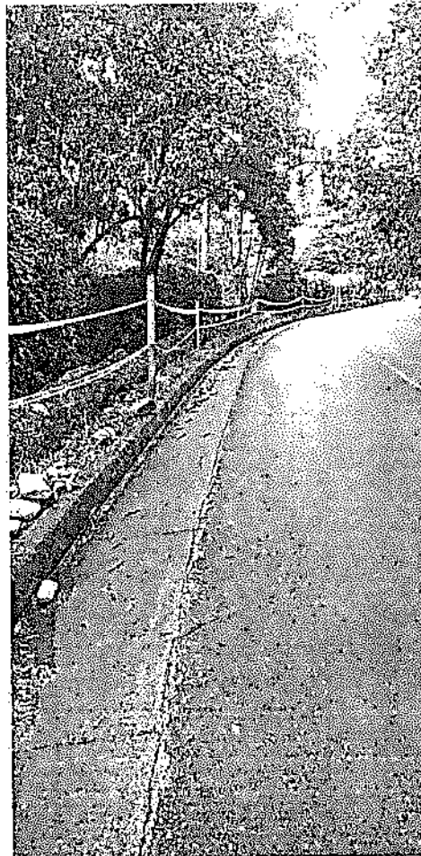
Instalación de Cerramiento
