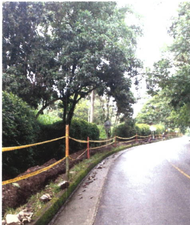
FIGURA N° 2. CERRAMIENTO EN OBRA
