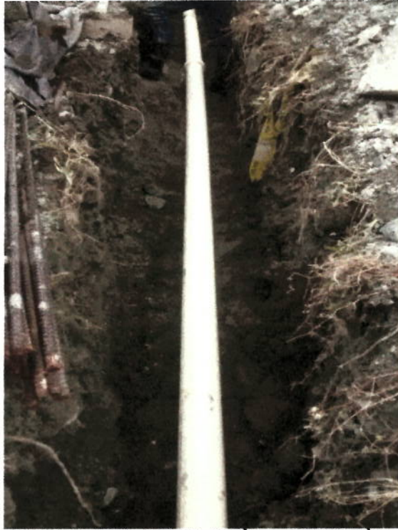
FIGURA N° 8. INSTALACIÓN DE TUBERÍA
