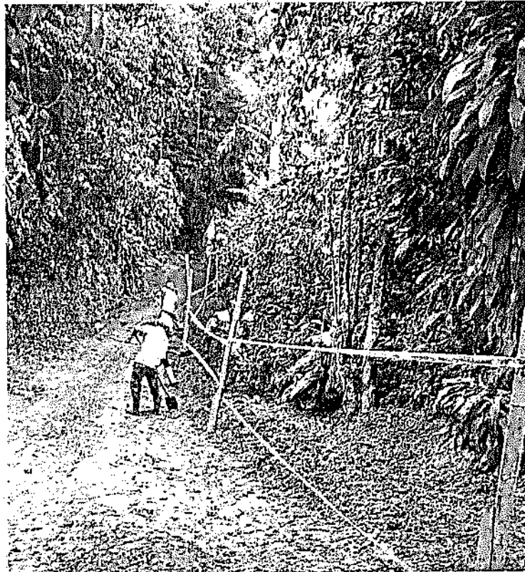
Relleno de zanja con material seleccionado
