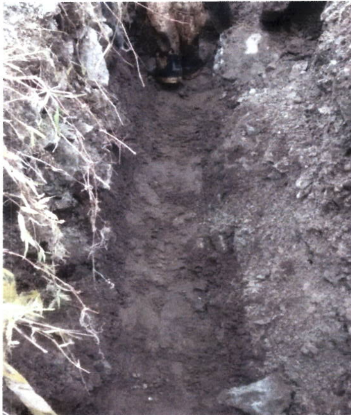
FIGURA N° 4. EXCAVACIÓN EN CONGLOMERADO
