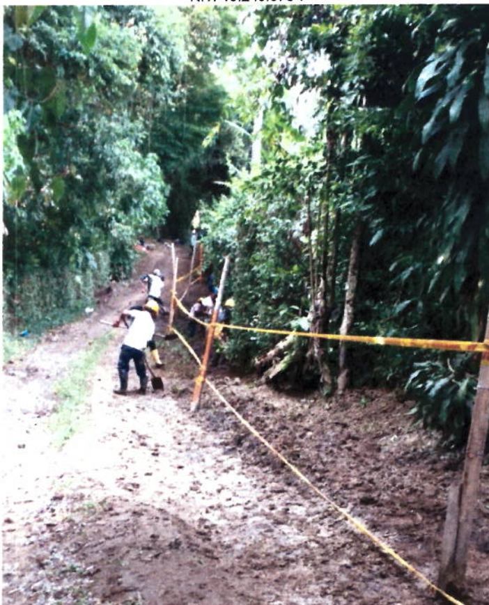
FIGURA N° 5. RELLENO DE ZANJA
