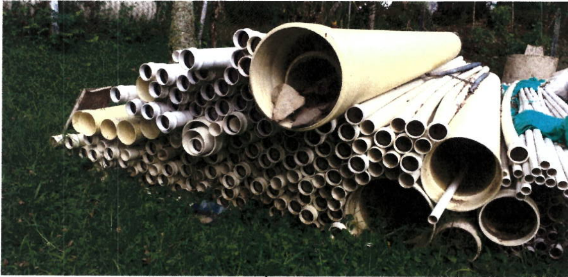
FIGURA N° 6. TUBERÍA DE 4", 3" Y 2" EN OBRA
