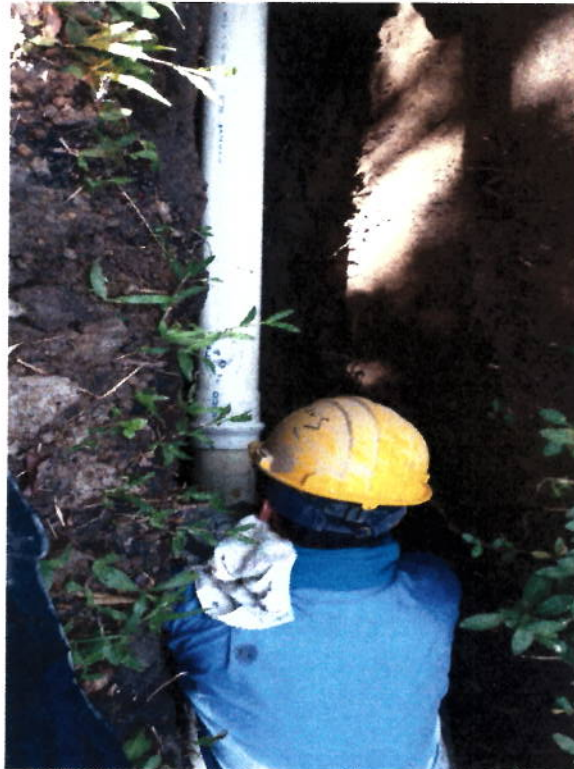
FIGURA N° 7. INSTALACIÓN DE TUBERÍA
