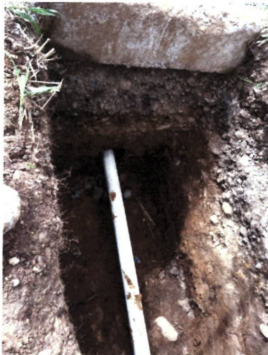
FIGURA N° 11. INSTALACIÓN DE TUBERÍA EN PERFORACIÓN DIRIGIDA
