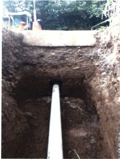
FIGURA N° 10. INSTALACIÓN DE TUBERÍA EN PERFORACIÓN DIRIGIDA
