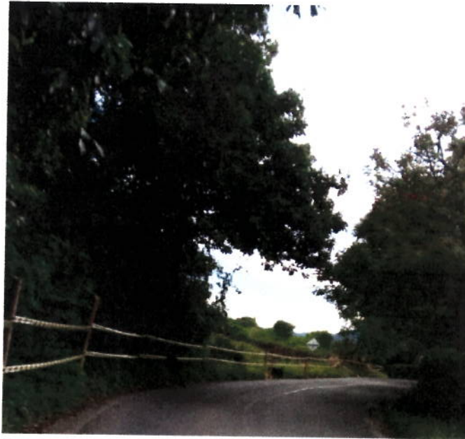
Instalación de Cerramiento
