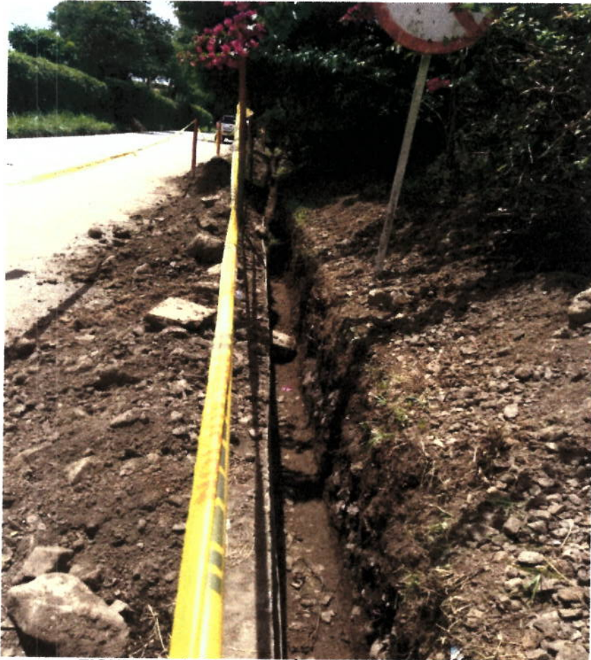
FIGURA N° 4. EXCAVACIÓN EN CONGLOMERADO
