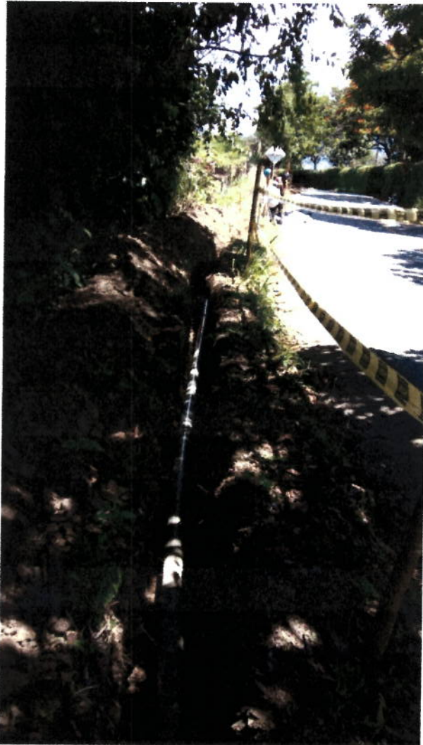
FIGURA N° 8. INSTALACIÓN DE TUBERIA 4"
