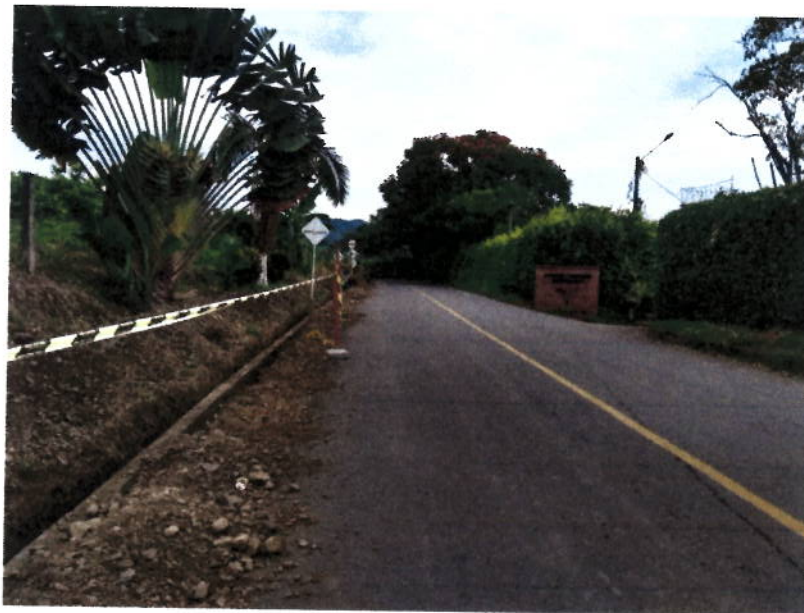
Excavación en zanja
