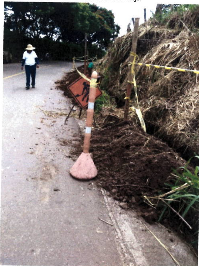
Excavación en zanja
