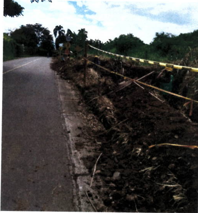
Excavación en zanja
