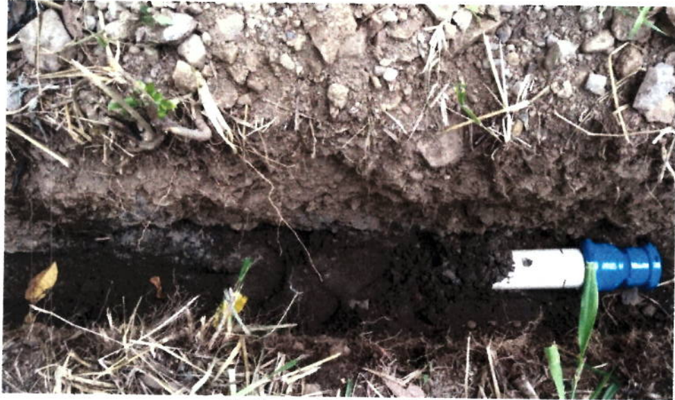
Sustitucion De Arena Limpia
