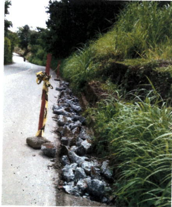
Demolición de pavimento
