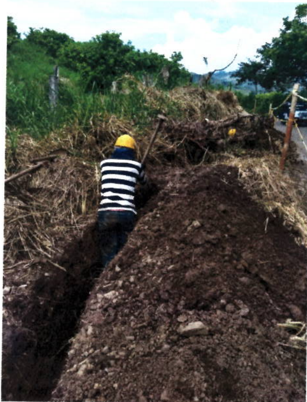
Excavación en zanja
