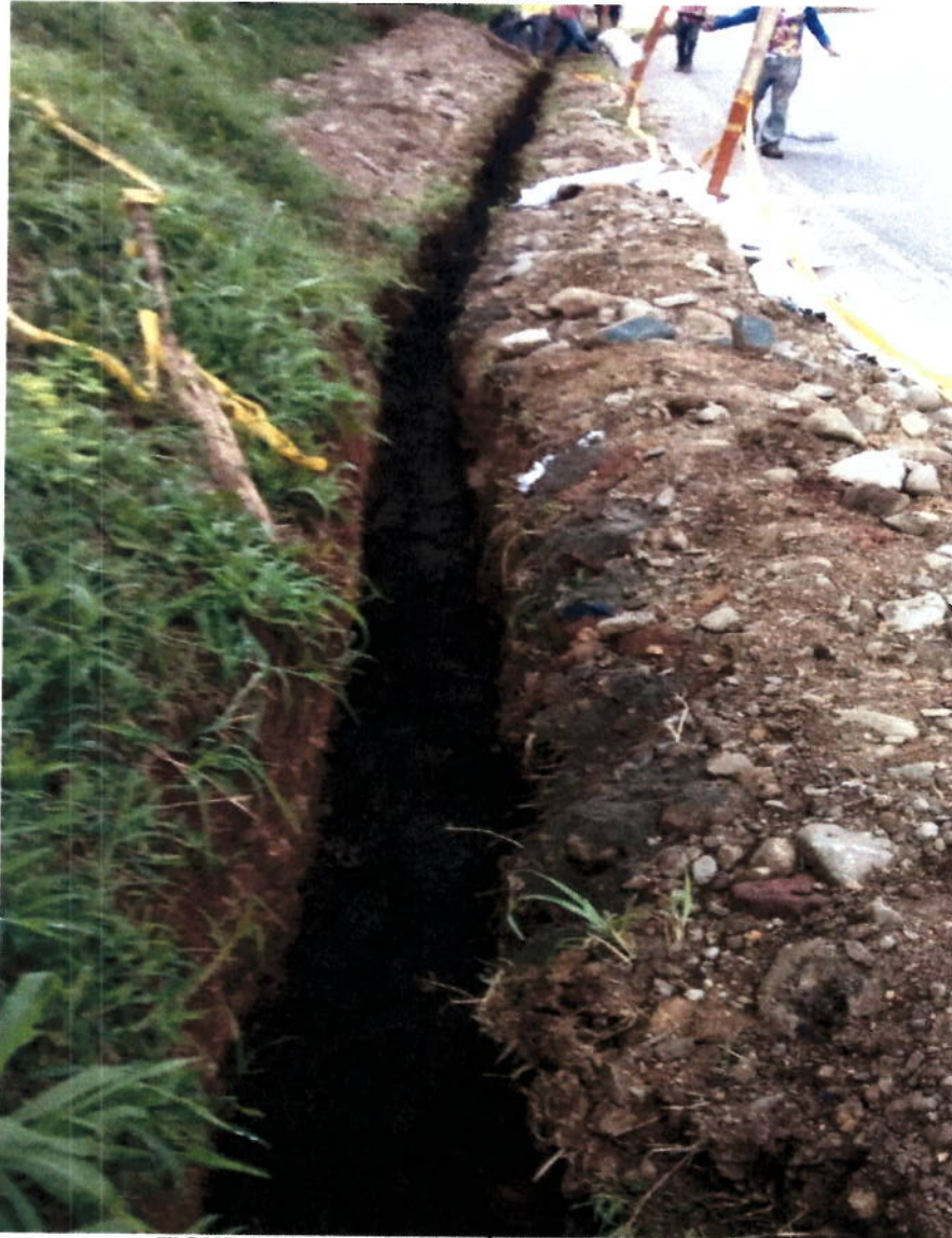
FIGURA N° 5 SUSTITUCIÓN DE ARENA LIMPIA
