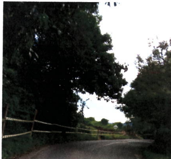
FIGURA N° 2. CERRAMIENTO EN OBRA.
