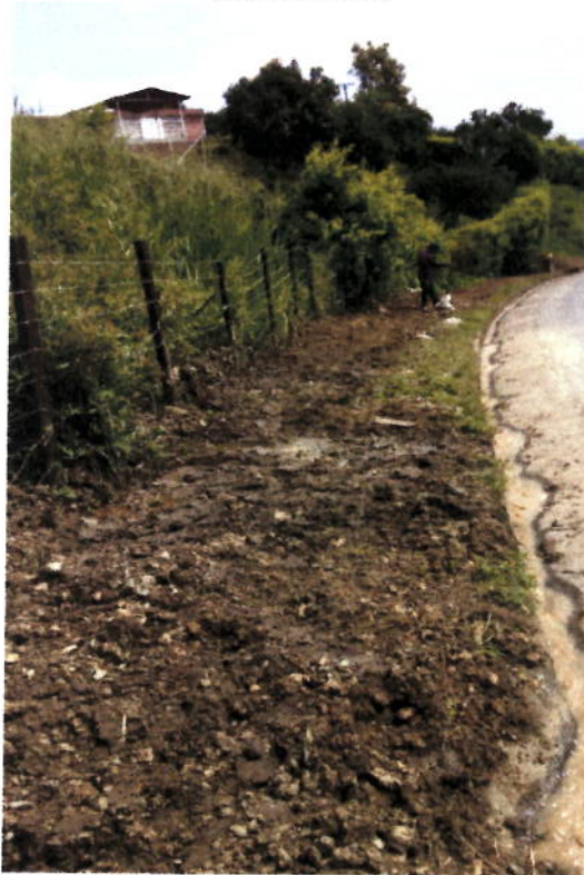
FIGURA N° 6. RELLENO DE ZANJA
