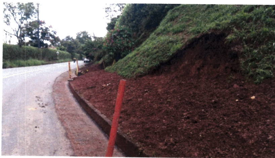
Relleno de zanja con material seleccionado
