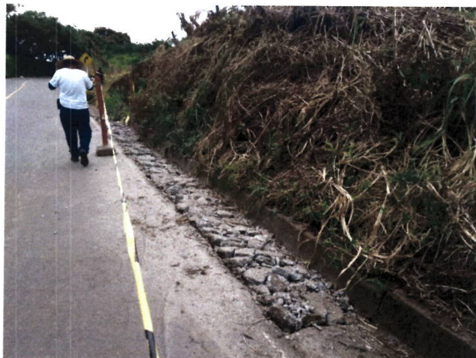
FIGURA N° 13. DEMOLICIÓN DE PAVIMENTO
