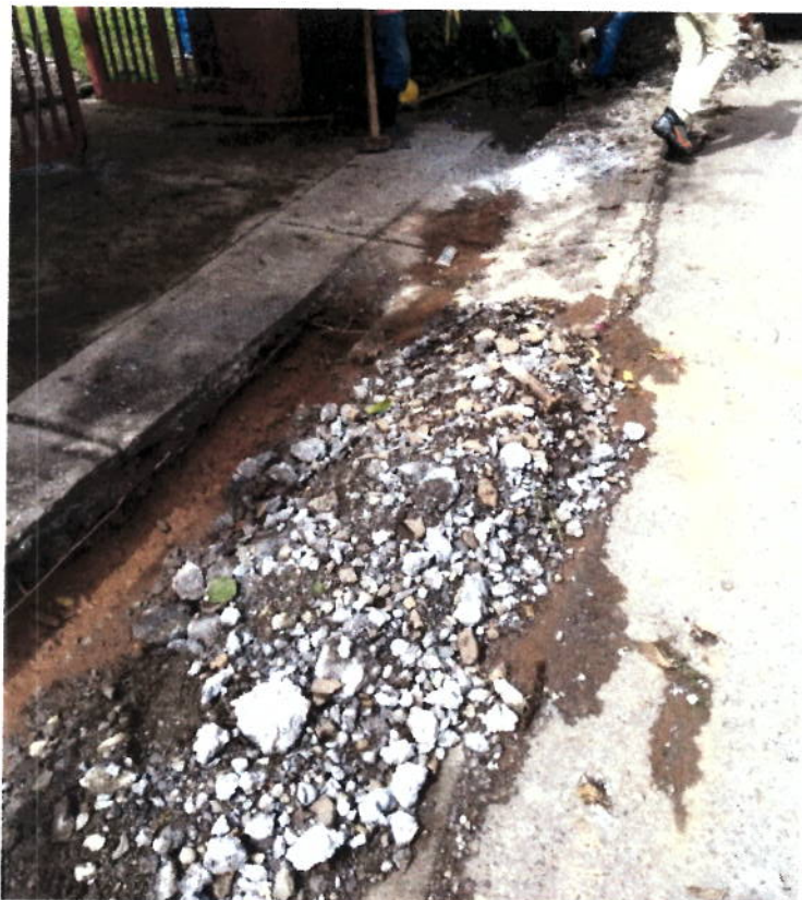
FIGURA N° 11. DEMOLICIÓN DE PAVIMENTO
