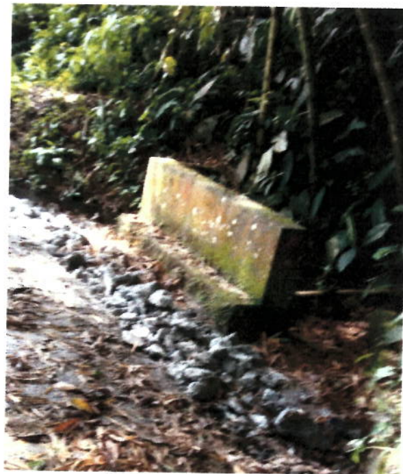
Demolición de pavimento
