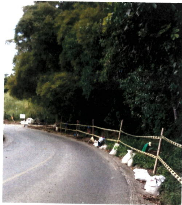
Instalación de Cerramiento
