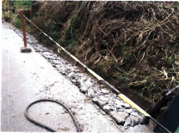
FIGURA N° 14. DEMOLICIÓN DE PAVIMENTO
