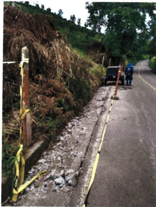
FIGURA N° 15. DEMOLICIÓN DE PAVIMENTO
