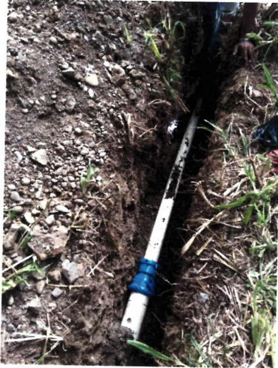
Instalación de Tubería y Reducción de 4" a 3"
