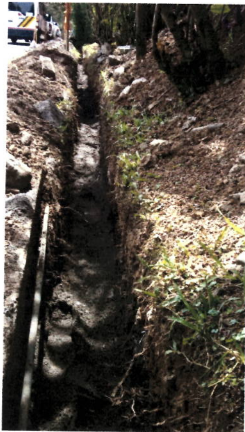
Sustitucion De Arena Limpia
