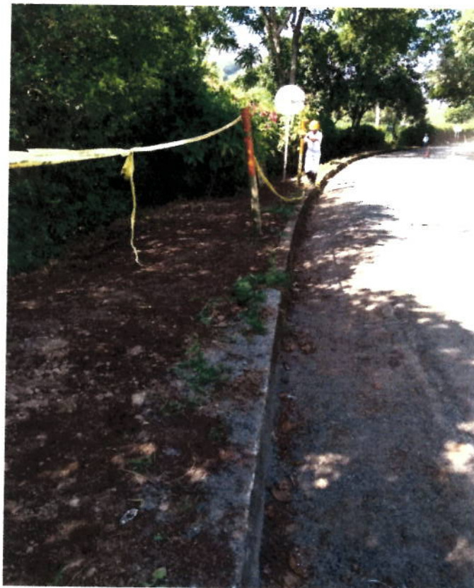
Relleno de zanja con material seleccionado
