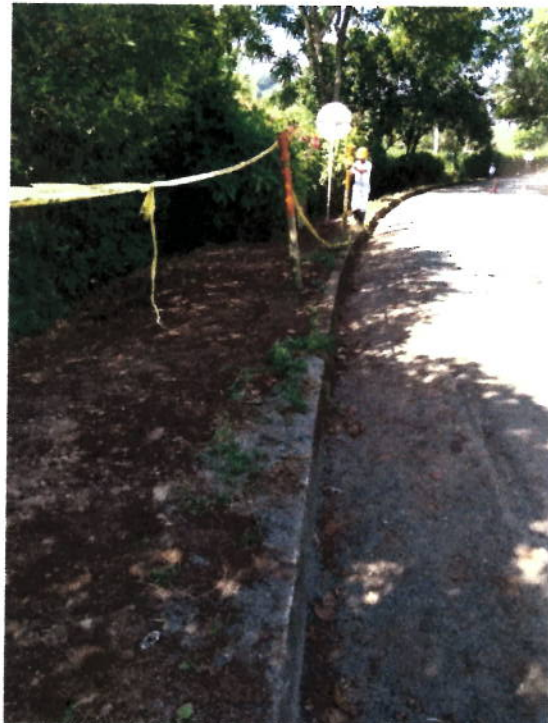
FIGURA N° 7. RELLENO DE ZANJA
