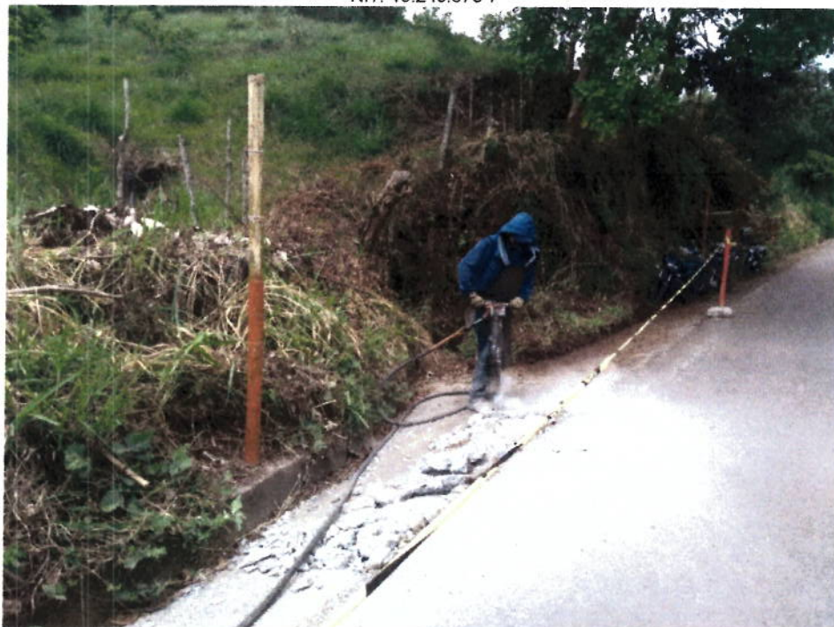
FIGURA N° 12. DEMOLICIÓN DE PAVIMENTO
