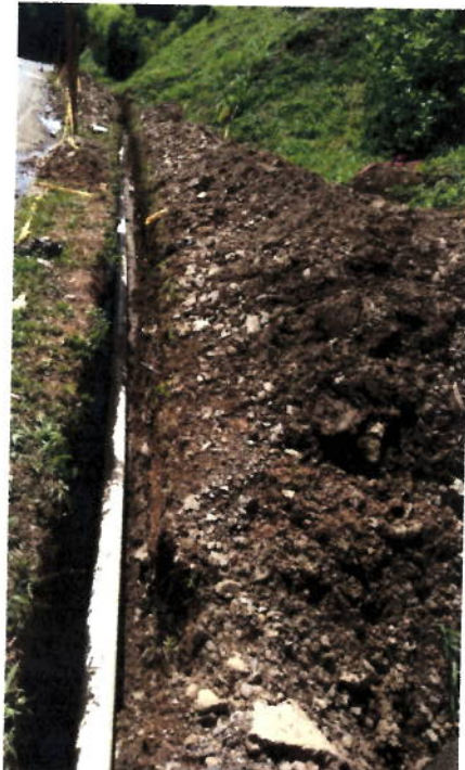
Instalación de Tubería 4"
