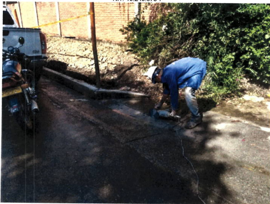
FIGURA N° 10. CORTE CON DISCO
