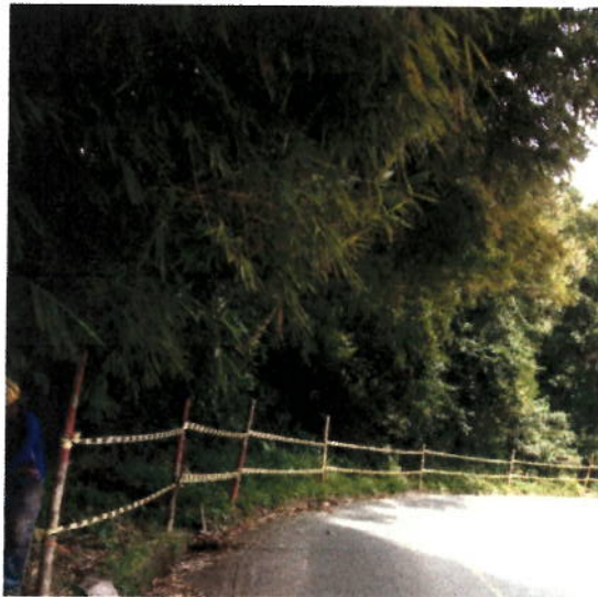
FIGURA N° 1. CERRAMIENTO EN OBRA.
