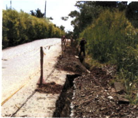
FIGURA N° 1. CERRAMIENTO EN OBRA
