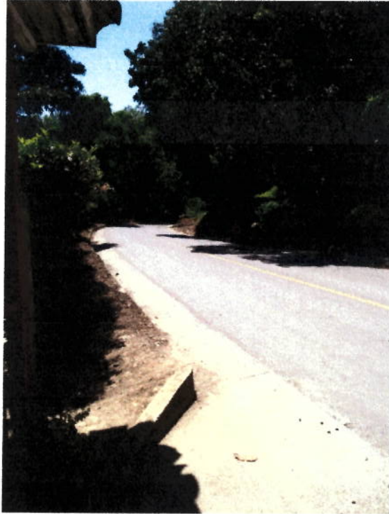
Lleno en zanja
