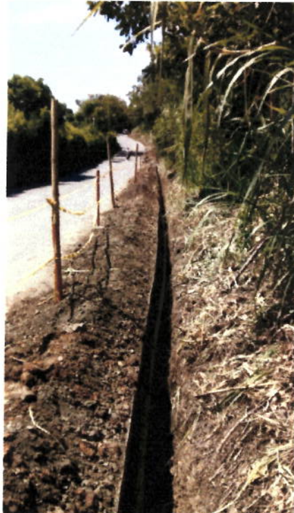
Instalación de tubería 4"
