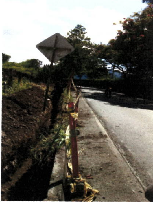
Instalación de Cerramiento
