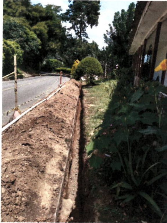
Excavación en zanja
