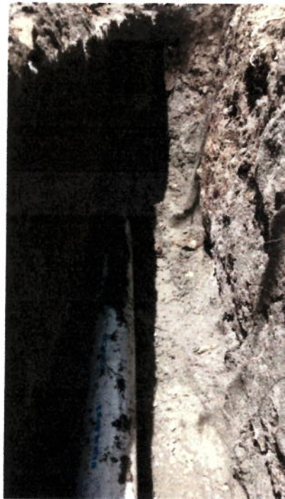
Sustitución de Arena
