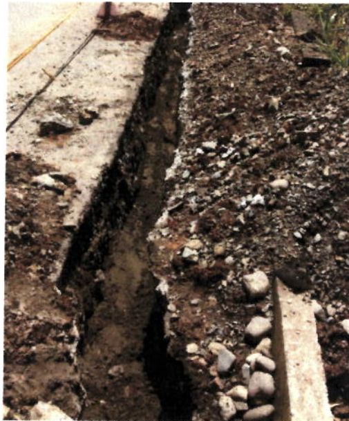
FIGURA N° 5 SUSTITUCIÓN DE ARENA LIMPIA
