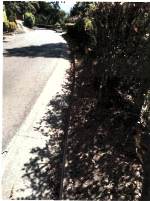
Lleno en zanja
