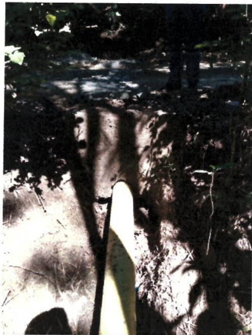
FIGURA N° 14. INSTALACIÓN DE TUBERÍA 6"
