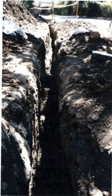
FIGURA N° 4. EXCAVACIÓN EN CONGLOMERADO
