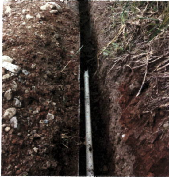
FIGURA N° 9. INSTALACIÓN DE TUBERÍA 3"
