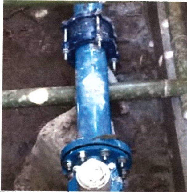
FIGURA N° 20. INSTALACIÓN DE UNION DE REPARACIÓN 4"
