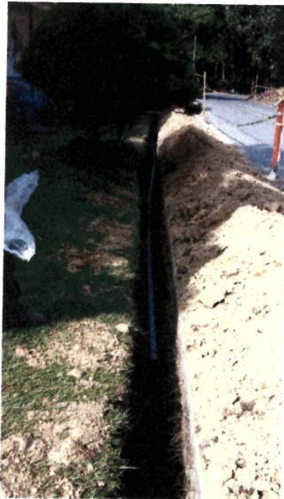
FIGURA N° 12. INSTALACIÓN DE TUBERÍA 2"
