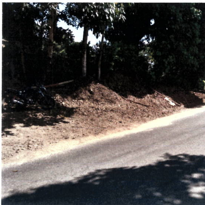
FIGURA N° 7. RELLENO DE ZANJA
