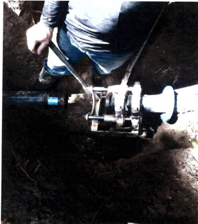
Emplame de tubería termofusion
