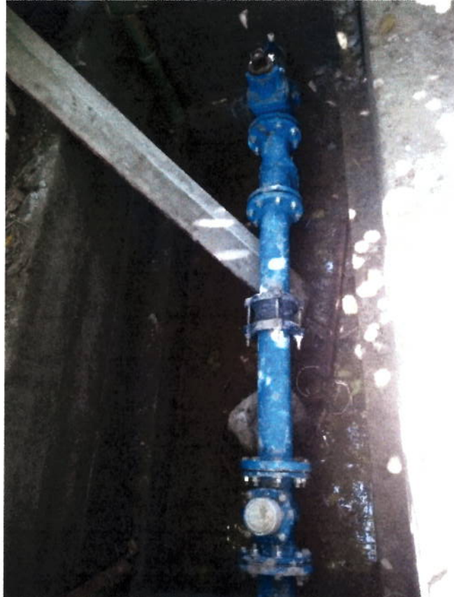
Instalación de Accesorios
