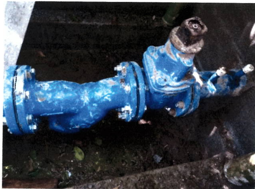
Instalación de válvula de compuerta de 4" y filtro de 4"
