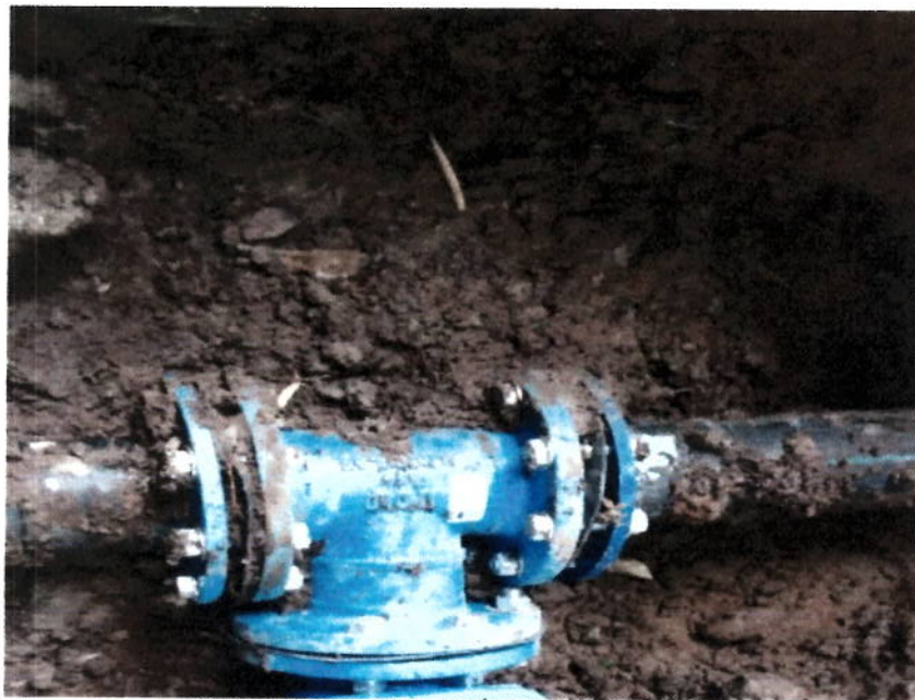
FIGURA N° 17. INSTALACIÓN DE TEE 4" X 4" HD.
