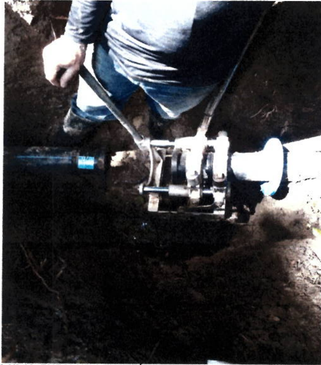
FIGURA N° 16. EMPALME A TUBERÍA EXISTENTE DE POLIETILENO POR TERMOFUSIÓN
