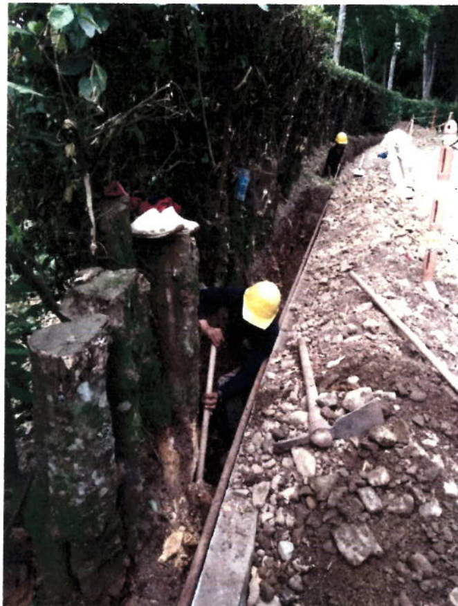
FIGURA N° 3. EXCAVACIÓN EN CONGLOMERADO
