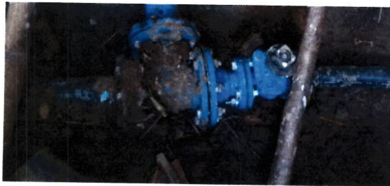
FIGURA N° 19. INSTALACIÓN DE REDUCCION DE 4" A 2" Y VÁLVULA DE COMPUERTA DE 2"
