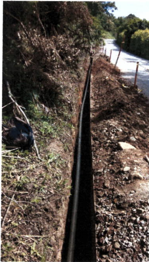
FIGURA N° 10. INSTALACIÓN DE TUBERÍA 3"
