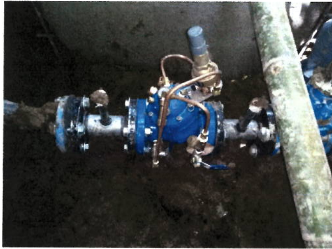
FIGURA N° 22. INSTALACIÓN VÁLVULA REDUCTORA DE PRESIÓN 2"
