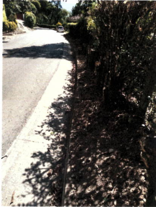
FIGURA N° 8. RELLENO DE ZANJA
