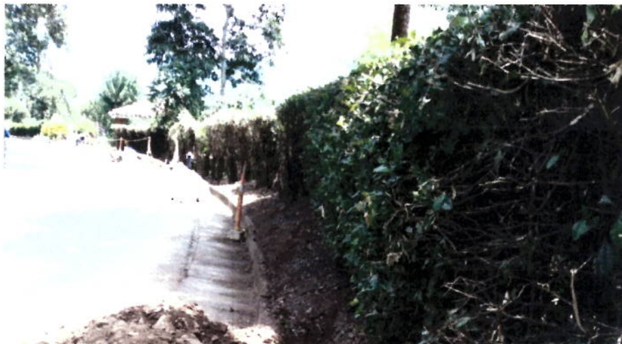
FIGURA N° 6. RELLENO DE ZANJA
