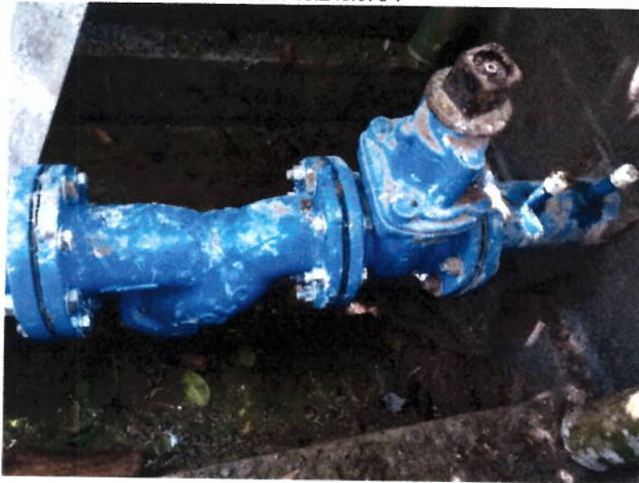
FIGURA N° 18. INSTALACIÓN PASAMUROS, VÁLVULA DE COMPUERTA DE 4" Y FILTRO DE 4"
