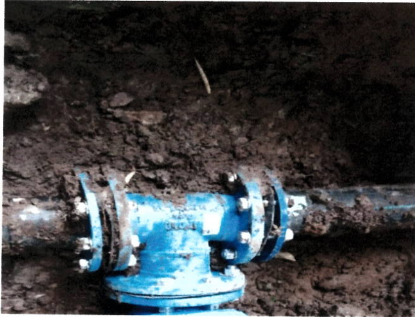
Instalación de Tee 4" x 4"
