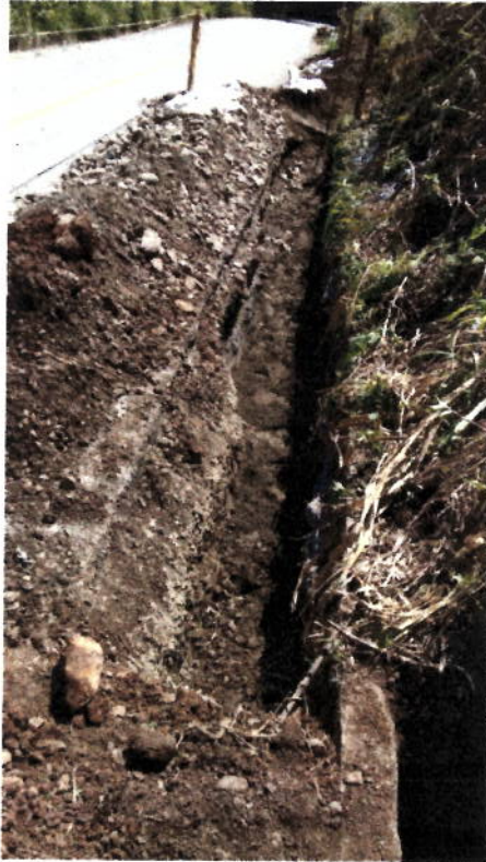
Sustitución de Arena
