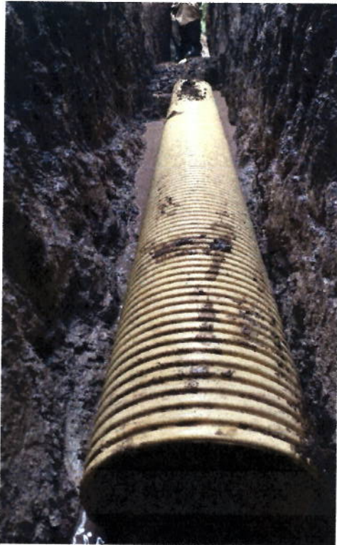
FIGURA N° 13. INSTALACIÓN DE TUBERÍA 8"
