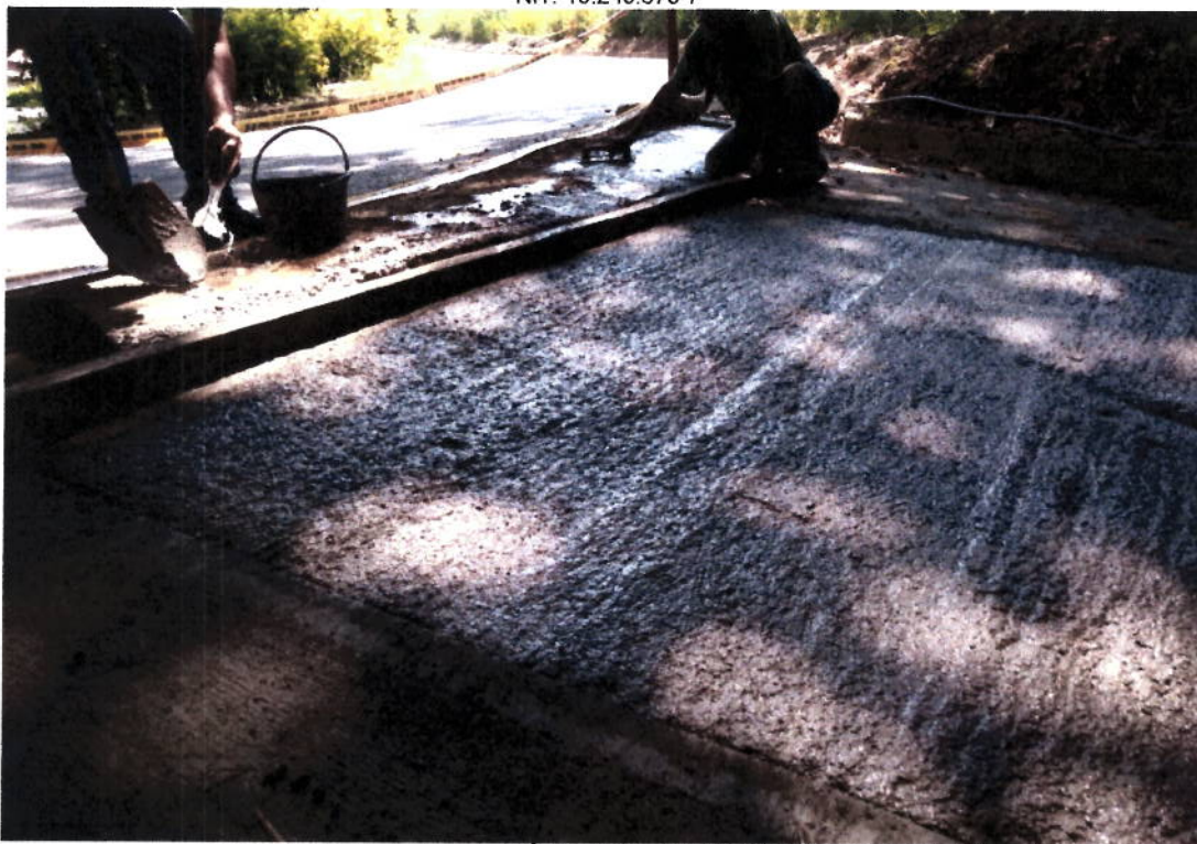
FIGURA N° 23. COLOCACIÓN DE PAVIMENTO HECHO EN OBRA.
