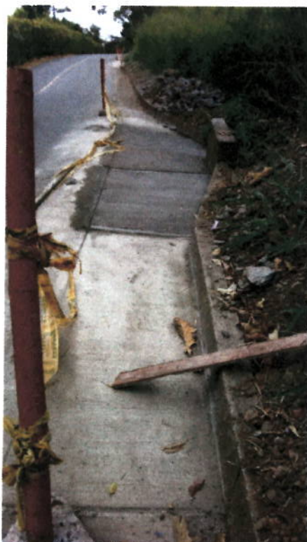
FIGURA N° 28. COLOCACIÓN DE PAVIMENTO HECHO EN OBRA.
