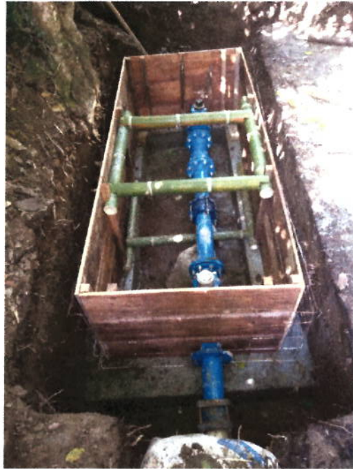
Encofrado para vaciado de caja.
