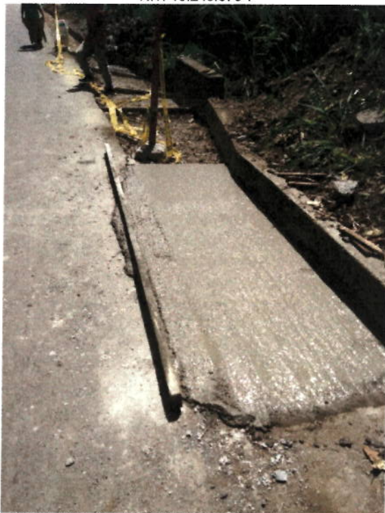
FIGURA N° 27. COLOCACIÓN DE PAVIMENTO HECHO EN OBRA.
