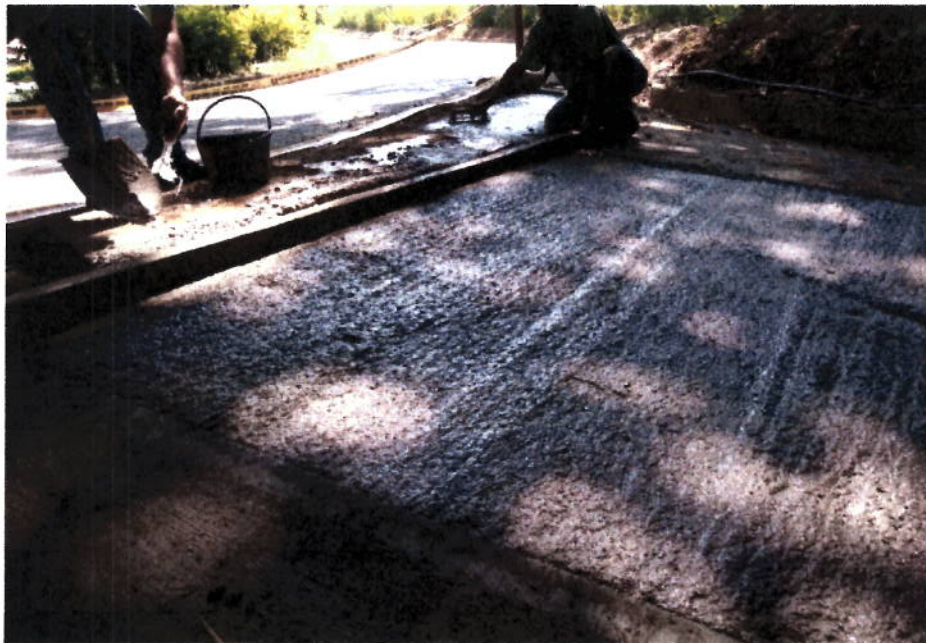
Colocación de pavimento hecho en obra.
