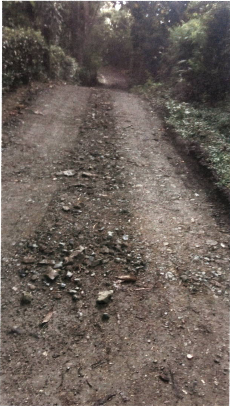
FIGURA N° 4. COLOCACIÓN DE AFIRMADO MEJORAMIENTO VIA CONDOMINIO LAS MARGARITAS.
