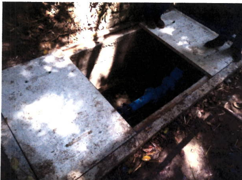
FIGURA N° 38. TAPAS CON MARCO Y CONTRAMARCO EN ANGULO DE 3/16 *2".
