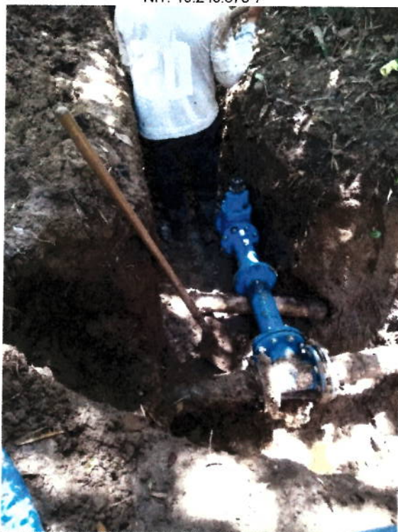
FIGURA N° 30. ADECUACIÓN DE TERRENO PARA COLOCACION DE CAJA.
