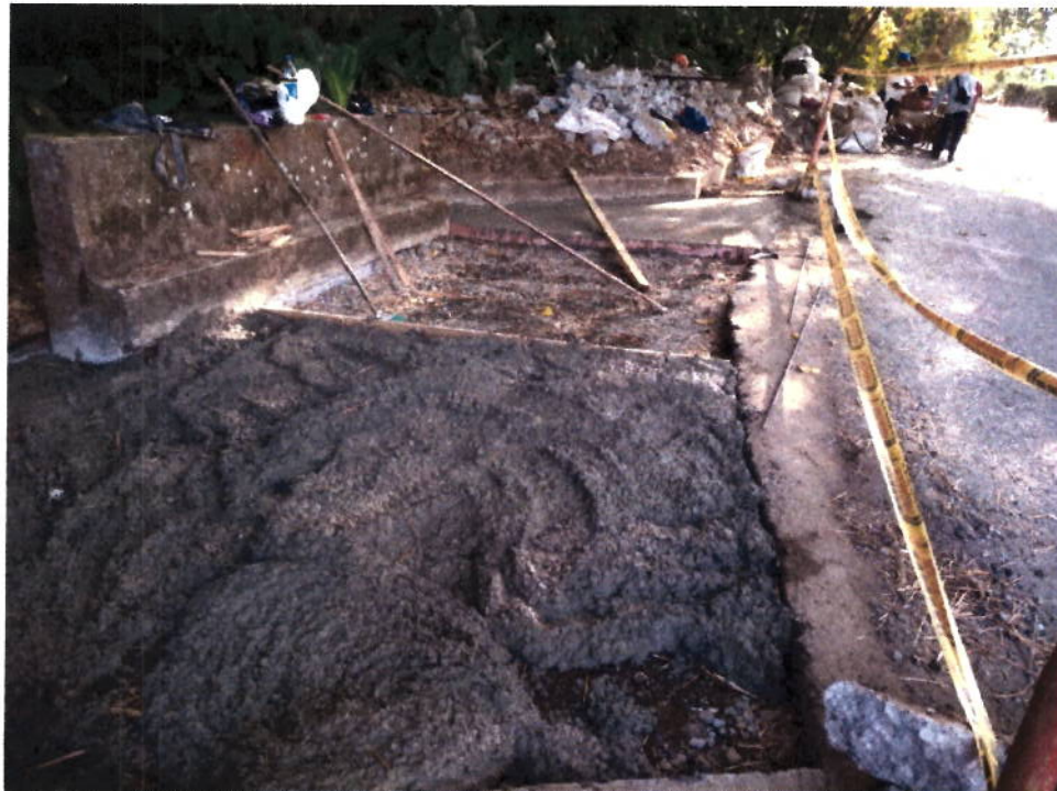
FIGURA N° 18. COLOCACIÓN DE PAVIMENTO HECHO EN OBRA.
