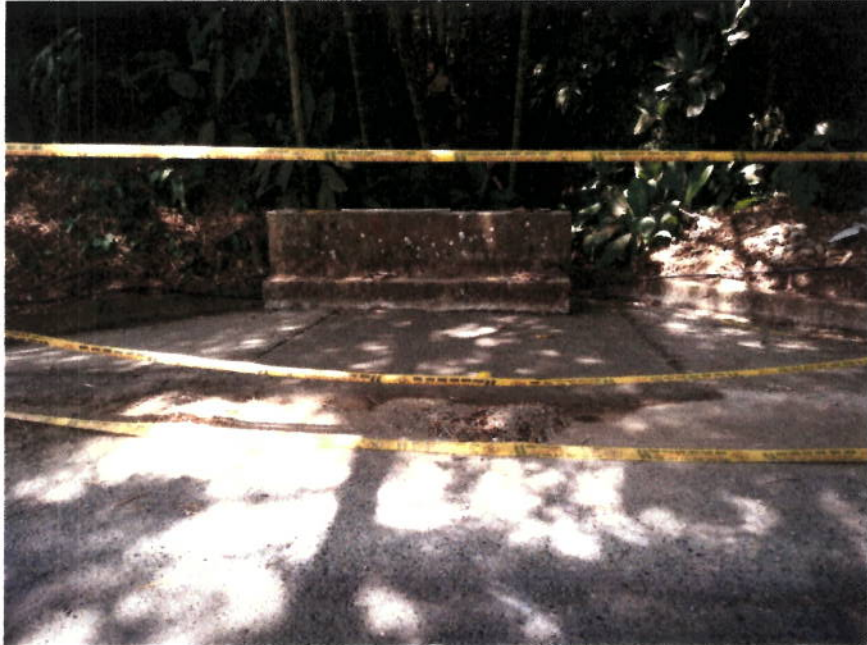
Colocación de pavimento hecho en obra.
