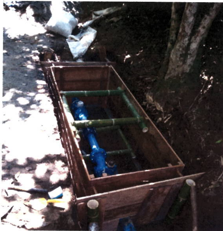
FIGURA N° 33. ENCOFRADO PARA VACIADO DE CAJA.
