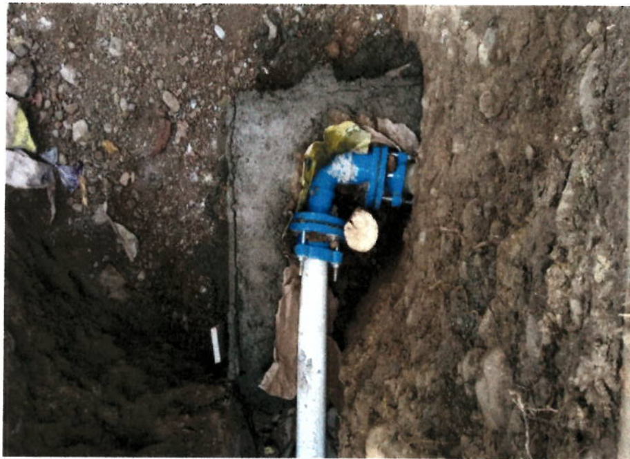
Anclaje de tubería y accesorios.
