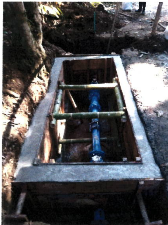
Vaciado de caja.
