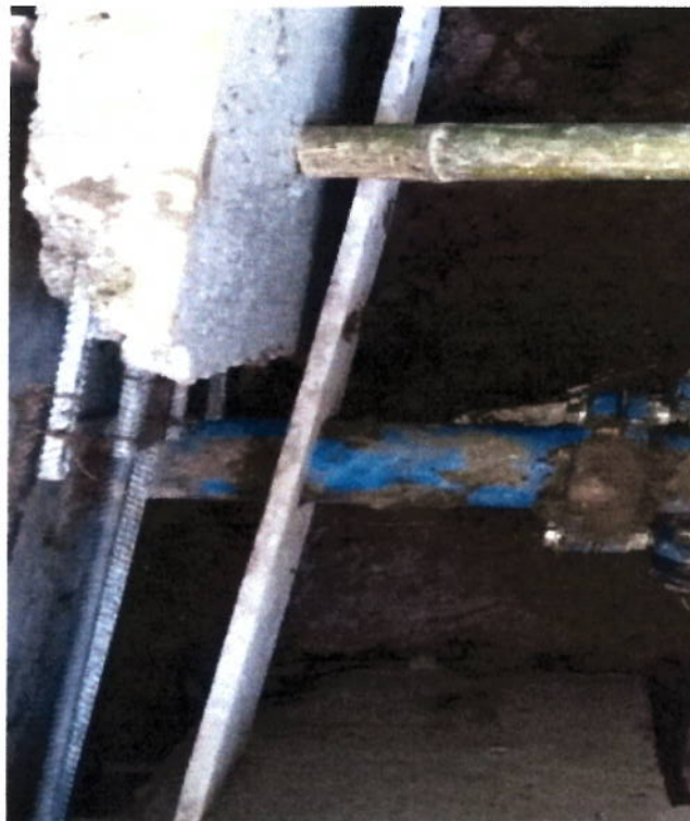
Colocación acero de refuerzo.
