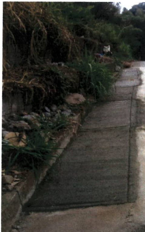
FIGURA N° 26. COLOCACIÓN DE PAVIMENTO HECHO EN OBRA.
