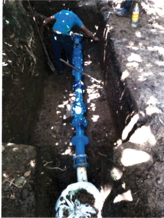
Excavación de terreno para colocación de caja.
