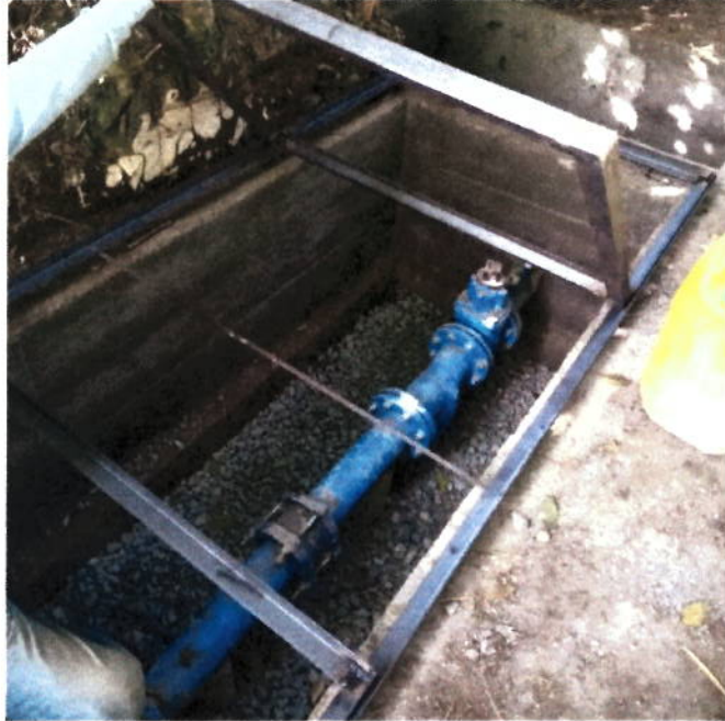
Cascajo para infiltración de piso en cajas.
