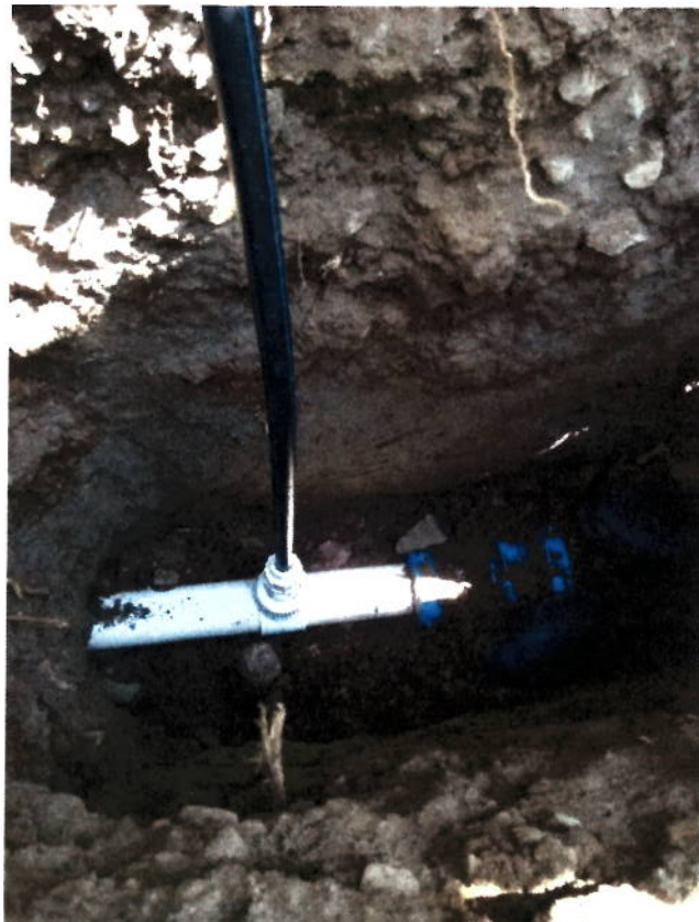
FIGURA N° 16. INSTALACIÓN DE ACOMETIDA.
