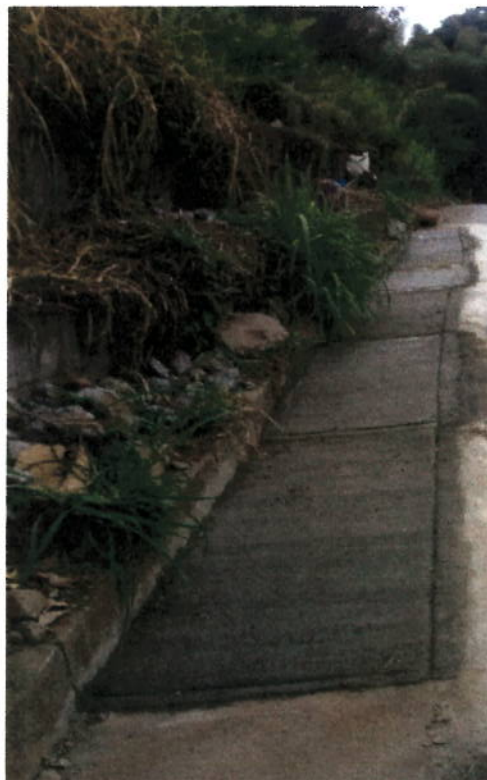
Colocación de pavimento hecho en obra.
