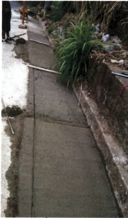
FIGURA N° 25. COLOCACIÓN DE PAVIMENTO HECHO EN OBRA.
