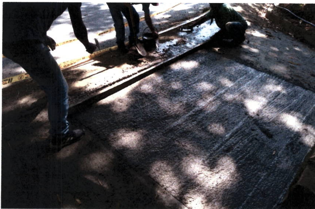
FIGURA N° 24. COLOCACIÓN DE PAVIMENTO HECHO EN OBRA.
