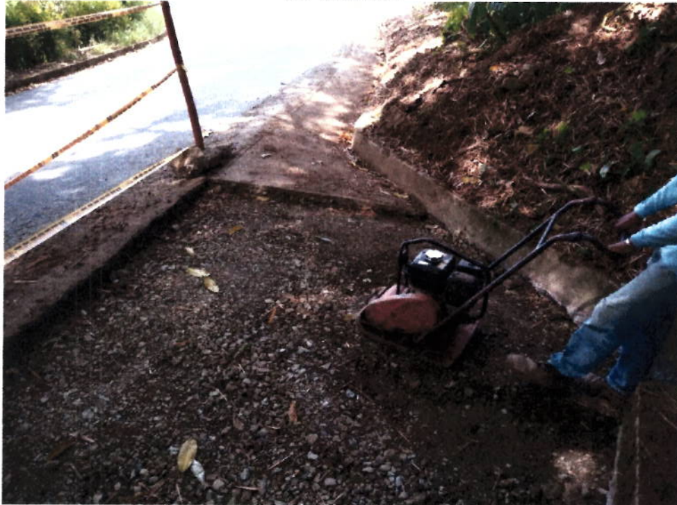
FIGURA N° 5 AFIRMADO COMPACTADO EN OBRA.
