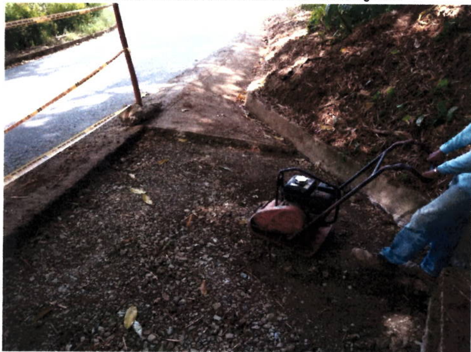
Colocación de afirmado en obras.
