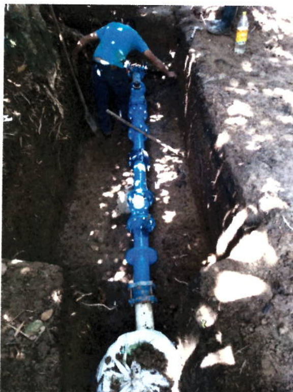
FIGURA N° 31. EXCAVACIÓN DE TERRENO PARA COLOCACIÓN DE CAJA.
