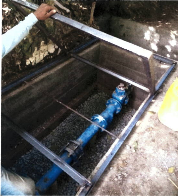
Instalación marco y contramarco en angulo de 3/16 *2. Y cascajo en piso.
