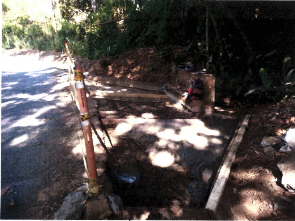
FIGURA N° 19. COLOCACION DE PAVIMENTO HECHO EN OBRA.
