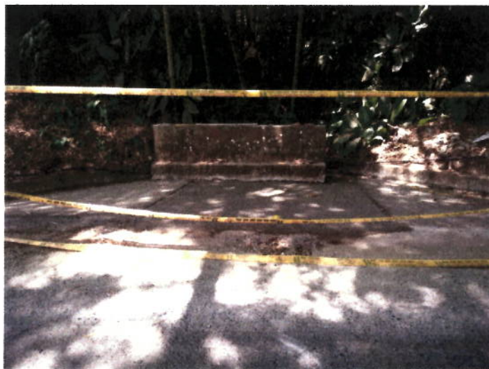
FIGURA N° 1. CERRAMIENTO EN OBRA.
