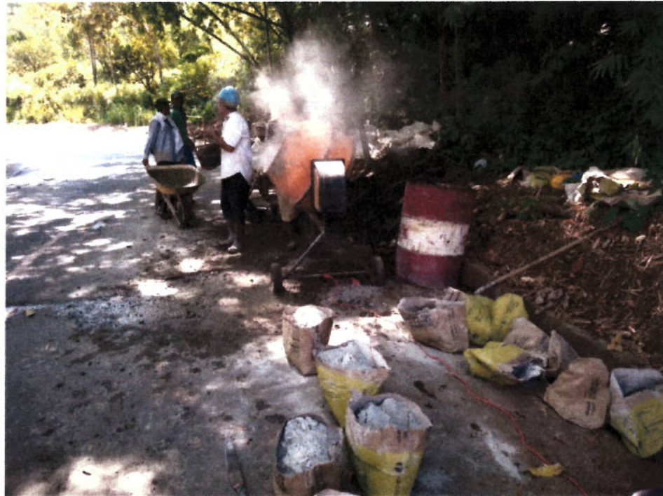
Colocación de pavimento hecho en obra.
