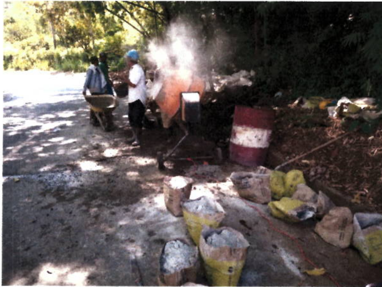
FIGURA N° 17. COLOCACIÓN DE PAVIMENTO HECHO EN OBRA.
