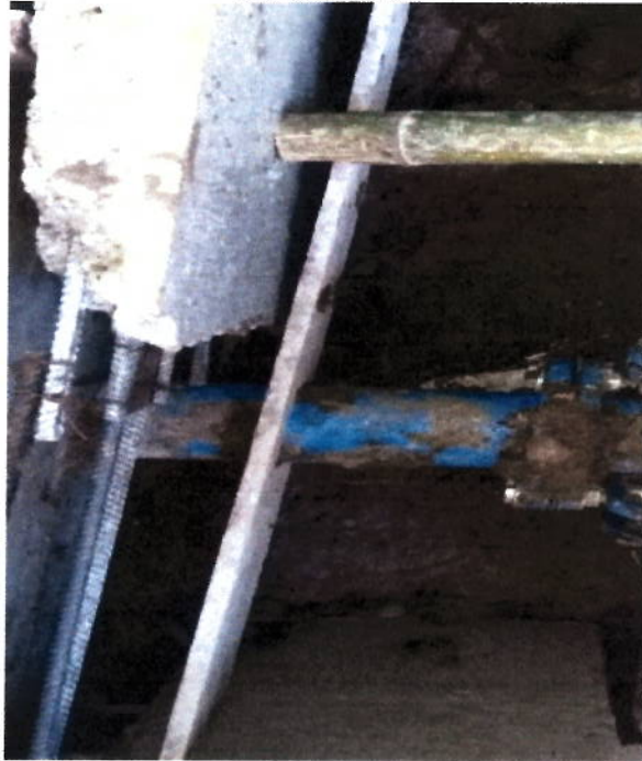
FIGURA N° 13. COLOCACIÓN ACERO DE REFUERZO.
