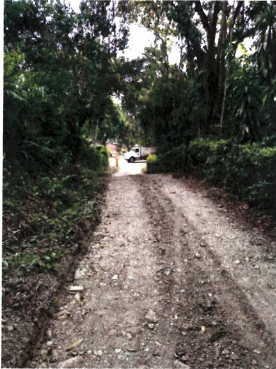
Colocación de afirmado en vía Condominio Las Margaritas
