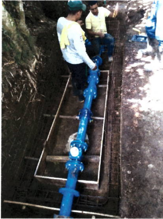
Colocación acero de refuerzo.
