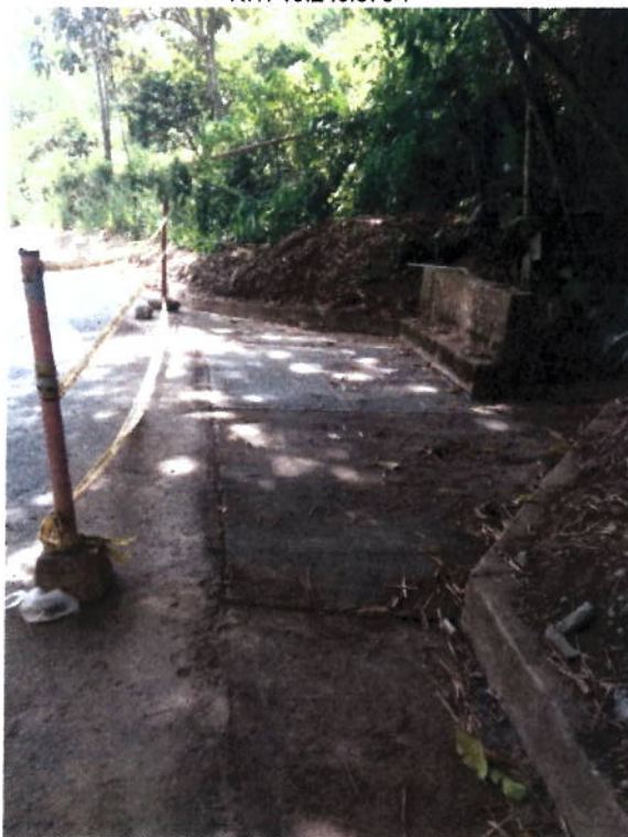
FIGURA N° 29. COLOCACIÓN DE PAVIMENTO HECHO EN OBRA.
