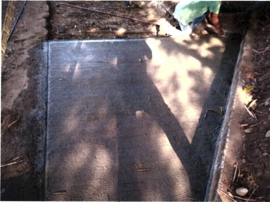
FIGURA N° 21. COLOCACIÓN DE PAVIMENTO HECHO EN OBRA.
