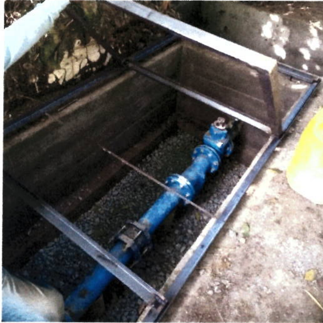
FIGURA N° 15. CASCAJO PARA INFILTRACIÓN DE PISO EN CAJAS.
