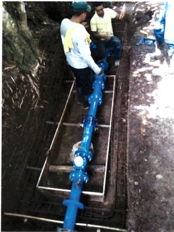
FIGURA N° 12. COLOCACIÓN ACERO DE REFUERZO.
