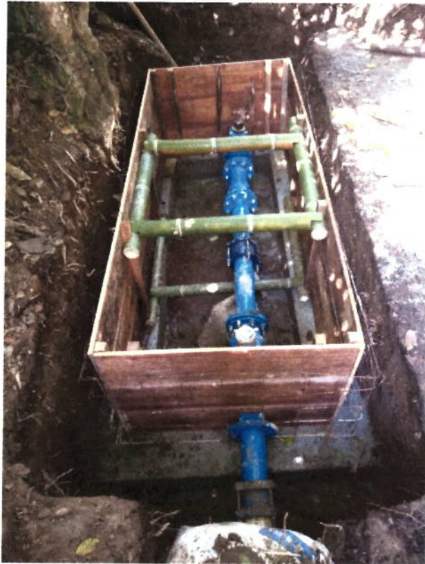
FIGURA N° 34. ENCOFRADO PARA VACIADO DE CAJA.
