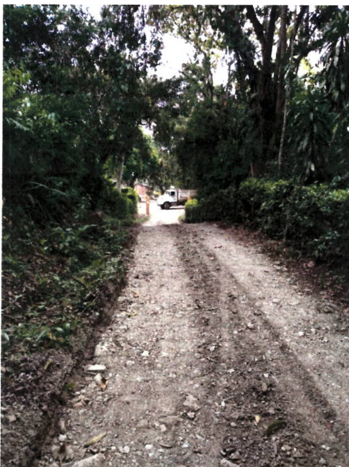
FIGURA N° 3. COLOCACIÓN DE AFIRMADO MEJORAMIENTO VIA CONDOMINIO LAS MARGARITAS.
