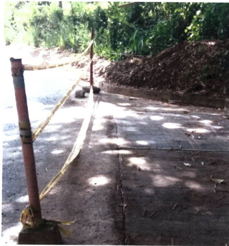
Instalación de Cerramiento
