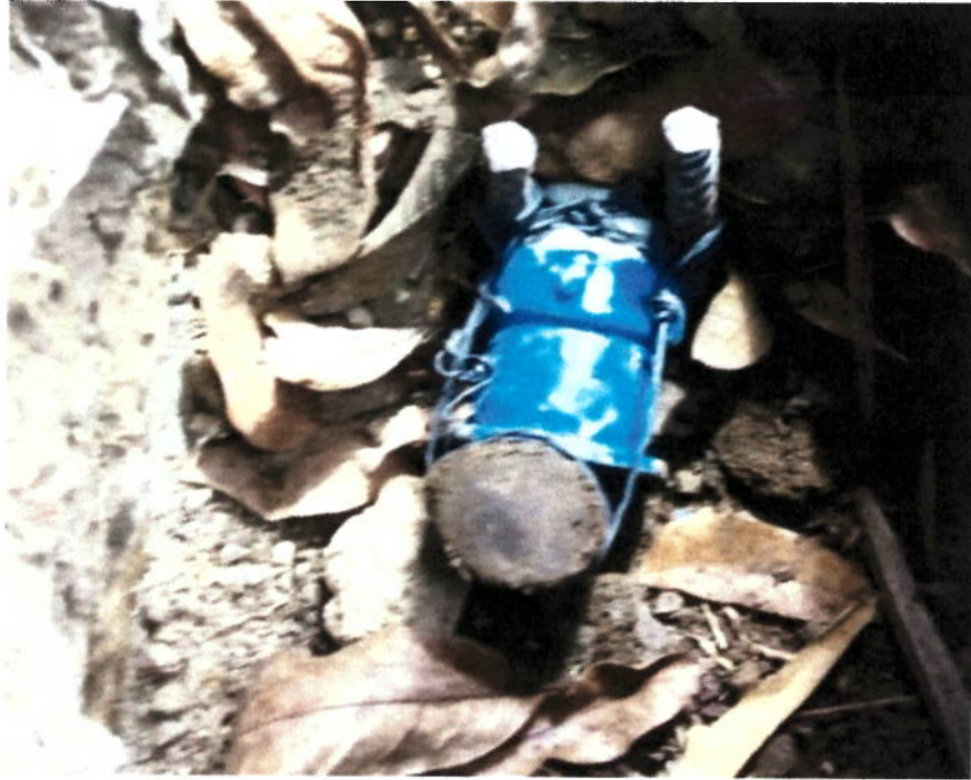
Anclaje de tubería y accesorios.
