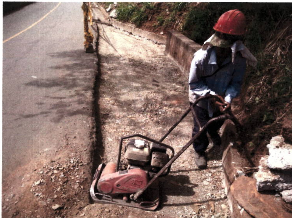
FIGURA N° 6 AFIRMADO COMPACTADO EN OBRA.
