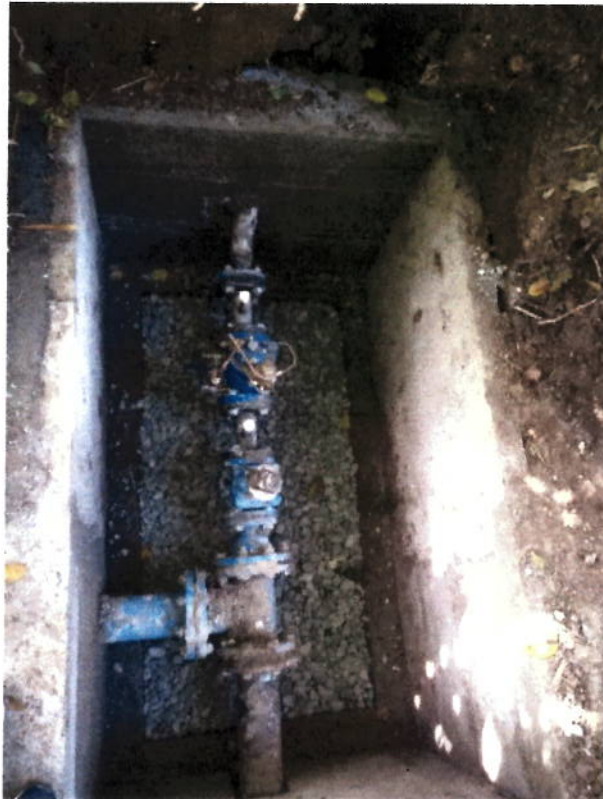
FIGURA N° 14. CASCAJO PARA INFILTRACIÓN DE PISO EN CAJAS.
