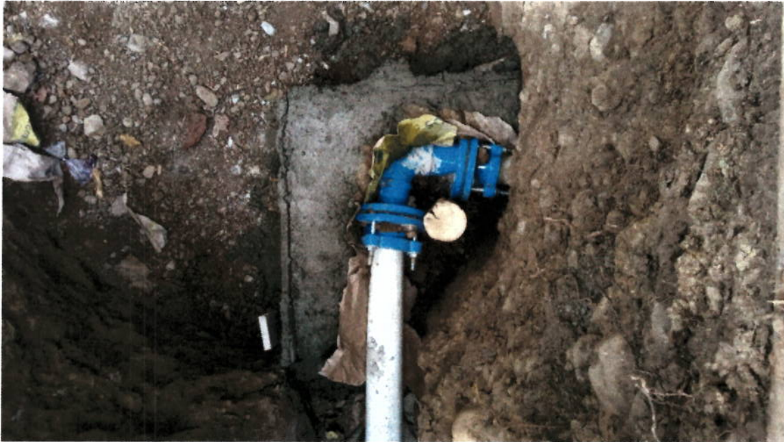
FIGURA N° 11. ANCLAJE DE TUBERÍA Y ACCESORIOS.
