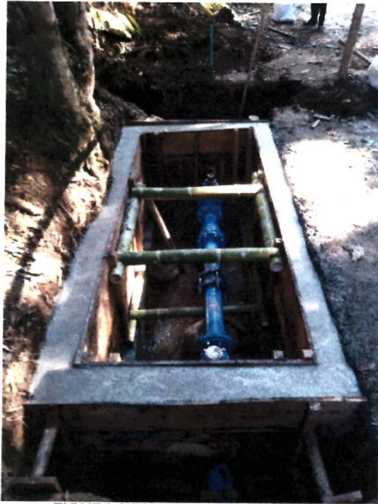
FIGURA N° 36. VACIADO DE CAJA.
