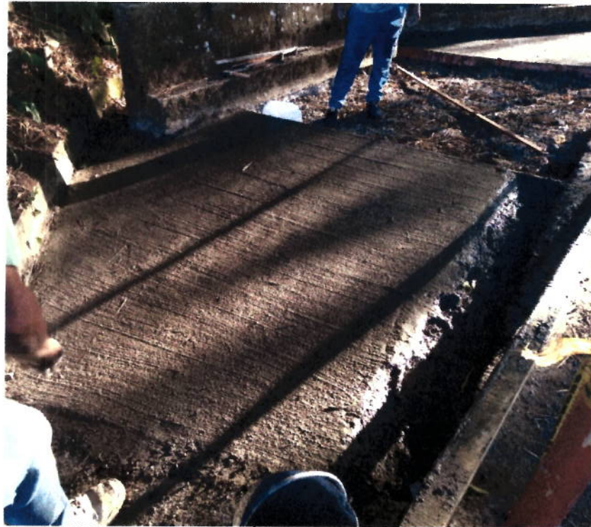
FIGURA N° 20. COLOCACION DE PAVIMENTO HECHO EN OBRA.
