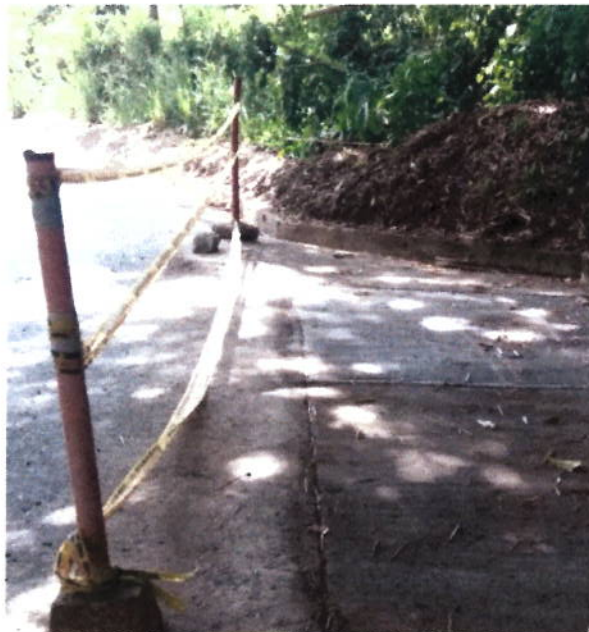
FIGURA N° 2. CERRAMIENTO EN OBRA.
