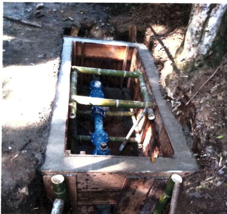
FIGURA N° 35. VACIADO DE CAJA.
