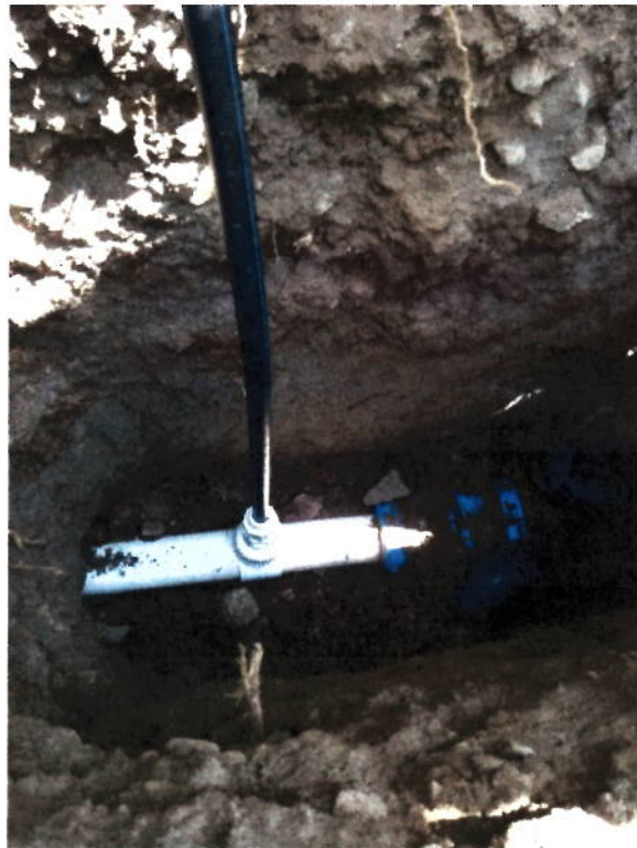
Colocación de acometida
