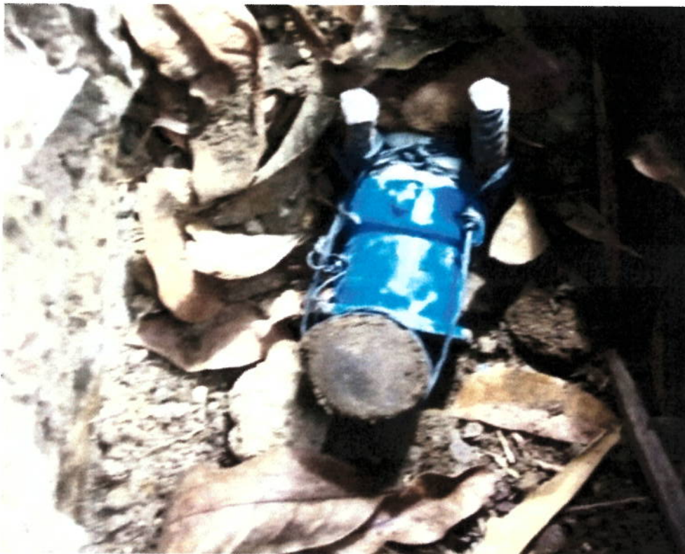
FIGURA N° 10. ANCLAJE DE TUBERÍA Y ACCESORIOS.
