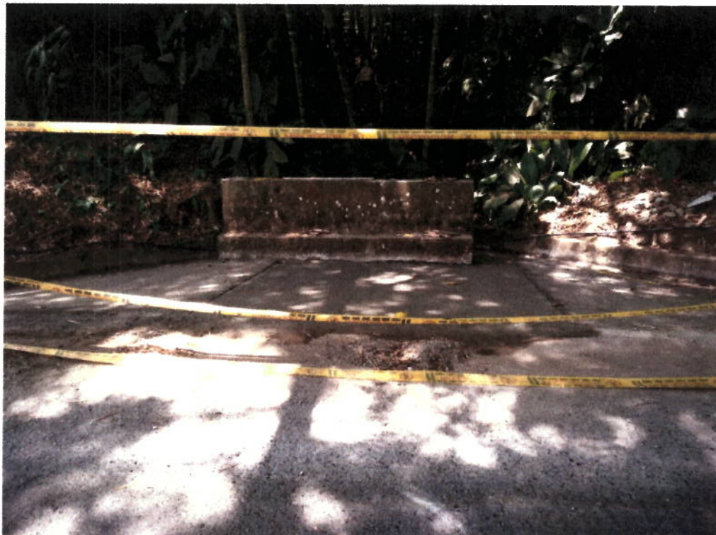
FIGURA N° 22. COLOCACIÓN DE PAVIMENTO HECHO EN OBRA.
