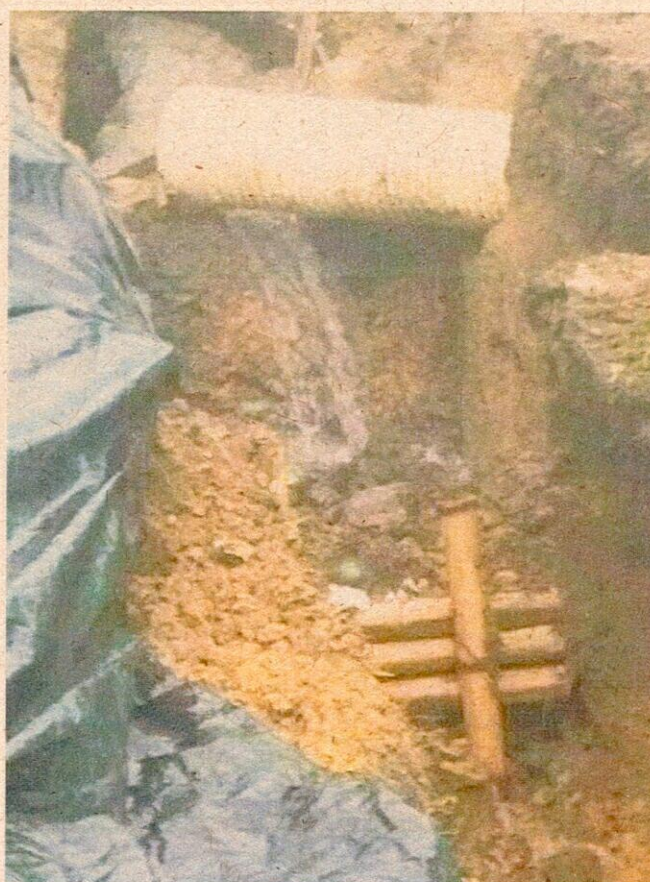
EXCAVACION EN ZANJA
