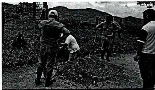
**FOTO 5.** Excavación y destapada para localización de daños sobre la aducción, sector La Palma.
