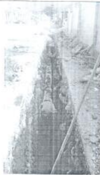
Instalación de Tubería
