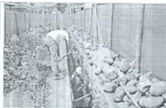
Excavaciones con presencia de roca
