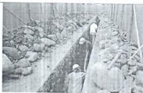
Excavaciones con presencia de roca
