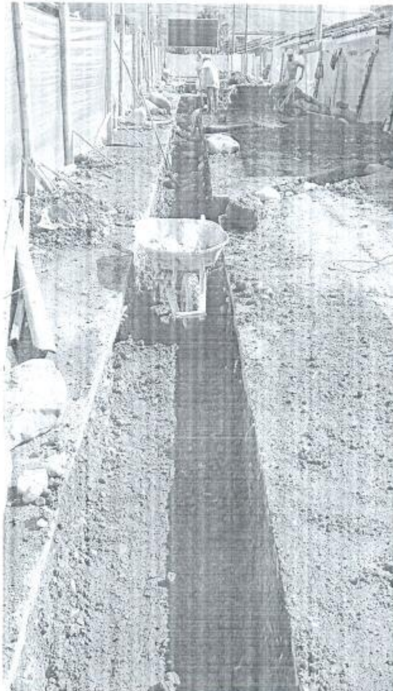
LLENO CON MATERIAL DE CANTERA DE PRESTAMO
