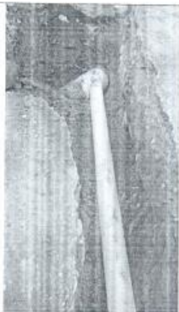
Instalación de domiciliarias
