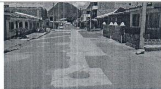
Estado final de las obras
