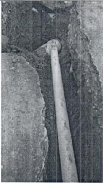
Instalación de domiciliarias
