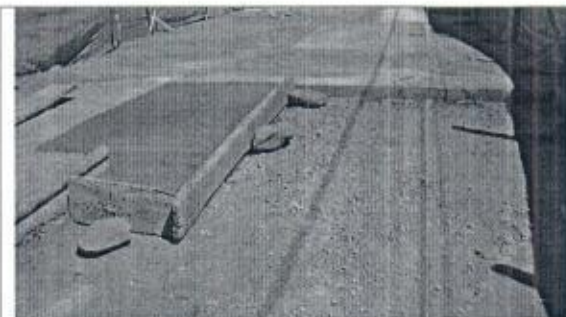
Vaciado de pavimento
