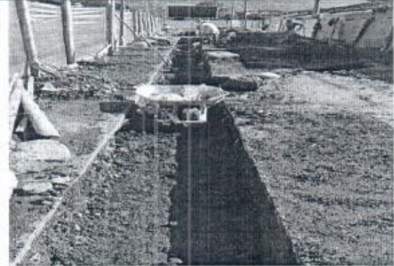
Llenos compactados con material de préstamo
