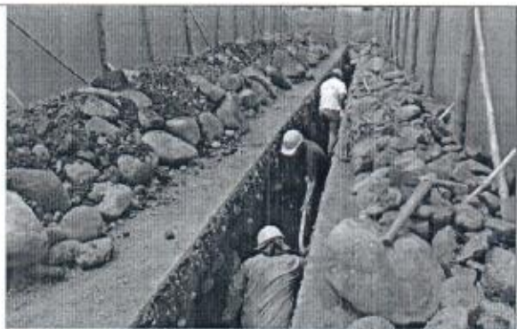
Excavaciones con presencia de roca
