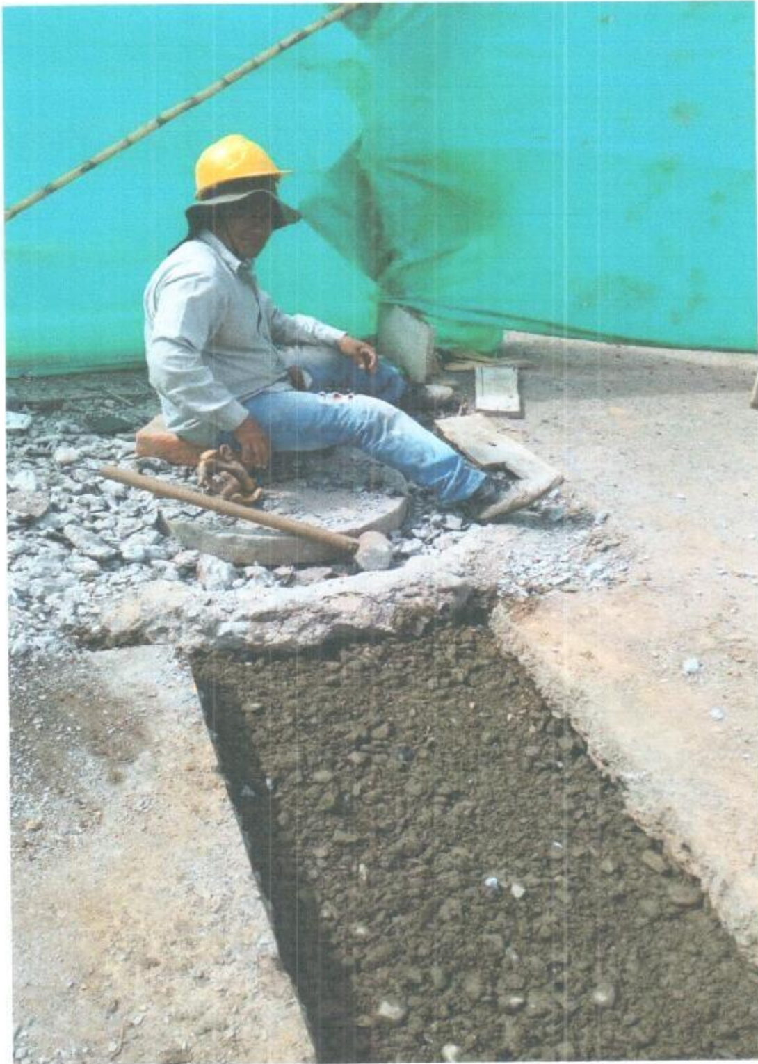
INSTALACION TAPAS DE FUNDICION PARA CAMARAS
