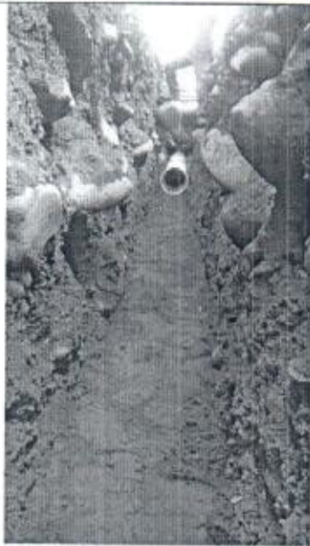
Rellenos con arena de nivelación
