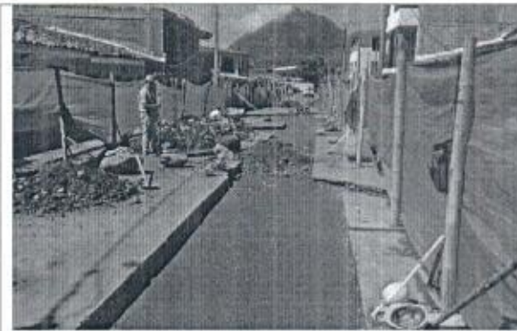
Llenos compactados con material Sub base
