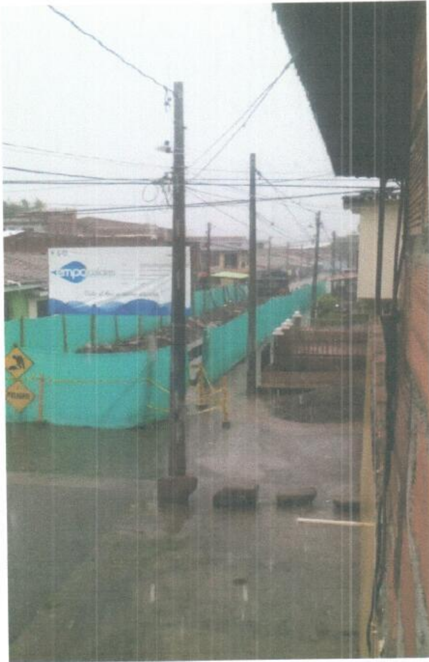
CERRAMIENTO EN TELA VERDE Y SOPORTE DE GUADUA
