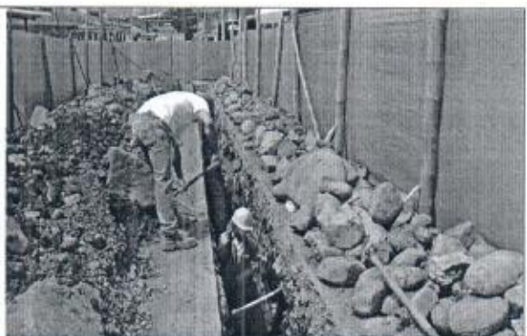
Excavaciones con presencia de roca
