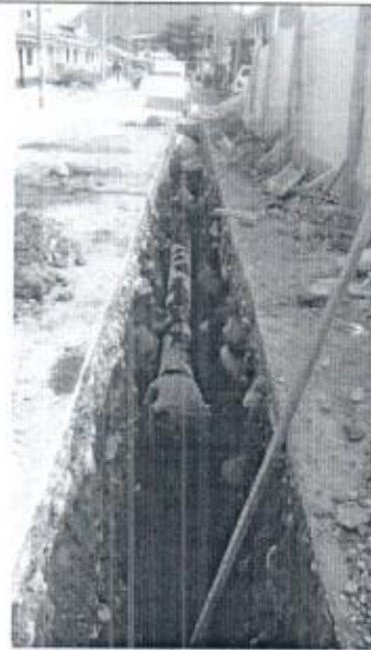
Instalación de Tubería
