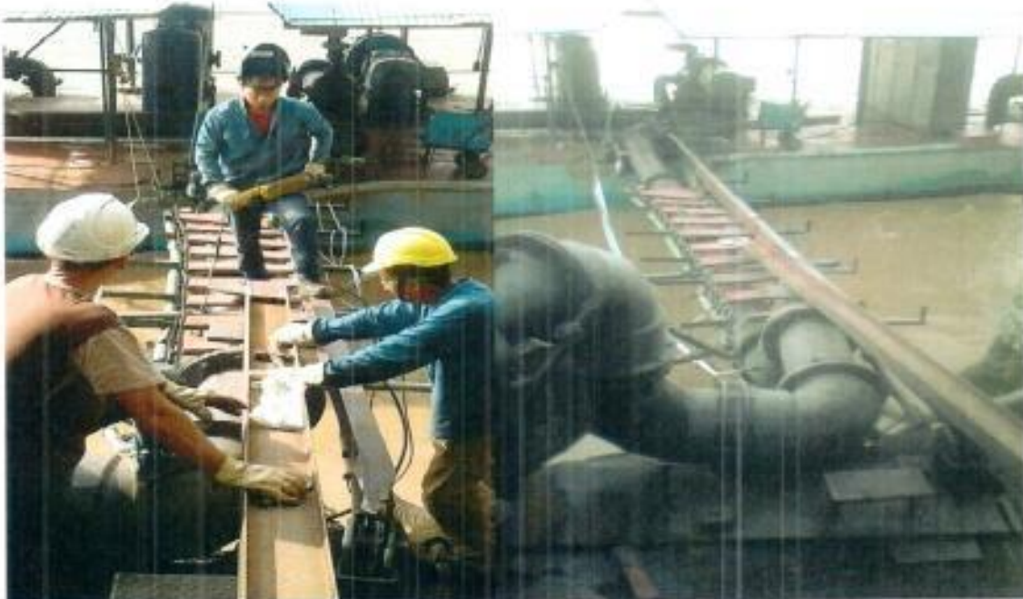
3. Diseño, elaboración e instalación de pasarela nueva.
