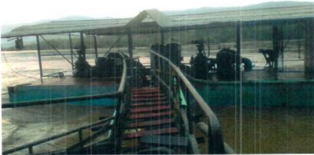
2. Desmonte de pasarela existente para realizar la instalación de la nueva.
