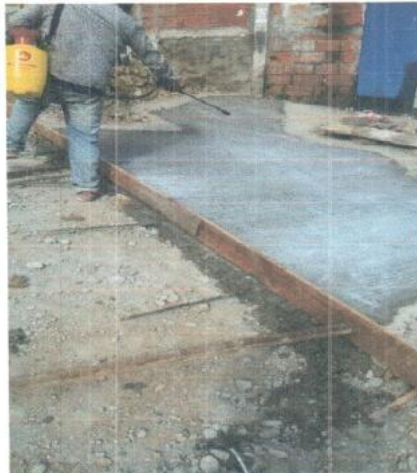
VACIADA DE PAVIMENTO Y PROTECCION
