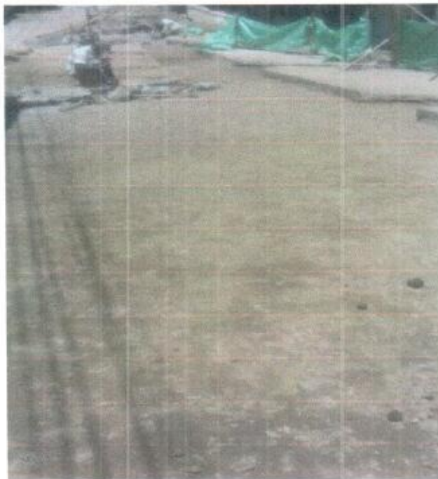
BASE LISTA PARA VACIAR PAVIMENTO
