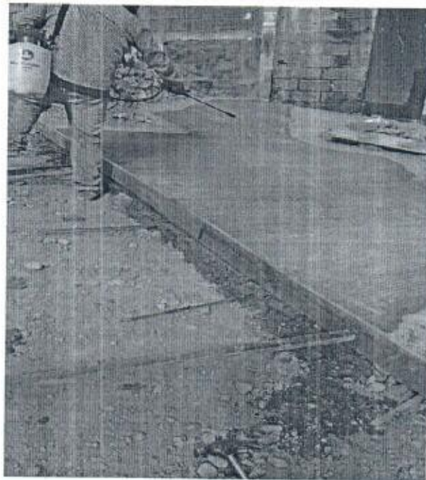
VACIADO DE PAVIMENTO Y PROTECCION
