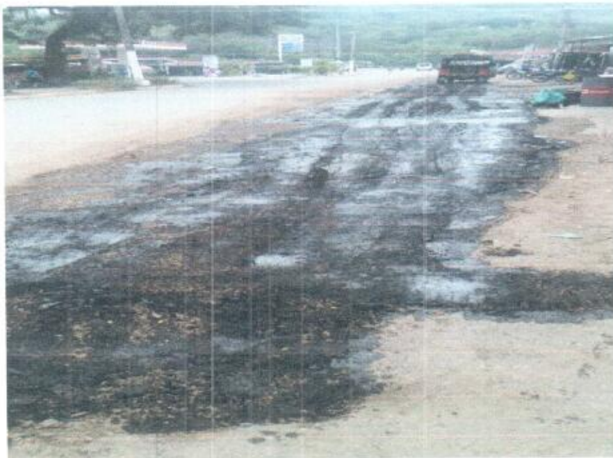
MATERIA GRANULAR PARA SELLADO DE RASANTE
