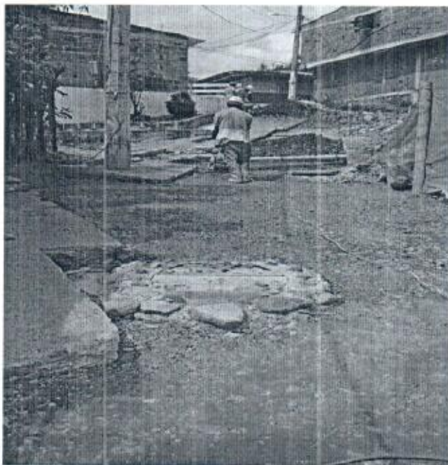
COMPACTACION BASE EN MATERIAL SELECCIONADO
