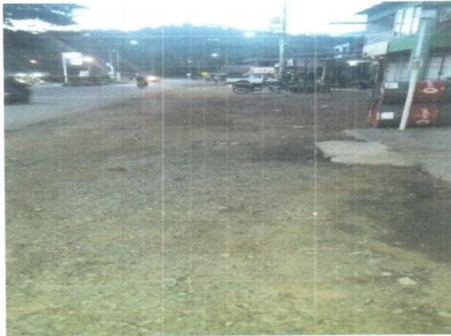
MATERIA GRANULAR COMPACTADO
