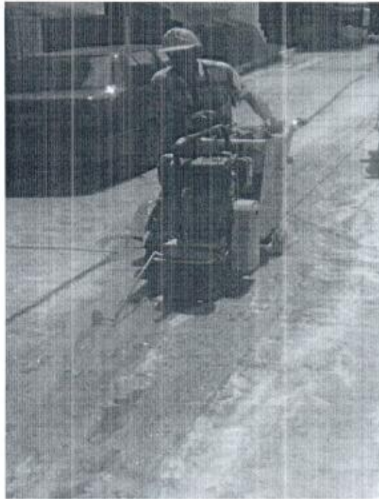
CORTE DE PAVIMENTO
