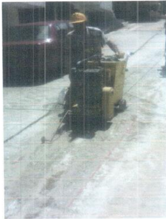
CORTE DE PAVIMENTO
