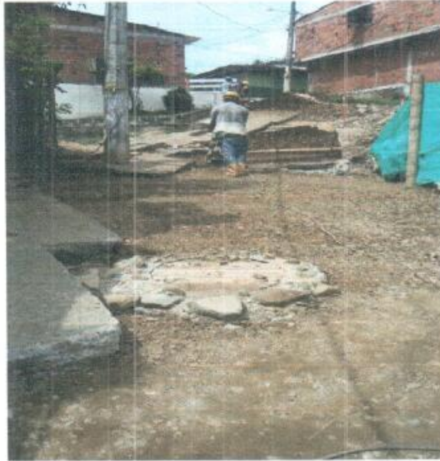
COMPACTACION BASE EN MATERIAL SELECCIONADO
