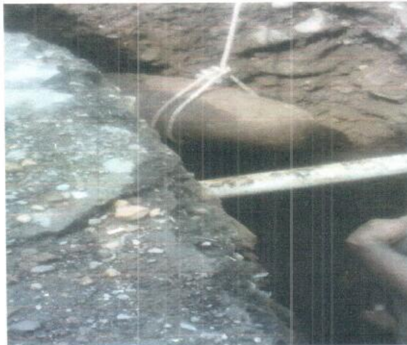
EXCAVACION EN ZANJA CON PRESENCIA DE ROCA
