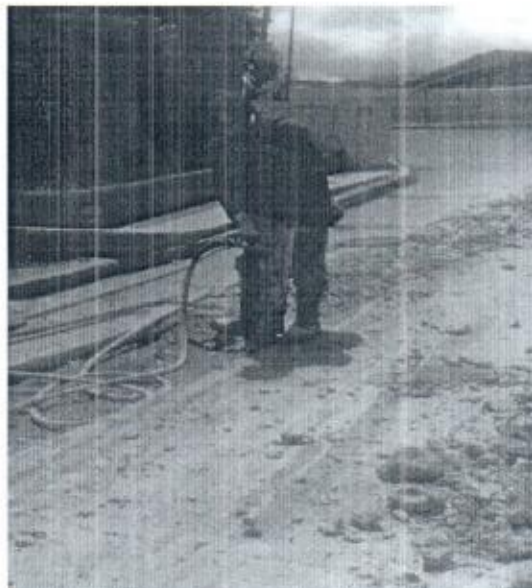
CORTE DE PAVIMENTO
