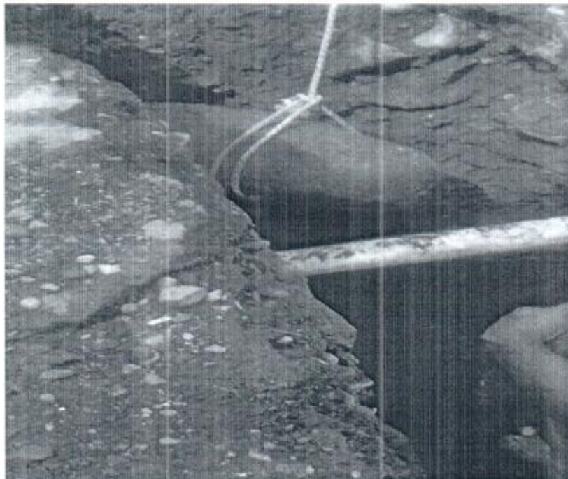
EXCAVACION EN ZANJA-CONGLOMERADO Y ROCA
