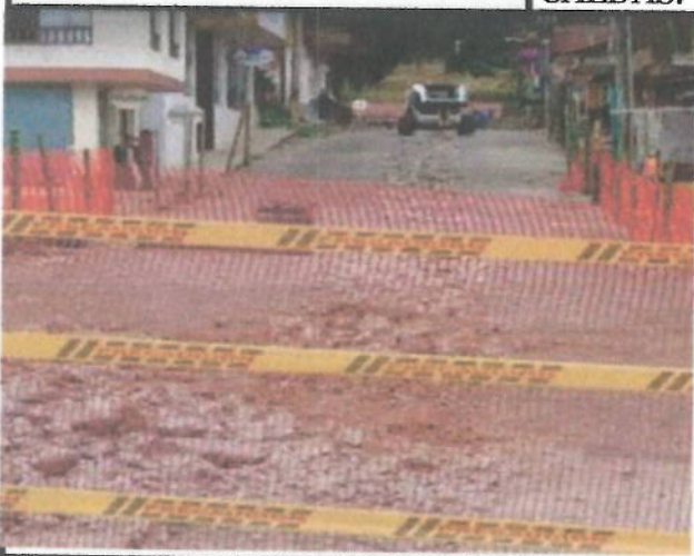
Descripción: Cerramiento con malla y soportes de guadua cada 2 metros
