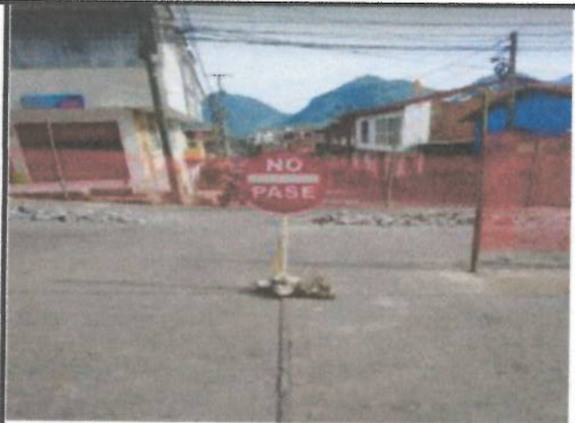
Descripción: Cerramiento con malla y soportes de guadua cada 2 metros
