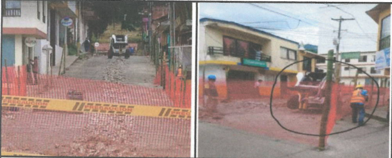
Descripción: Demolición de estructuras en concreto hidráulico Incluye andenes, gradería y cañuelas.
