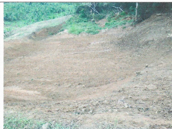
Construcción de Trinchos y perfilado del terreno
