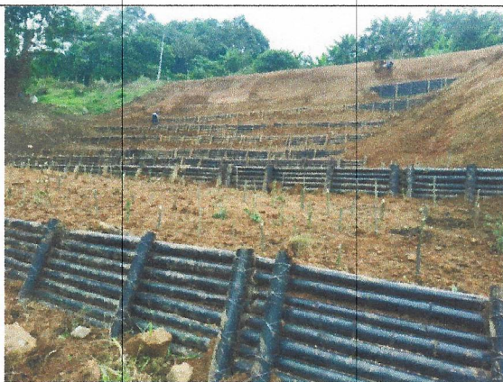
Construcción de Trinchos y perfilado del terreno
