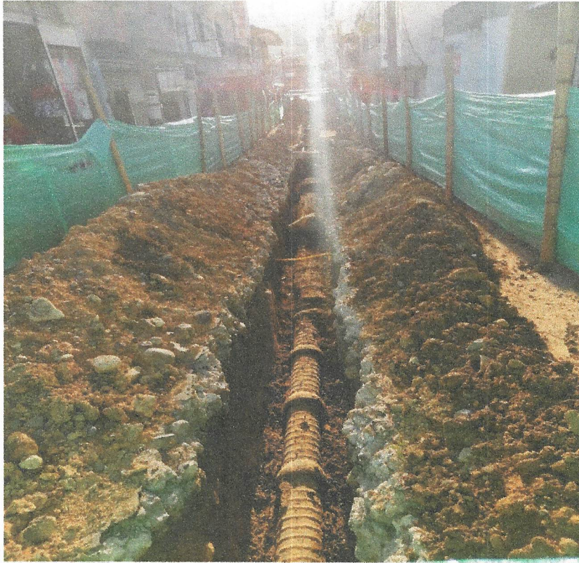
EXPOSICIÓN DE TUBERÍA EXISTENTE
