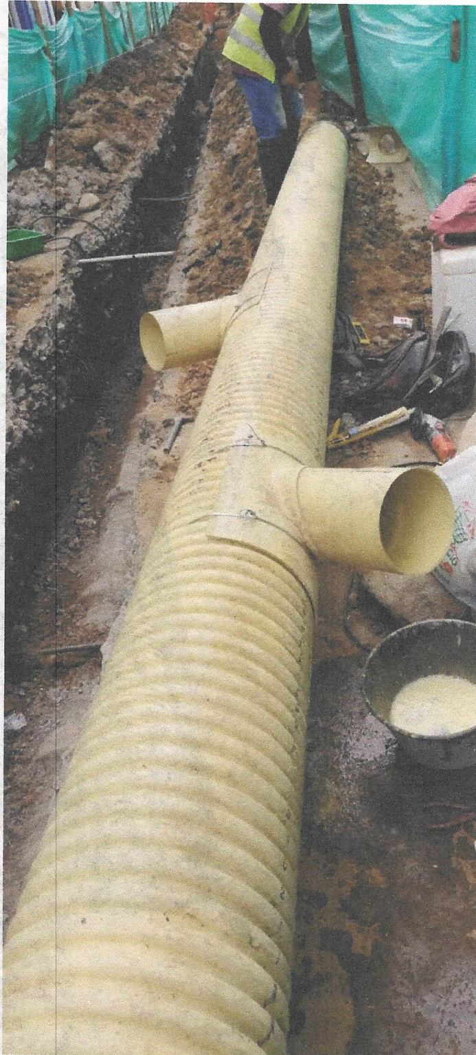
TUBERÍA LISTA PARA INSTALAR
