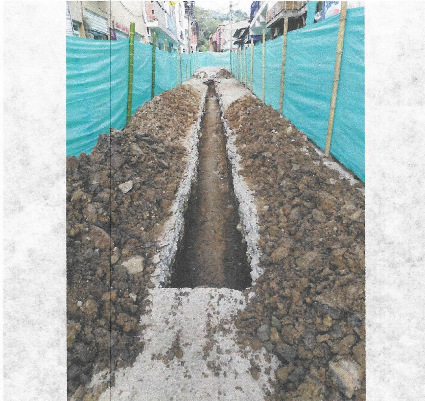
DEMOLICIÓN, EXCAVACIÓN Y CIERRE CON TELA VERDE
