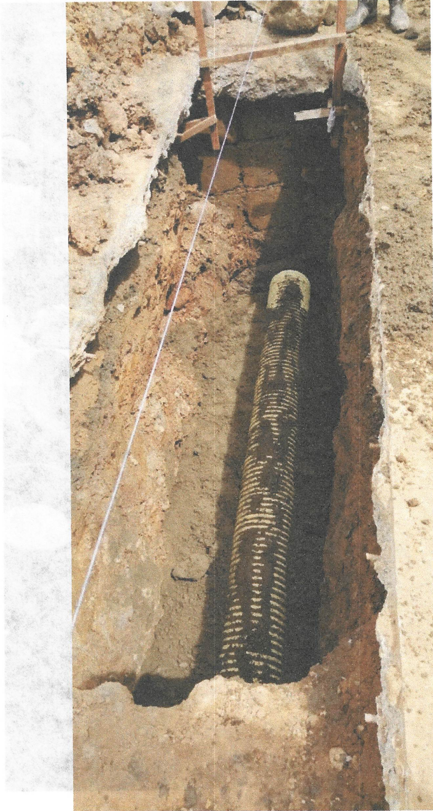
INSTALACIÓN DE TUBERÍA CON CAMA EN ARENA
