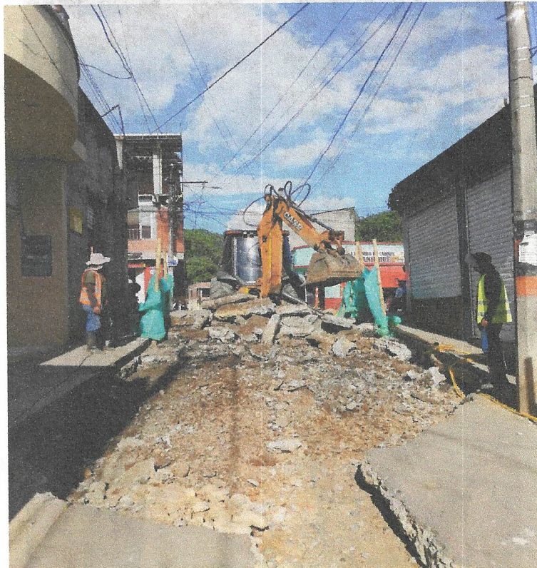
DEMOLICIÓN PARA REPOSICIÓN COMPLETA DE VÍA
