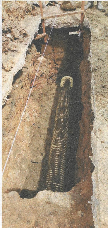
INSTALACIÓN DE TUBERÍA DE 14" NOVAFORT
