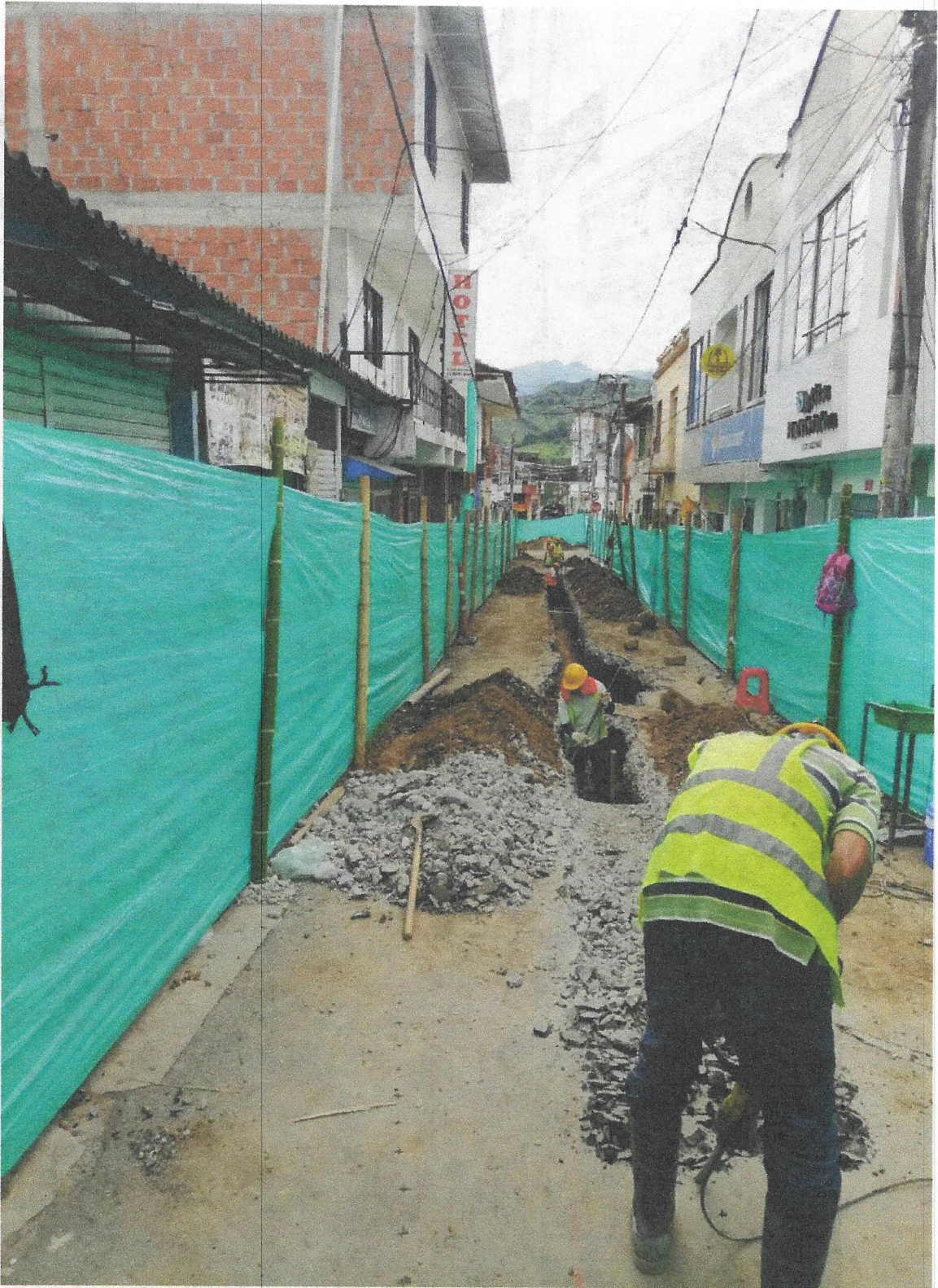
DEMOLICIÓN DE FRANJA
