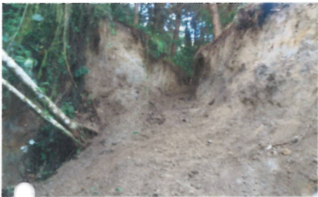
EXCAVACION PARA BAJAR TUBERIA DE 8"
