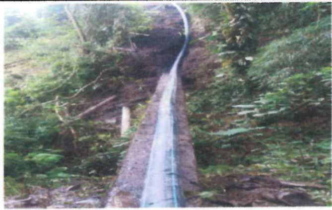
TUBERIA PF ASEGIURADA A VIADUCTO
