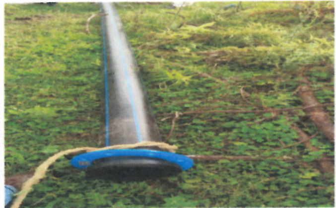
TERMOFUSION PORTAFLANCHE Y BRIDA
