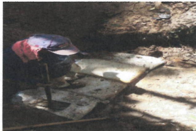
COMPACTACION MANUAL SACOS DE TIERRA
