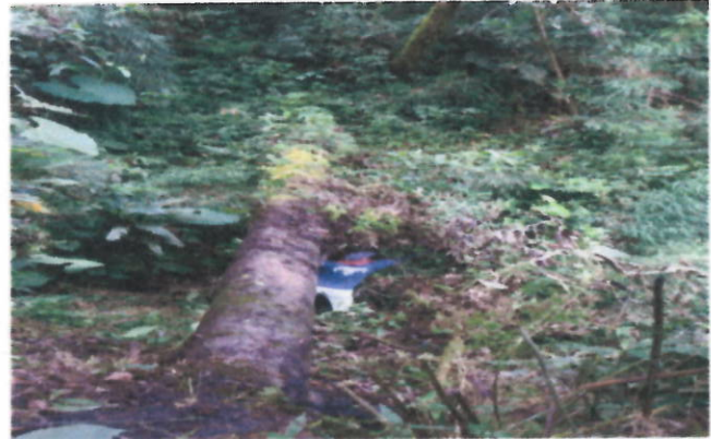
VIADUCTO PROTECCION TUBERIA
