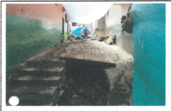
PROTECCION DE BRECHA
