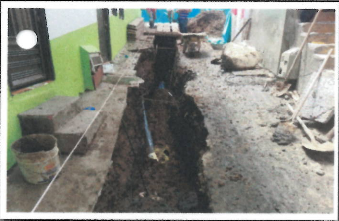
INSTALACION TUBERIA YSILLETAS
