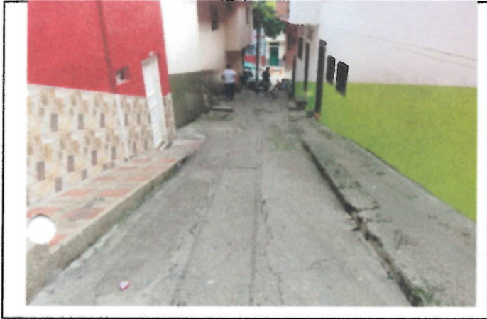
ASPECTO INICIAL SITIO DE LA OBRA
