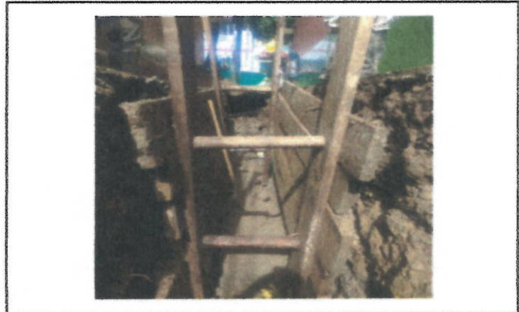
ENTIBADO DE BRECHA
