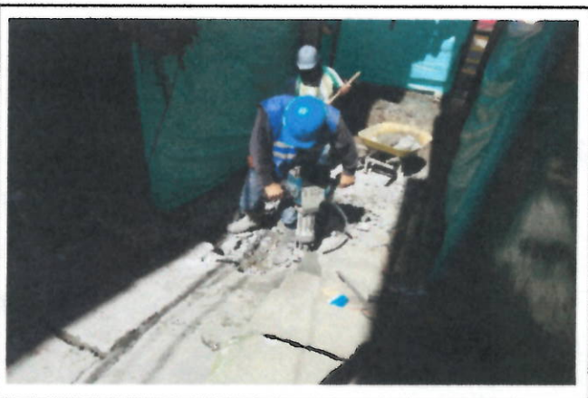
DEMOLICION PAVIMENTO EXISTENTE
