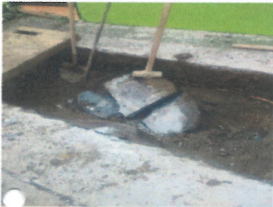
DEMOLICION DE ROCAS
