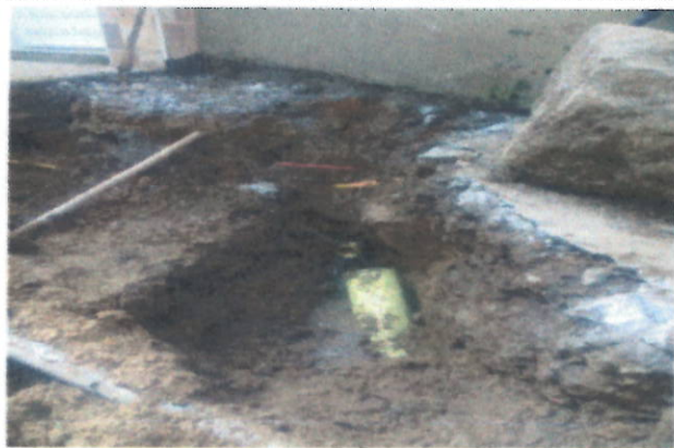
ACOMETIDAS DE ALCANTARILLADO VIVIENDAS EN PVC
