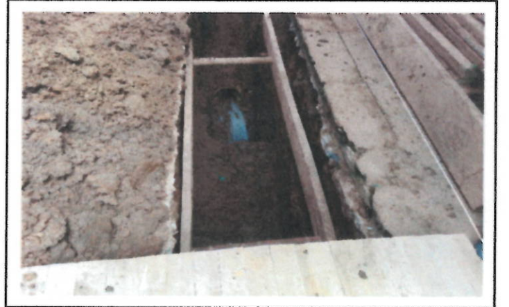
ENTIBADO DE BRECHA
