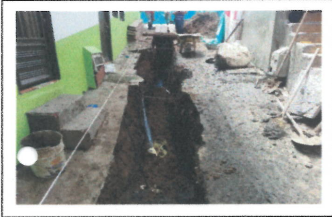
INSTALACION TUBERIA MANEJO DE AGUAS RESIDUALES
