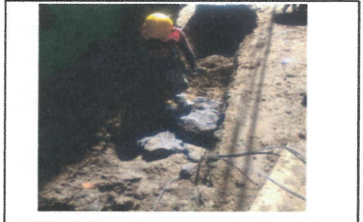
DEMOLICION DE ROCAS
