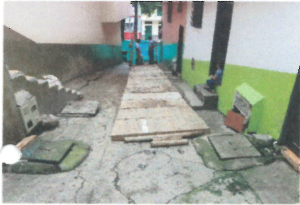
PROTECCION DE PEATONES TAPADA DE BRECHA
