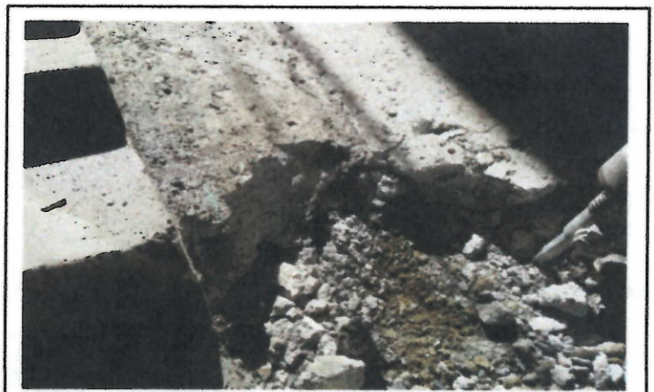
DEMOLICION PAVIMENTO EXISTENTE
