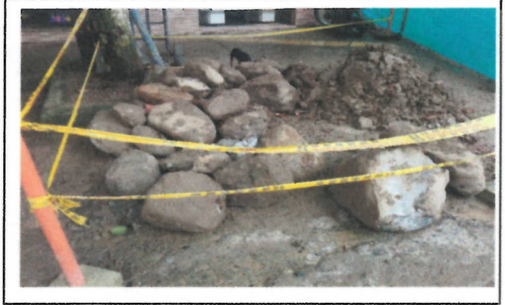
MATERIAL ROCOSO EXTRAIDO DE LA EXCAVACION
