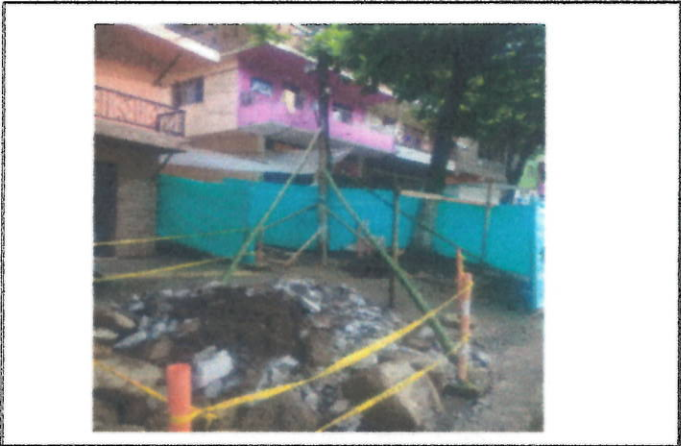
APUNTALAMIENTO DE POSTE
