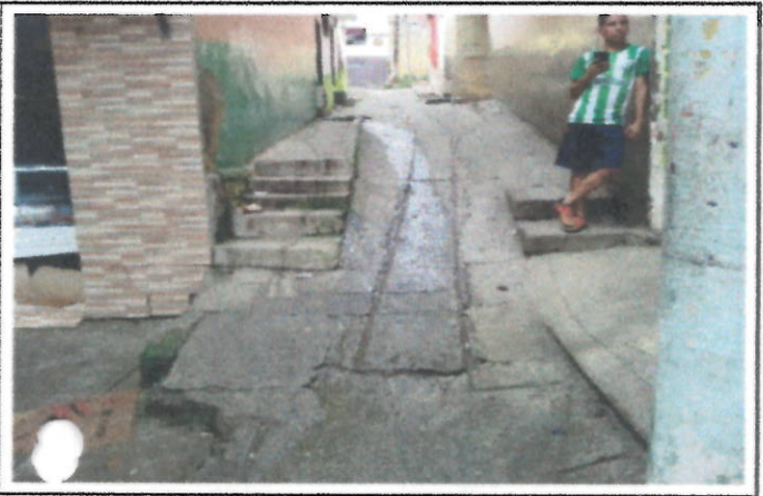
ASPECTO INICIAL CALLE 10 VIA PEATONAL
