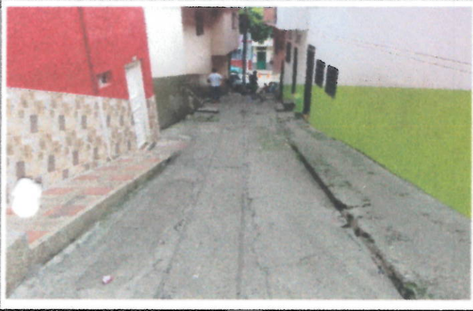
ASPECTO INICIAL CALLE 10 VIA PEATONAL
