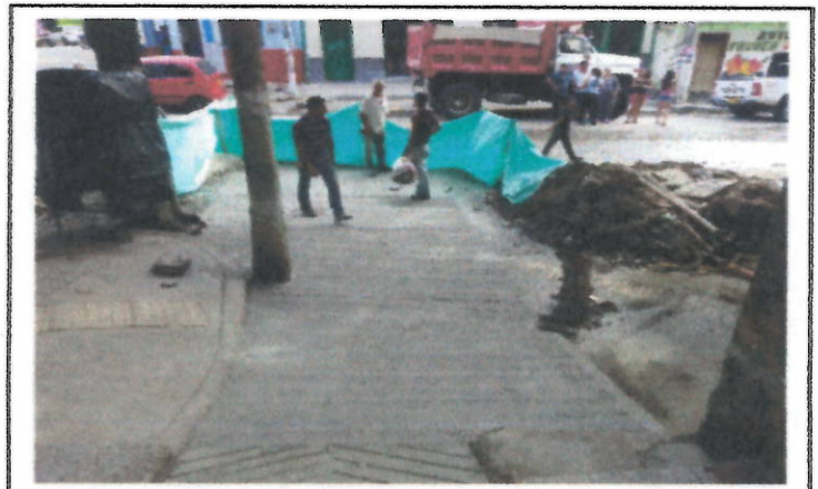
ASPECTO FINAL CALLE 10 CRA 4
