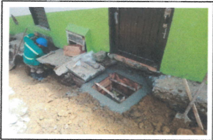
CAJAS DE INSPECCION DOMICILIARIAS
