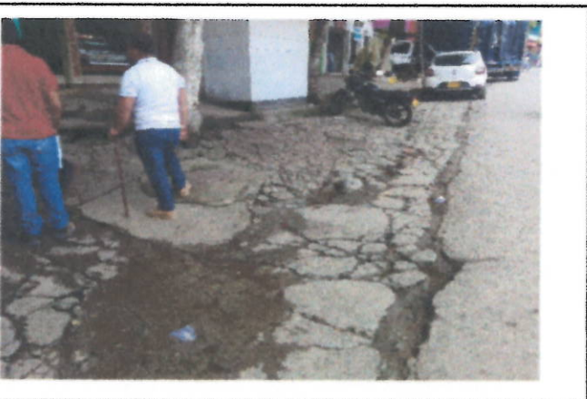
ASPECTO INICIAL CALLE 10 CRA 4 VIA HACIA MANIZALES
