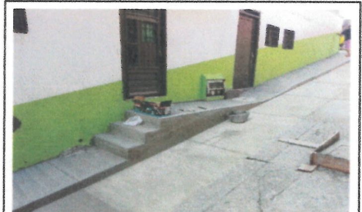
ASPECTO FINAL PEATONAL CALLE 10
