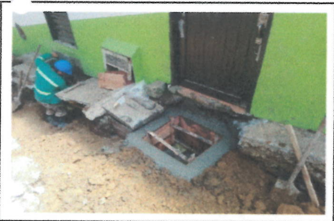
CAJAS DE INSPECCION DOMICILIARIAS
