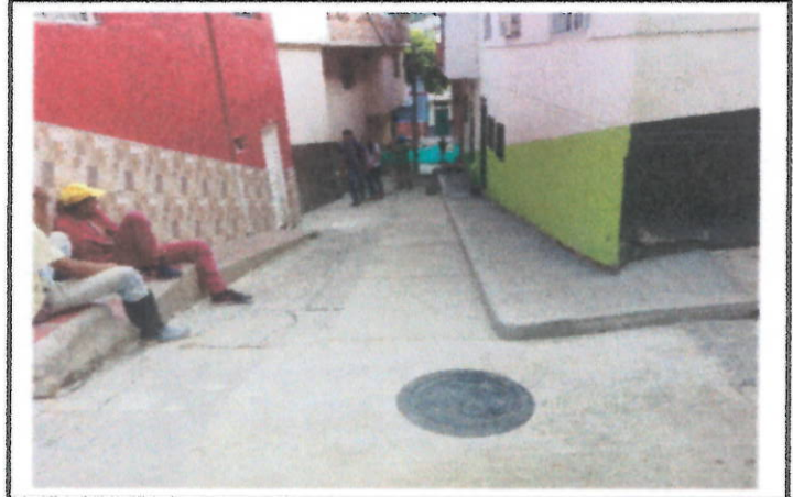
ASPECTO FINAL CALLE 10 CRA 3
