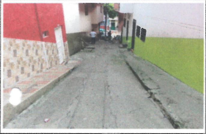
ASPECTO INICIAL CALLE 10 VIA PEATONAL
