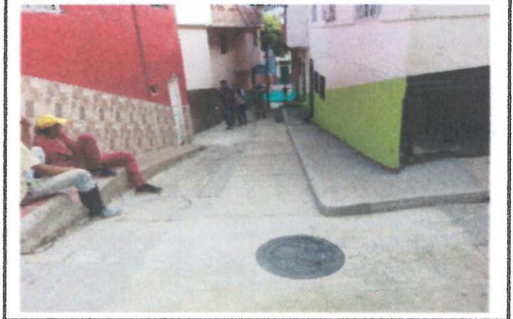
ASPECTO FINAL CALLE 10 CRA 3
