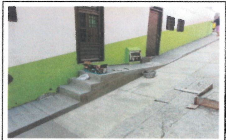
ASPECTO FINAL PEATONAL CALLE 10
