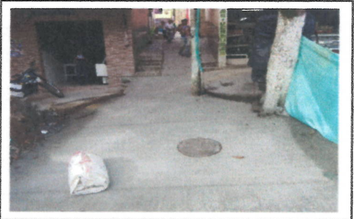
ASPECTO FINAL CALLE 10 CRA 4
