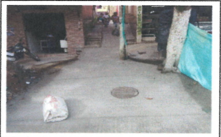
ASPECTO FINAL CALLE 10 CRA 4
