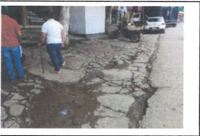
ASPECTO INICIAL CALLE 10 CRA 4 VIA HACIA MANIZALES
