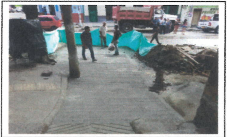
ASPECTO FINAL CALLE 10 CRA 4
