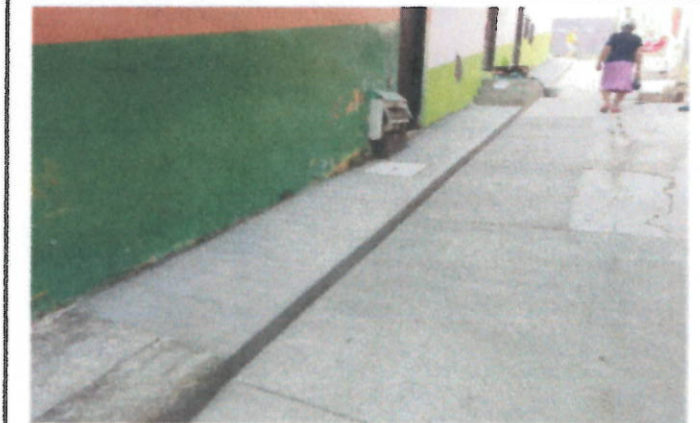
ASPECTO FINAL PEATONAL CALLE 10
