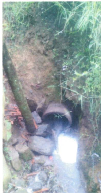
Foto 3 y 4. Tubería en concreto fallada y en mal estado.
