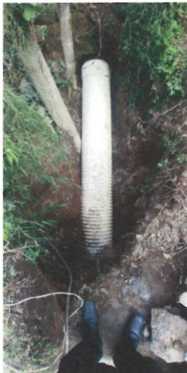
Foto 7. Instalación tubería Novafort de 20".
