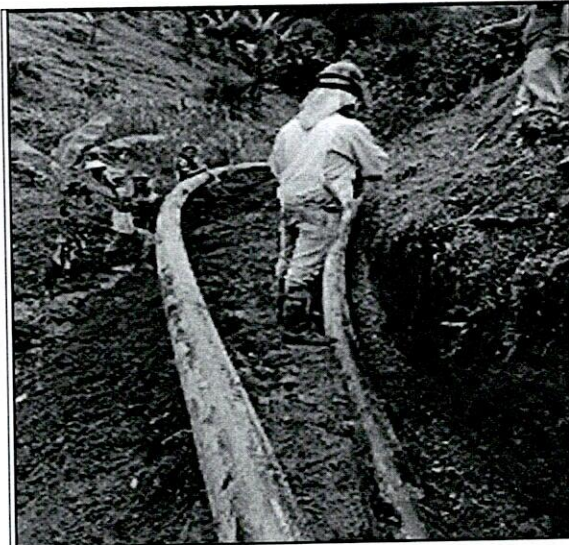
FOTO 1. SUMINISTRO, TRANSPORTE E INSTALACIÓN TUBERÍA PEAD PE 100 PN 10 200 MM 8"
