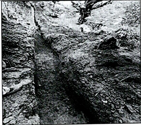
FOTO 4. Excavación en material común, Conglomerado - 0.0 a 3.0 Mt
