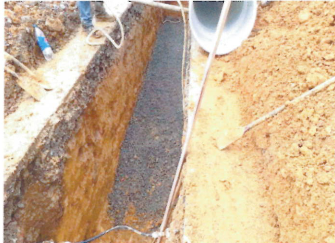
INSTALACION DE MATERIAL GRANULAR
