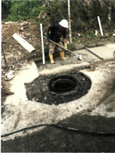
ACERO DE REFUERZO Y TAPA CON ARO
