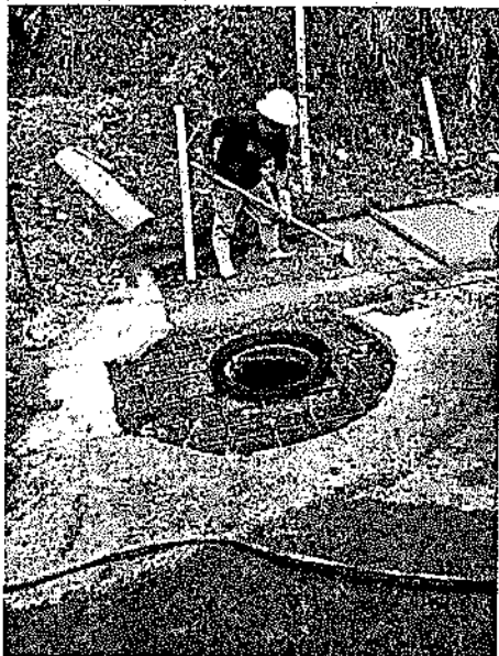
ACERO DE REFUERZO Y TAPA CON ARO
