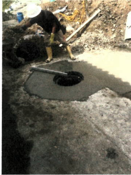
ACERO DE REFUERZO Y TAPA CON ARO
