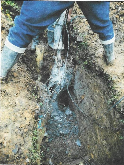
**FOTO 7.** Demolición de vigas de cimentación existentes encontradas en el terreno para poder instalar las tuberías
