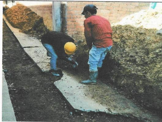
**FOTO 16.** Realización de nuevos cortes para acomodación de las fundiciones
