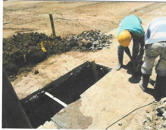
**FOTO 21.** Corte mecánico para recámara #4
