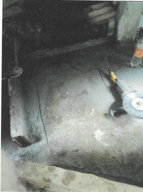
**FOTO 29.** Corte mecanizado para la caja domiciliaria dentro de la casa
