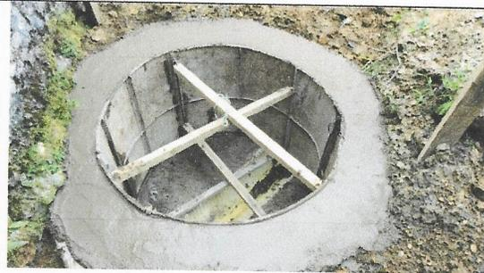
**FOTO 36.** Fundición de recámara # 3
