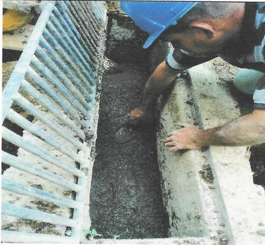
**FOTO 12.** Fundición de nuevo piso para imbornales existentes con nueva pendiente
