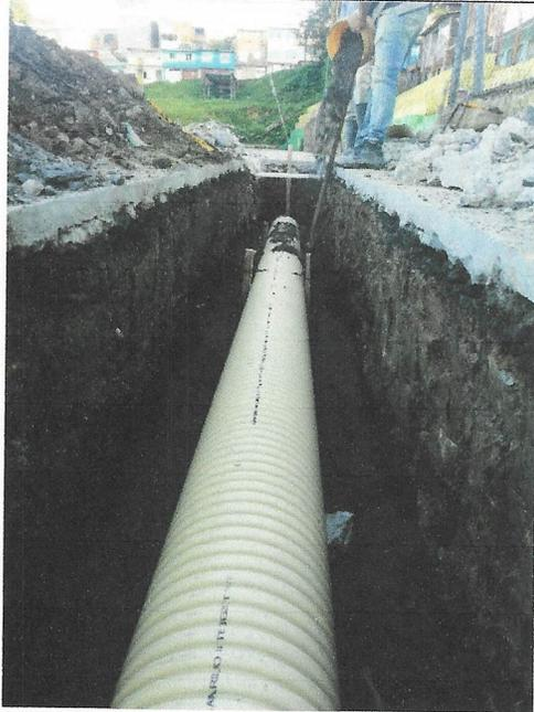
**FOTO 25.** Colocación de cama de arena por partes laterales en tubería
