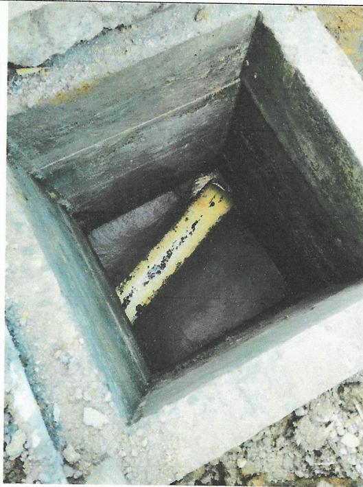
**FOTO 13.** Realización de base cañuela para caja de inspección al frente de la cancha sintética
