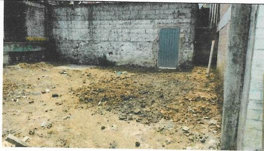
**FOTO 35.** Lleno de material en parte trasera del coliseo para dejar a buen nivel
