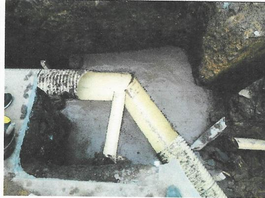
**FOTO 2.** Conformación final de la base de la recamara 2
