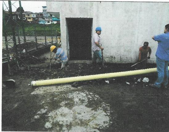
**FOTO 32.** Instalación de tubería de 6"
