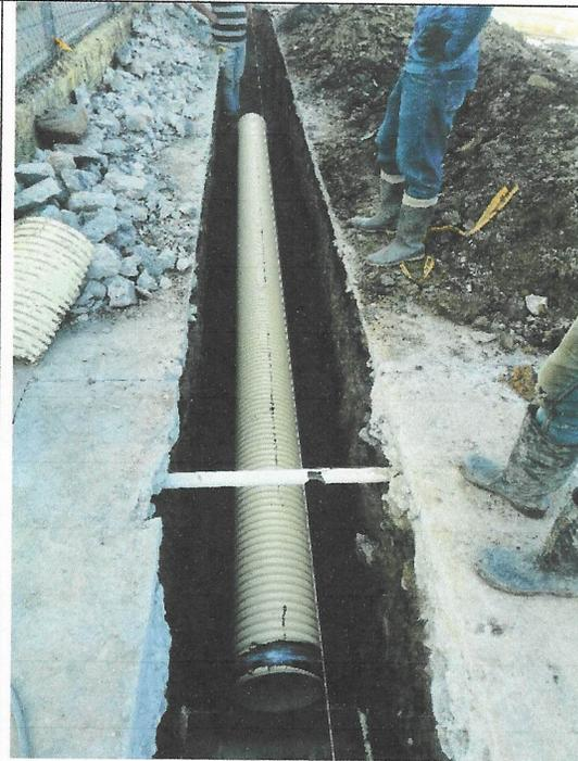
**FOTO 24.** Instalación de tubería de 12"
