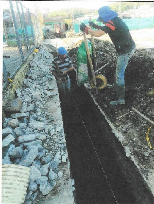
**FOTO 23.** Instalación de base en arena limpia para el acomodo de la tubería
