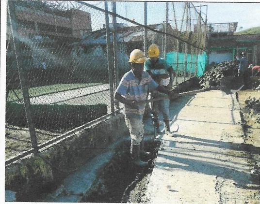
**FOTO 22.** Demolición de andén para instalación de tubería 10"
