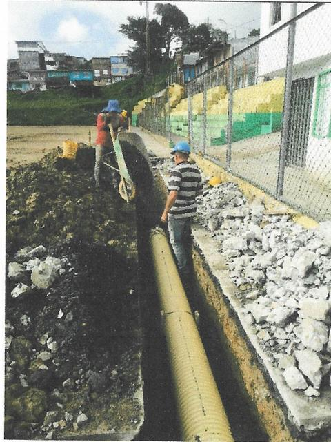
**FOTO 28.** Instalación de cama de arena
