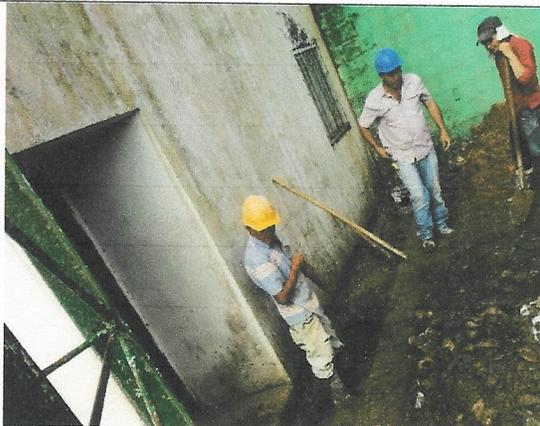
**FOTO 31.** Excavación para instalación de tubería de 6" conexión de caja domiciliaria dentro de casa
