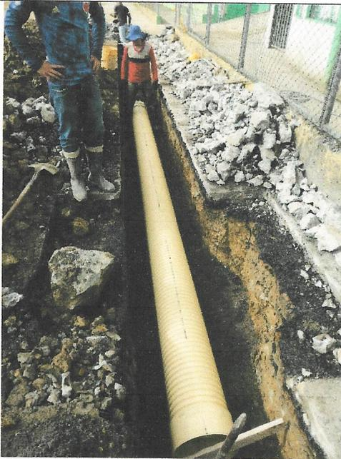
**FOTO 27.** Instalación de tubería de 12"
