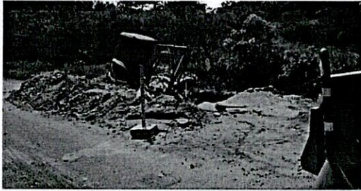
FOTO 3. Actividades de excavación hasta nivel de tubería para reparación. Nótese señalización
