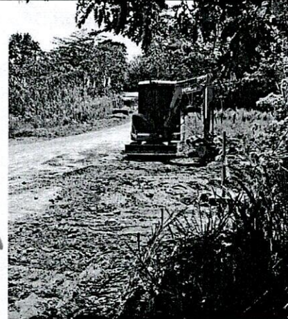
FOTO 4. Terminación de las actividades, lleno de la zona reparada
