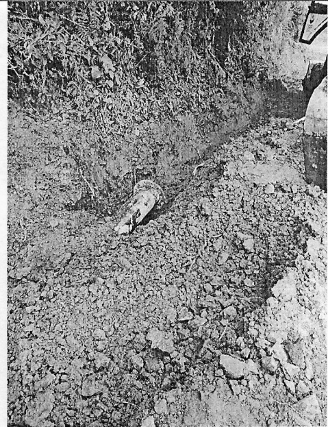
Reparación mediante la instalación de tubería de polietileno
