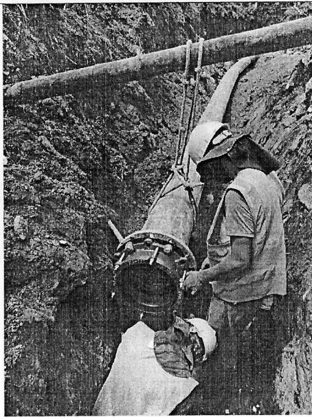
Reparación mediante la instalación de tubería de polietileno
