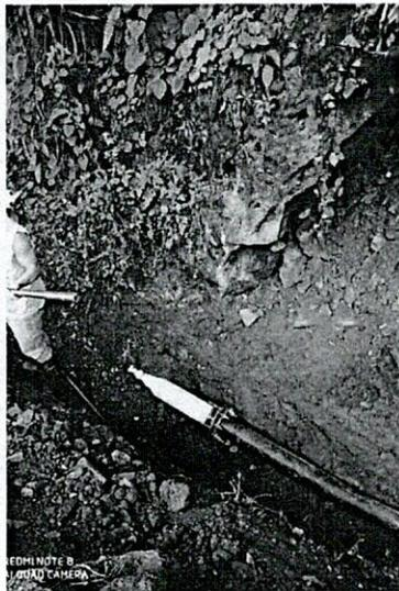
FOTO 9. Empalme No 1 a tubería existente
