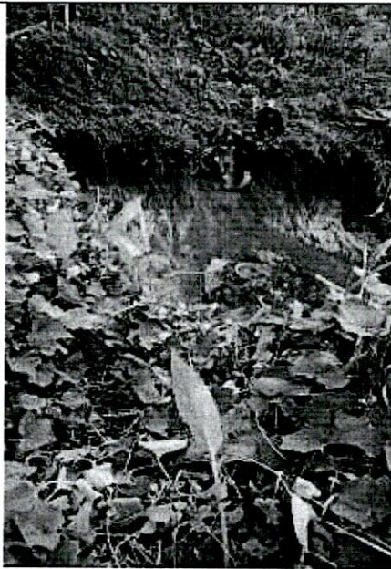
Fotos 1. Escarpe del deslizamiento ocasionado por ola invernal
