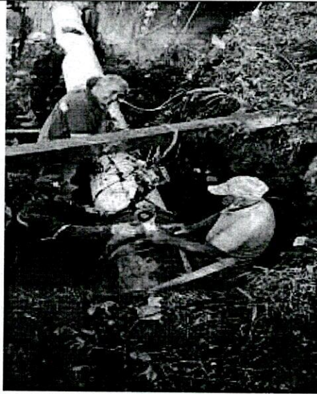
Imagen 3 Operación de la reparación de emergencia
