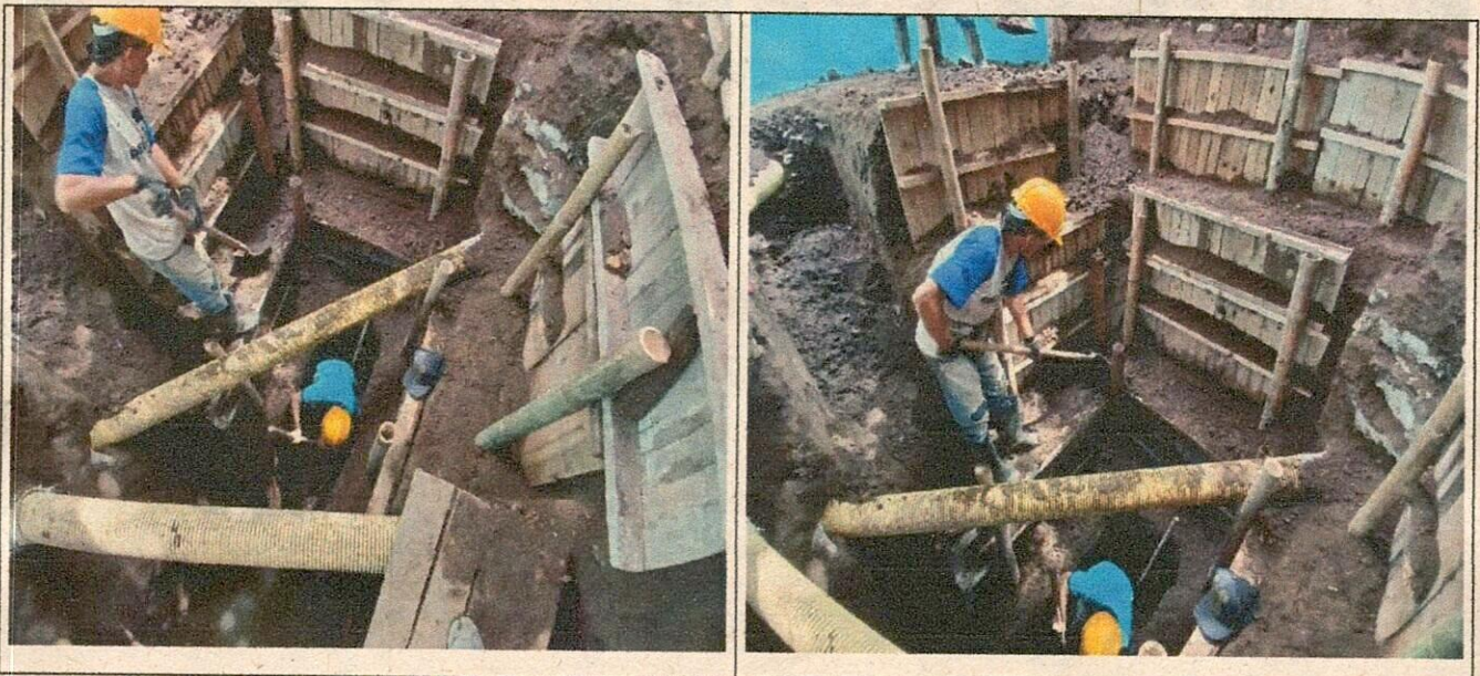
Entibados y extracción de lodos.
