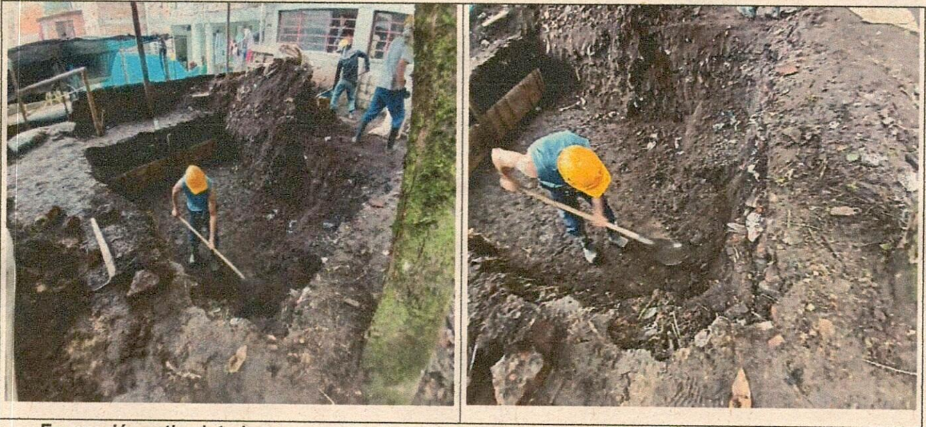
Excavación patios interiores.
