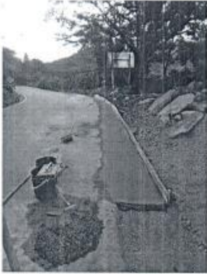
CONSTRUCCIÓN DE CUNETA SOBRE LA TUBERÍA PARA SU PROTECCIÓN
