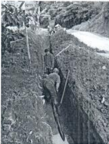
PROCESO DE LIBERACIÓN Y REPOSICIÓN DE TUBERÍA
