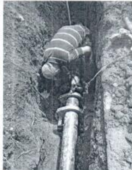
PROCESO DE LIBERACIÓN Y REPOSICIÓN DE TUBERÍA
