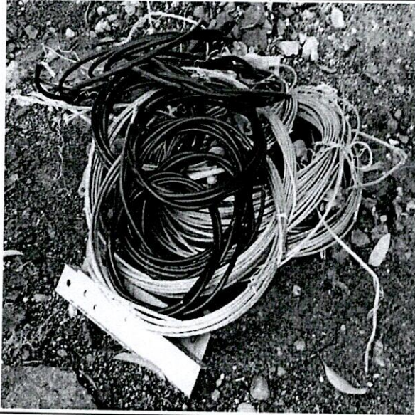
Fig. 1 y 2. Retiro cable ACSR No. 2 AWG y retiro herrajes de estructura primaria.
