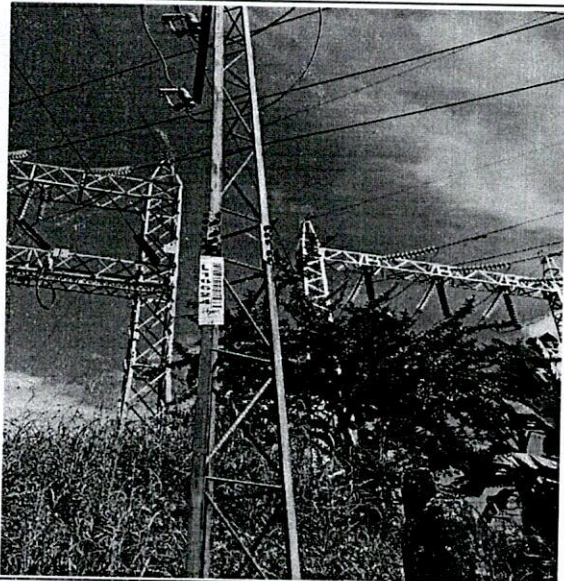
Fig. 3 y 4. Se comprueba estructura de arranque nodo L16624 y torres metálicas a sustituir.
