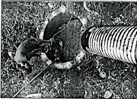
Perforaciones para anclajes
