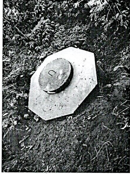
Vista final de la recámara intervenida con tapa en concreto
