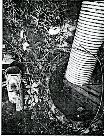
Adecuacion del hierro para realce
